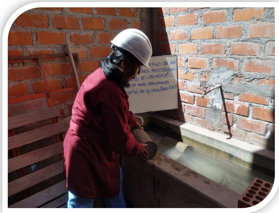
FOTO N° 11: Curado de briquetas
