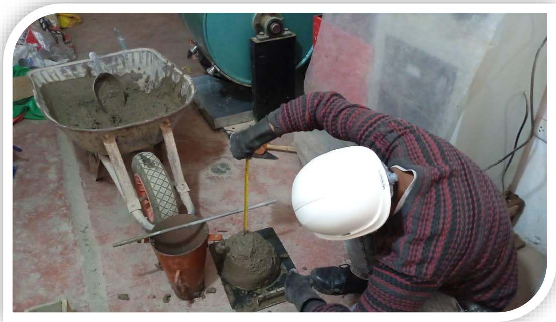
FOTO N° 7: Ensayo de Slump o cono de Abrams
