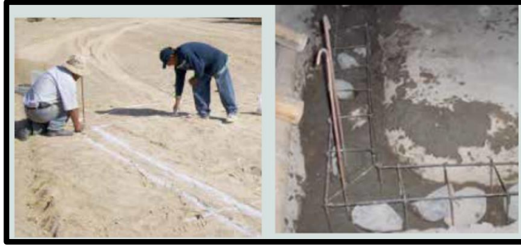
Figura 6. Trazo y cimentación.
