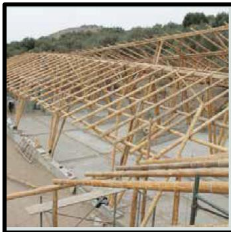
Figura 21. Colocación de correas.
