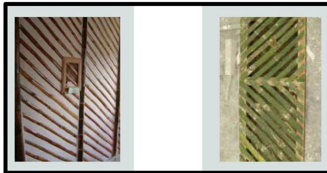
Figura 17. Muro panel romero y muro paneles varios.
