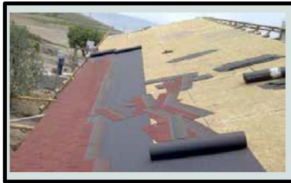
Figura 23. Cubierta tipo asfaltico sobre panel de madera
