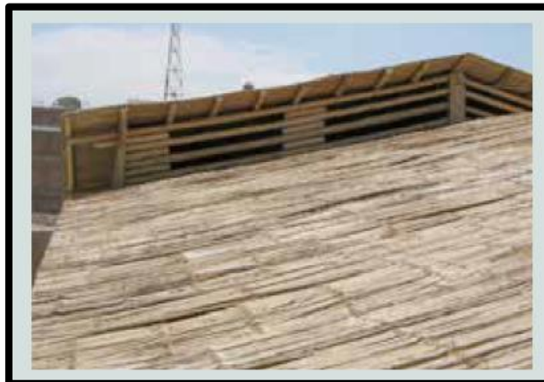
Figura 24. Cubierta de cañas de bambú.
