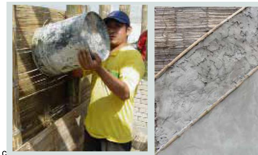
Figura 15. Llenado y recubrimiento de muro portante.
