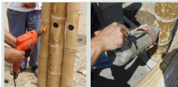
Figura 13. Llenado de mortero para fijar columna con cemento.
