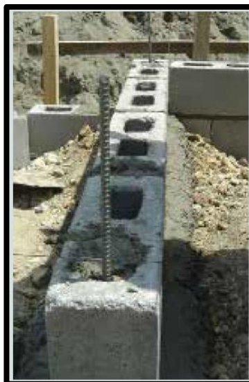
Figura 7. Sobrecimiento y fierro de construcción para conectar columna.
