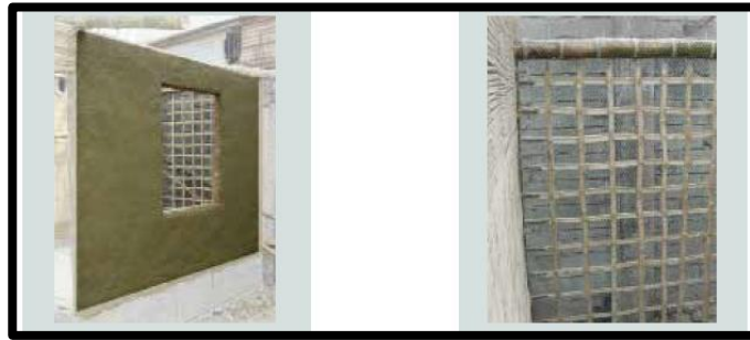
Figura 16. Muro de quincha y muro Iperti.
