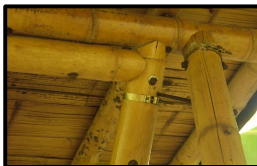
Figura 18. Ejemplo de fijado de viga en columna.
