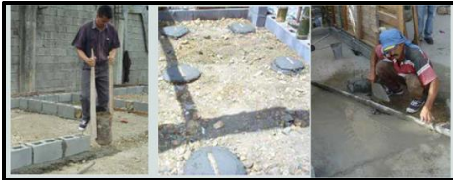
Figura 8. Compactación, nivelación y llenado de piso.
