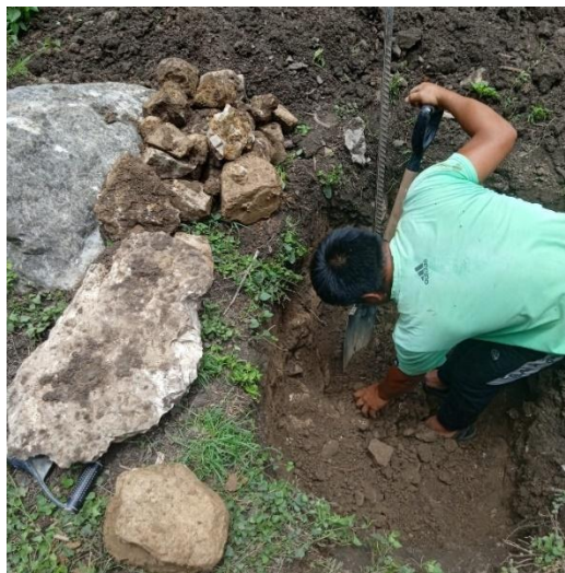
Figura 37. Calicata, se observa el tipo de material que tiene el suelo.
