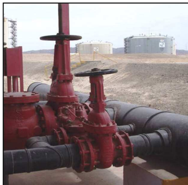
Figura 16. Válvula de recirculación
