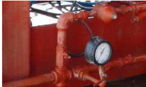
Figura 15. Manómetro de succión y salida
