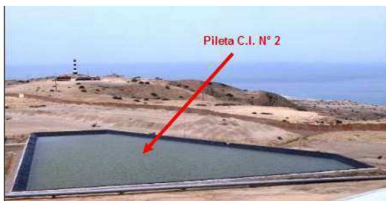
Figura 6. Ubicación de la pileta 2.
