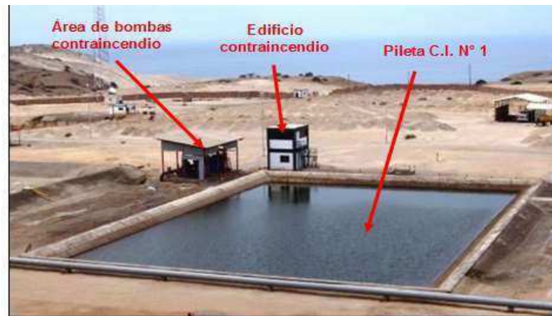
Figura 5. Ubicación de la pileta 1.
