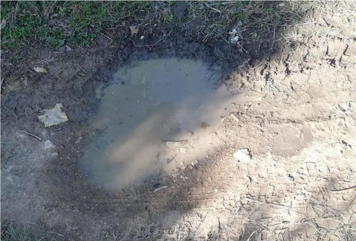
**Figura 18. Daño 3: Huecos - Nivel de gravedad 1**
