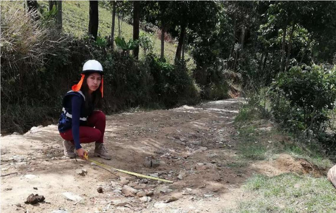
**Figura 11. Daño 2: Erosión - Nivel de gravedad 2**
