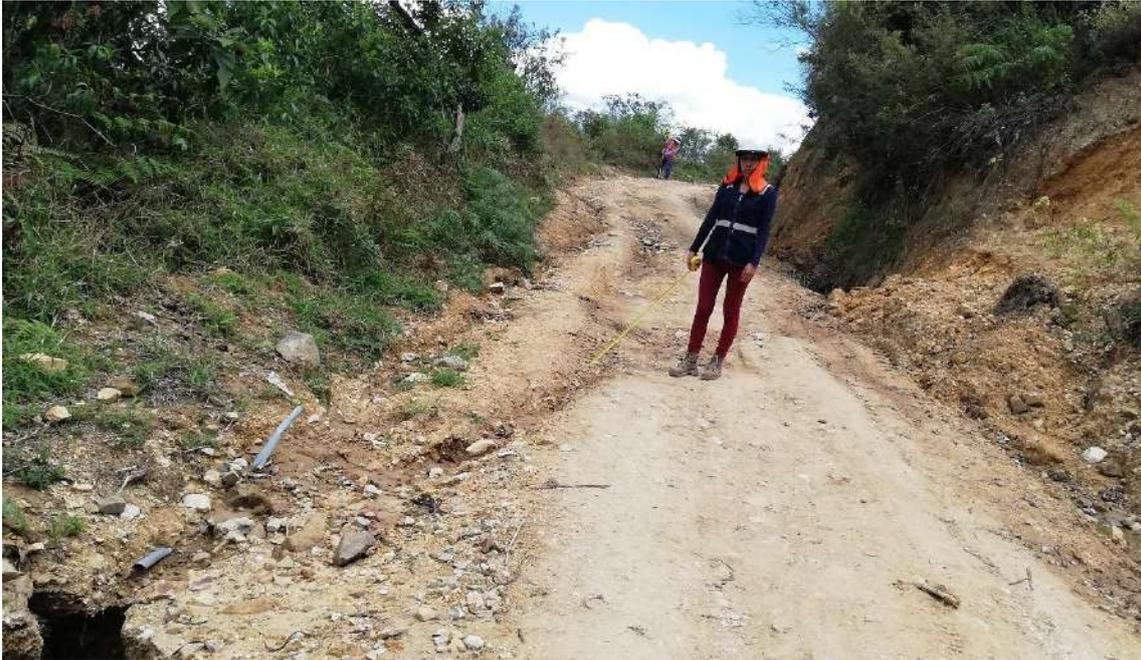
**Figura 13.** Daño 2: Erosión - Nivel de gravedad 1
