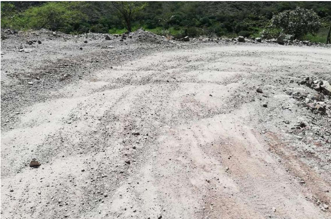
**Figura 22.** Daño 4: Encalaminado - Nivel de gravedad 1
