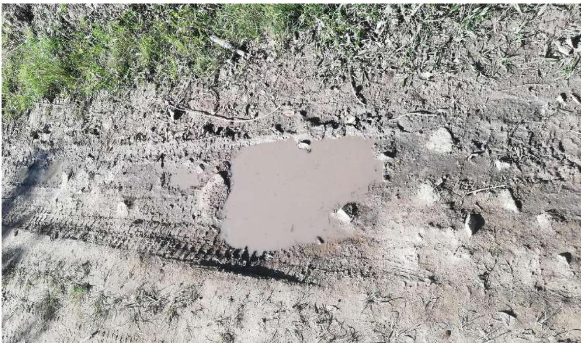
**Figura 20. Daño3: Huecos - Nivel de gravedad: 3**
