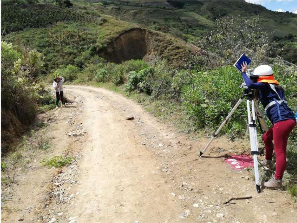
**Figura 9:** Nivelación del prisma.
