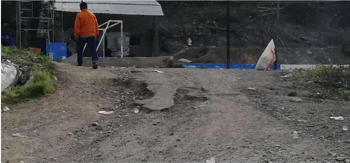
*Figura 9. Daño 1: Deformación - Nivel de gravedad 1*
