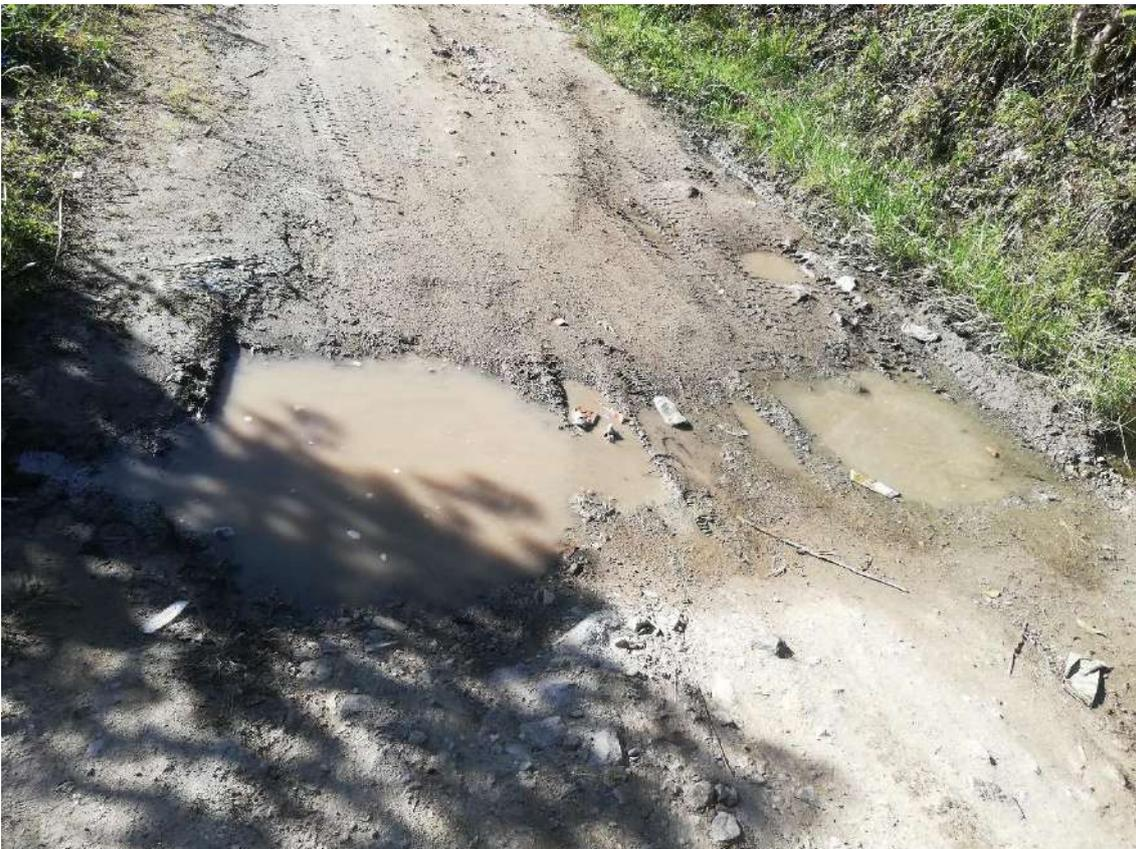
**Figura 17. Daño 3: Huecos - Nivel de gravedad 1**
