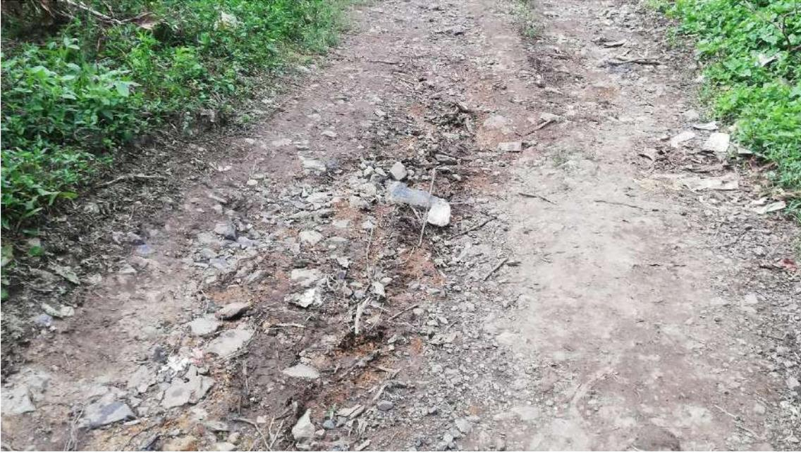
**Figura 16. Daño 3: Huecos - Nivel de gravedad 2**
