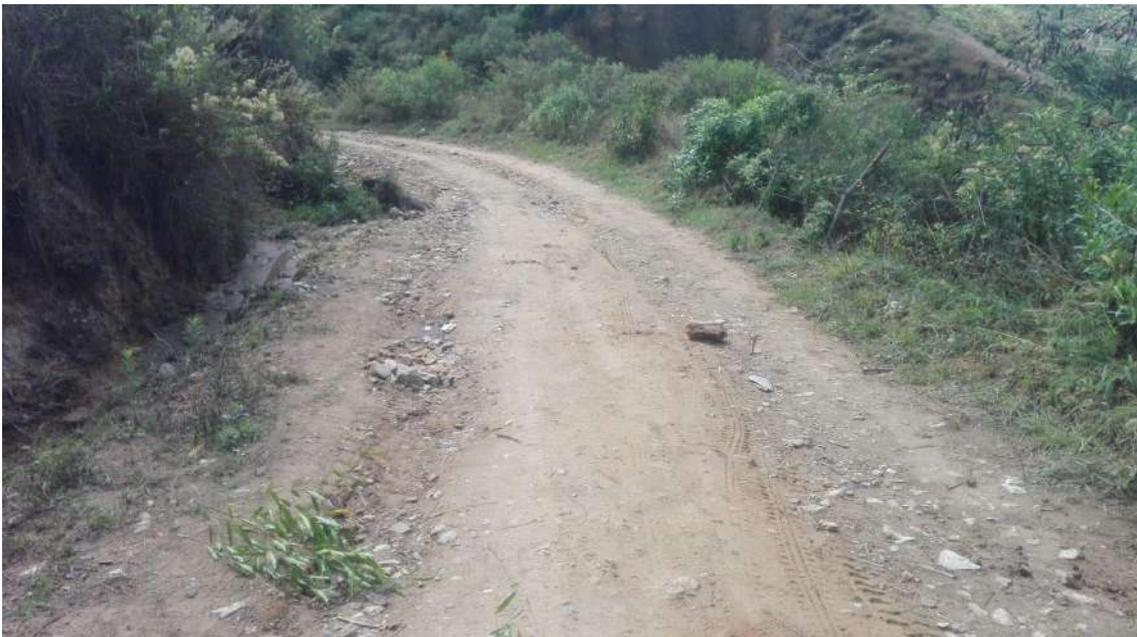
**Figura 12. Daño 1: Deformación - Nivel de gravedad 2**
