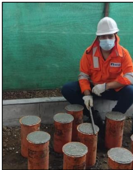
Figura 55. Elaboración de probetas de concreto
