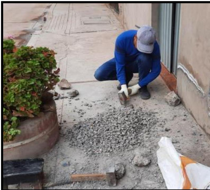
Trituración del agregado reciclado a un tamaño de  $\frac{3}{4}$ "
