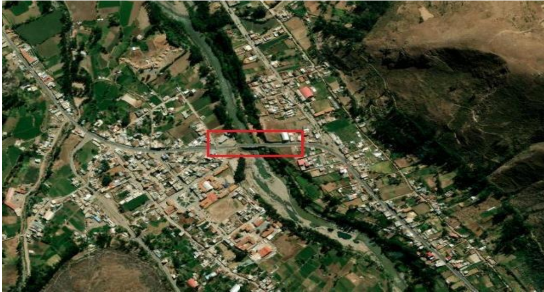
FIGURA 3: ubicación del puente Jangas
