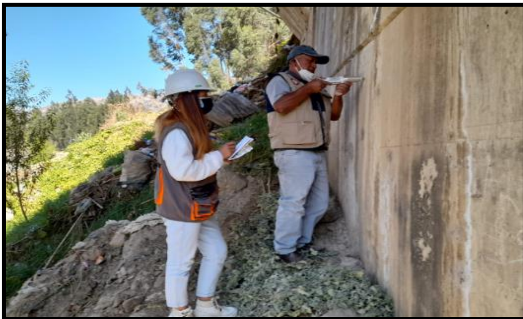
Fotografía 04: toma de datos del ensayo del esclerómetro.
