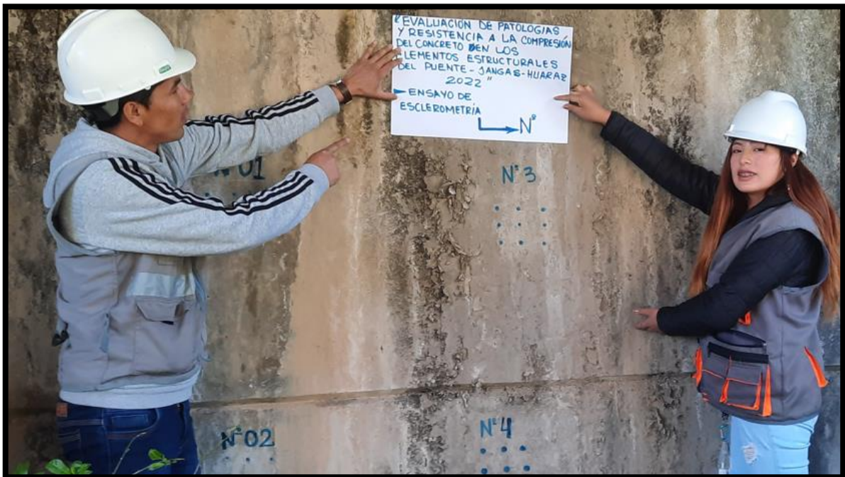
Fotografía 06: colocación de puntos en el ensayo del esclerómetro.
