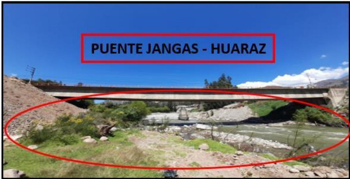
FIGURA 2: Tramo del puente a Evaluar.
