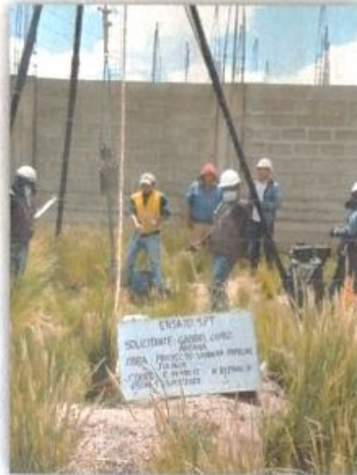
FOTO 01: Realizando el ensayo de penetración estándar (SPT) ASTM D-1586, coordenadas E373980.12 N8284162.71
