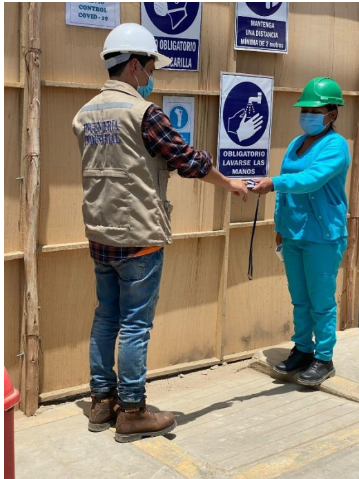
Figura 5. Tesista durante el recorrido en obra
