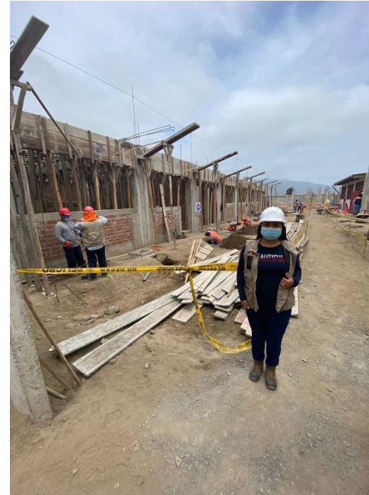
Figura 6. Tesista durante el recorrido en obra
