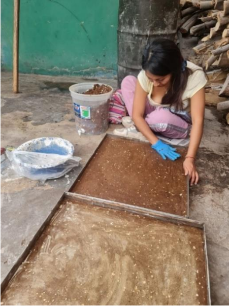
Ilustración 9: Preparación de las barreras acústicas
