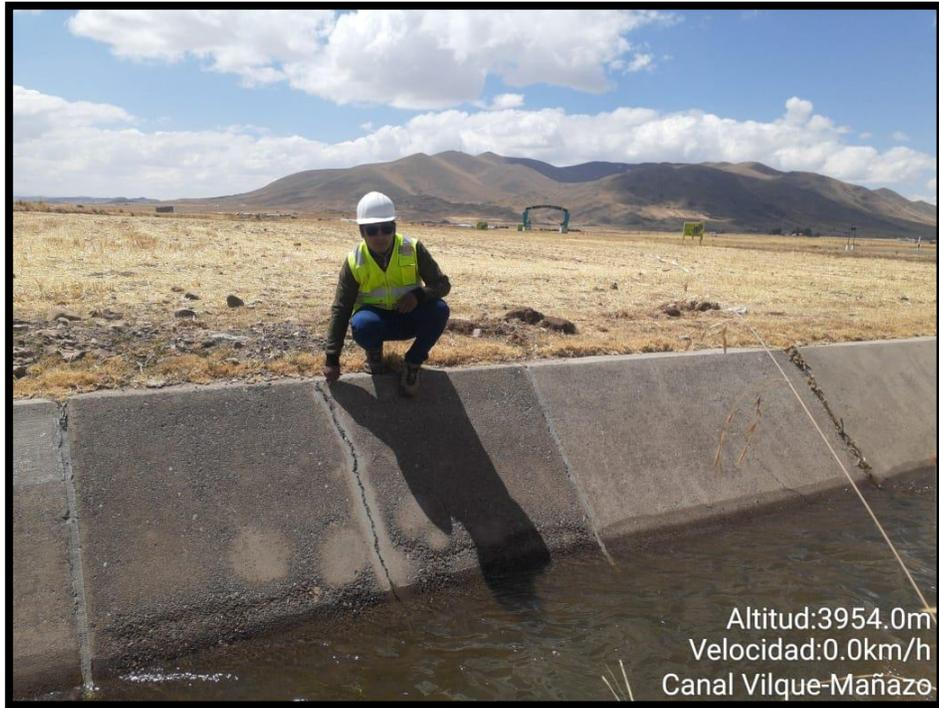
Fotografía N°1 Fisuras encontradas del canal entre Vilque – Mañazo
