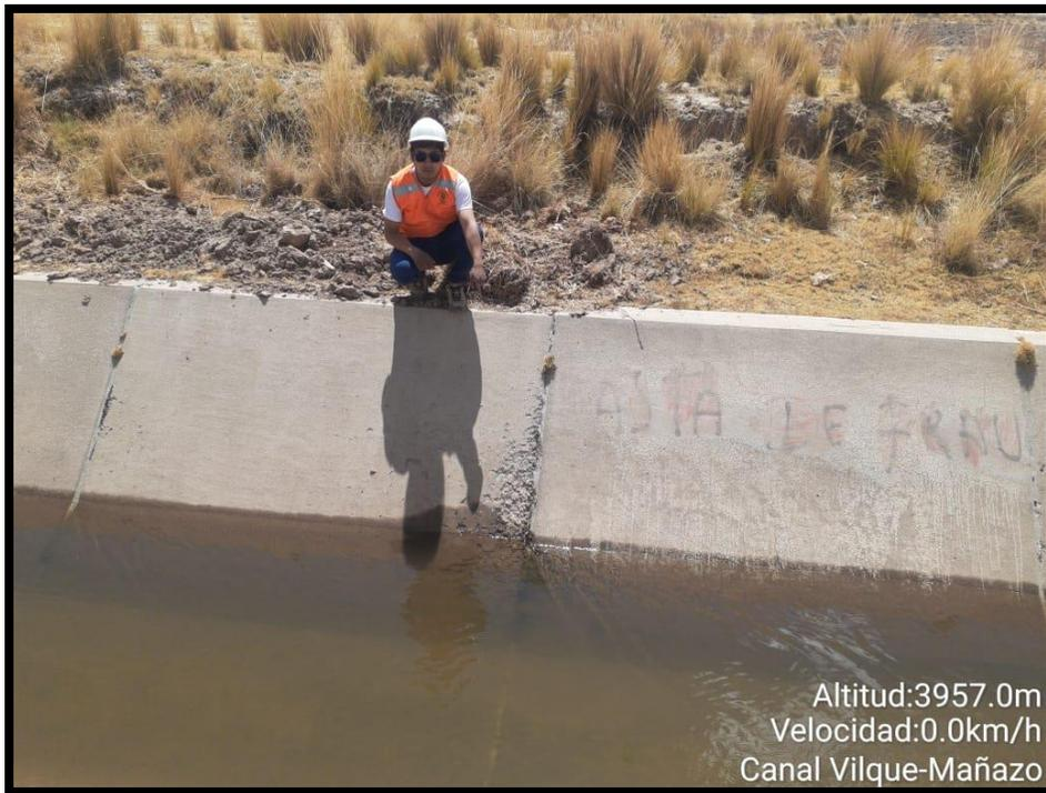
Fotografía N°2 Fisuras encontradas del canal entre Vilque - Mañazo
