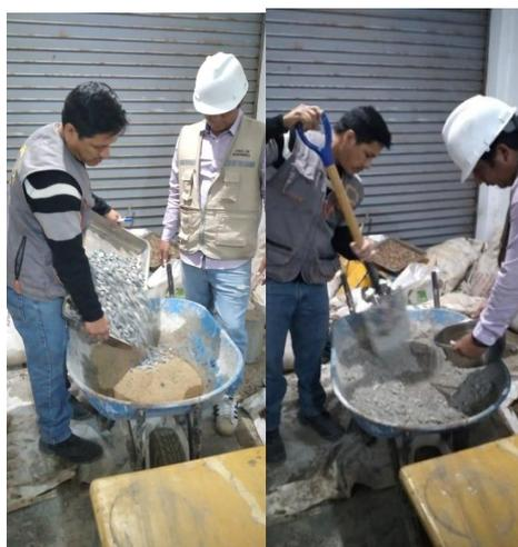
*Figura 8.* Preparación de mezcla de concreto ordinario C21 (margen izquierdo) y C28 (margen derecho)
