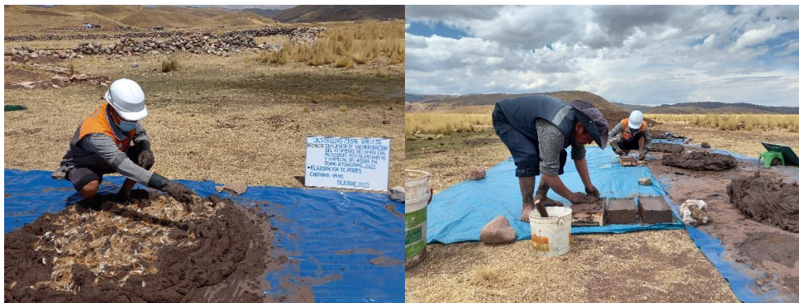
Figura 10. Fabricación de los adobes
