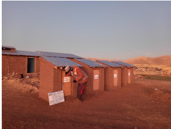
Figura 15. Medición de temperaturas en los módulos de adobe
