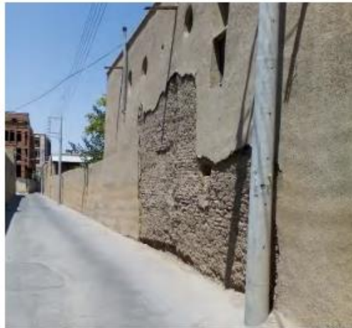
Figura 2. Disgregación de partículas producto de la capilaridad y succión del adobe.
