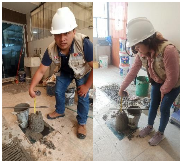
Figura 28. Ensayo de Asentamiento
