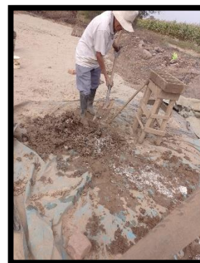
Fotografía 6: Elaboración de ladrillo artesanal
