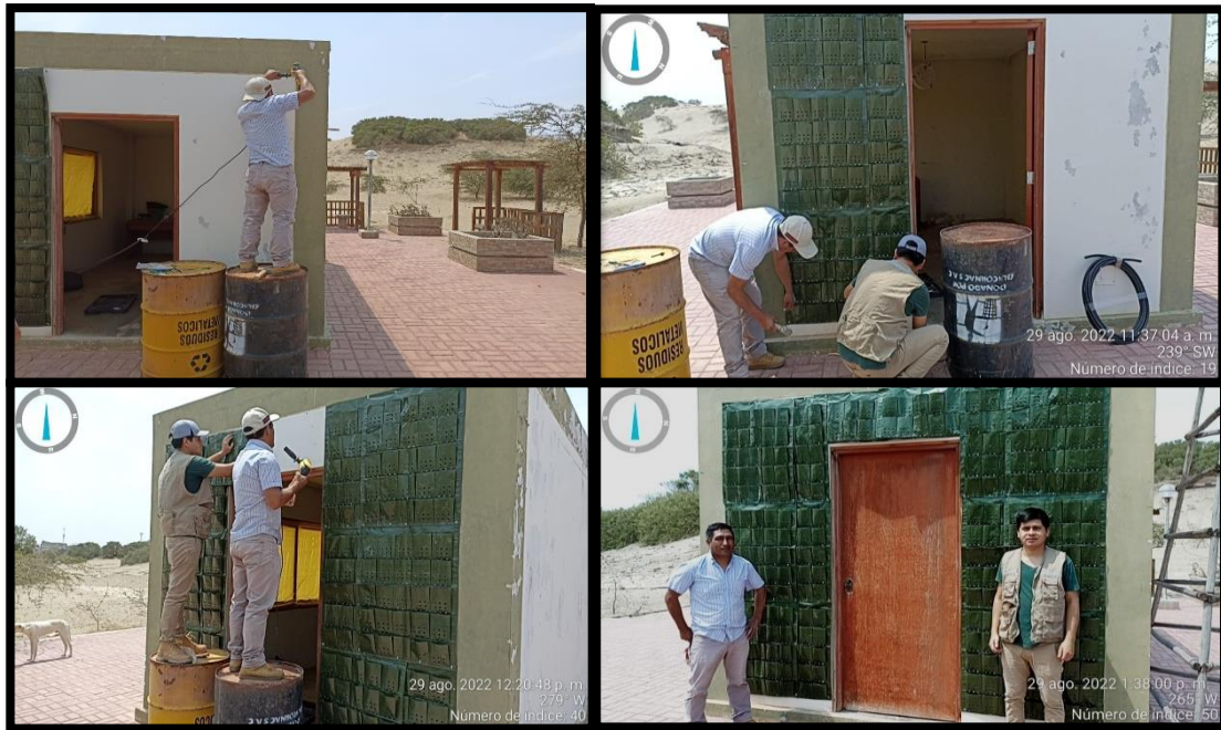
Figura 7: Construcción de la cubierta vegetal
