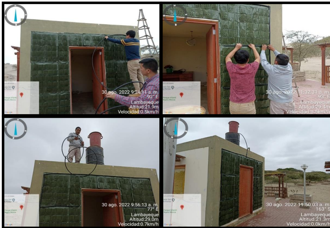
Figura 8: Instalación del riego por goteo
