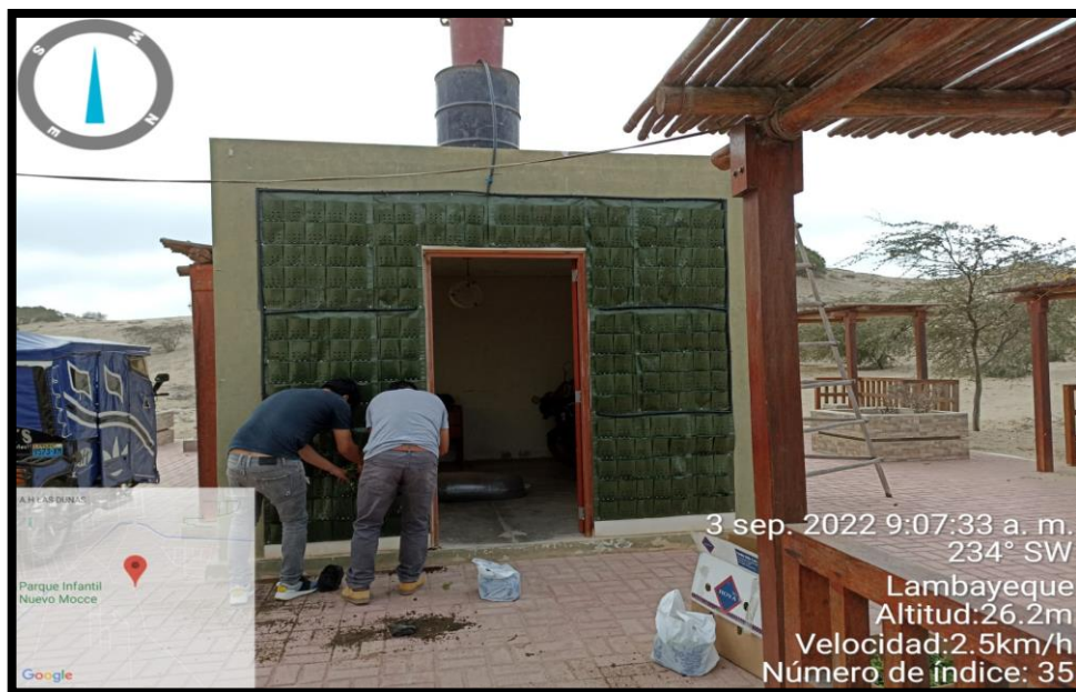
Figura 10: Llenado del sustrato en los bolsillos de mantas
