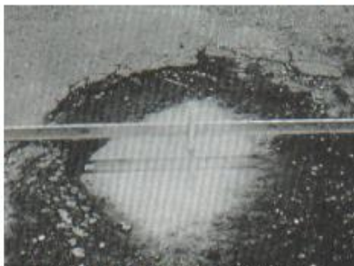
Figura A13-c. Huevo de severidad alta.
