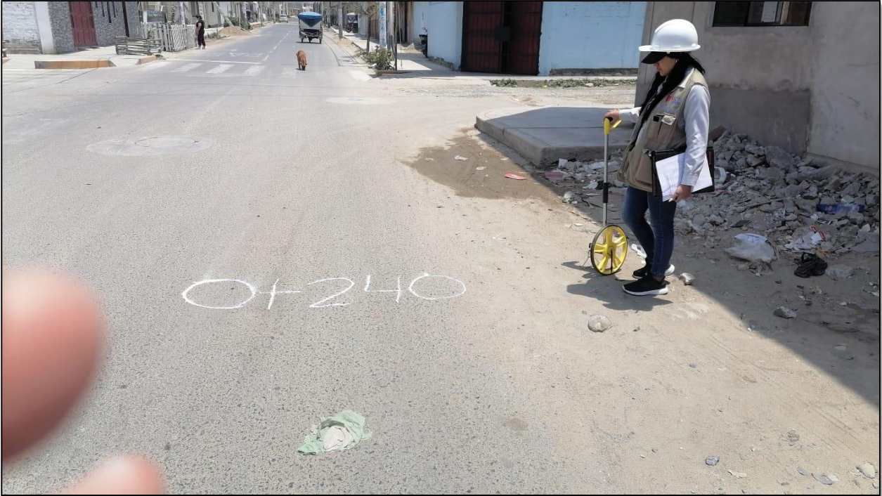
Fotografía 5. Progresiva 0+240 en pueblo joven (PPAO)
