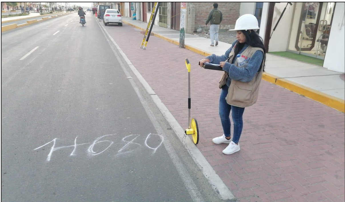
Fotografía 25. Progresiva 1+680 en la avenida A
