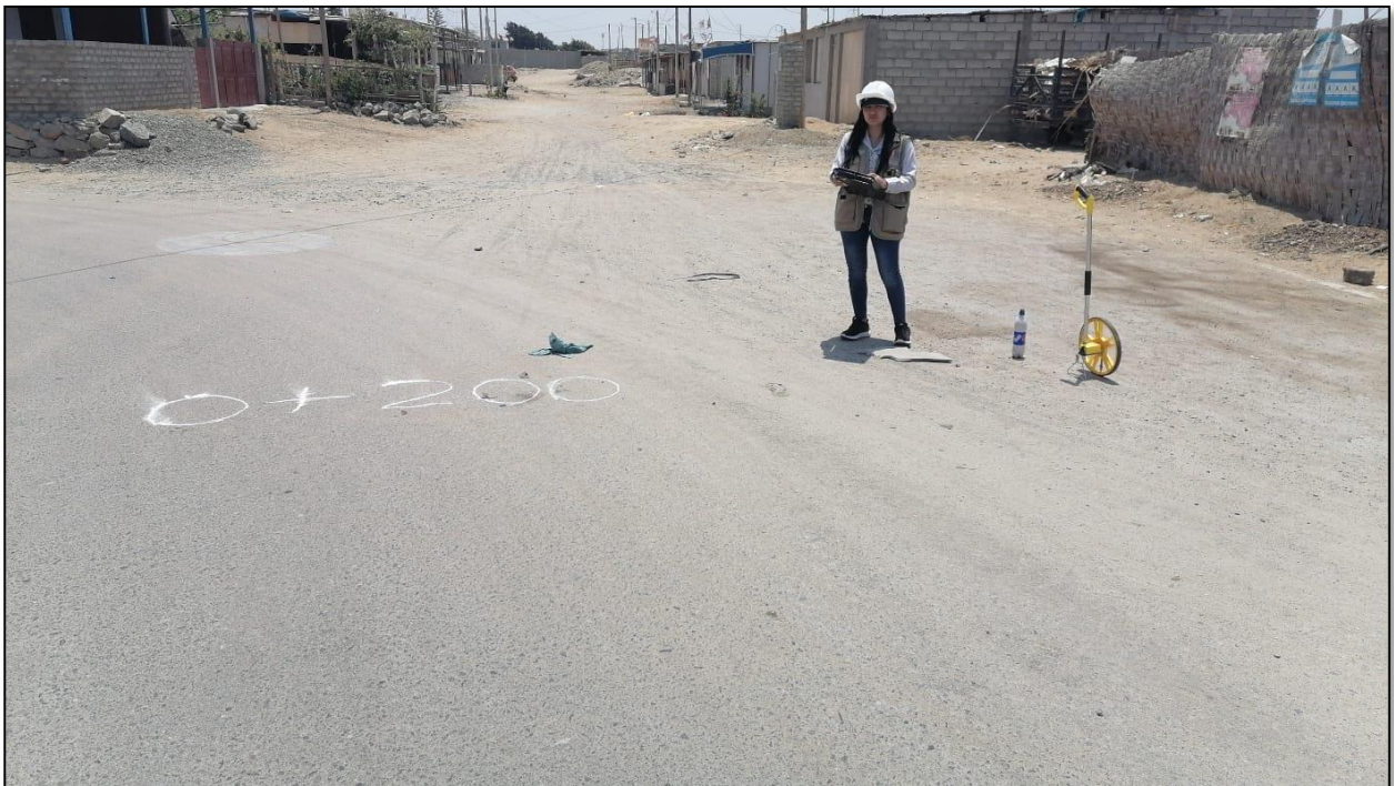
Fotografía 4. Progresiva 0+200 en pueblo joven (PPAO)
