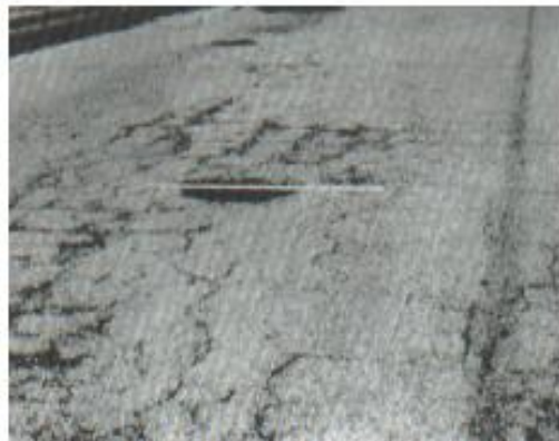
Figura A13-b. Huevo de severidad media.
