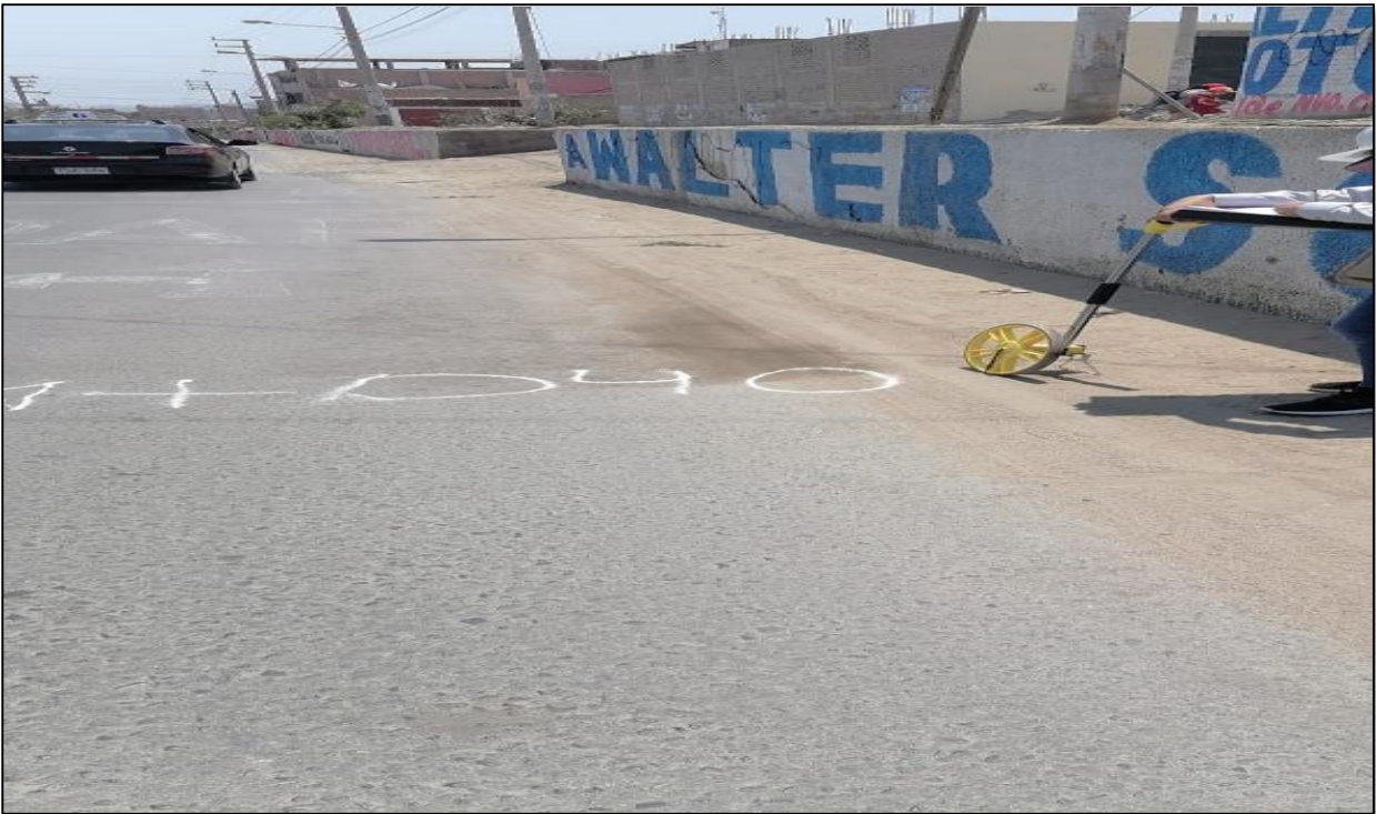
Fotografía 13. Progresiva 1+040 en pueblo joven (PPAO)
