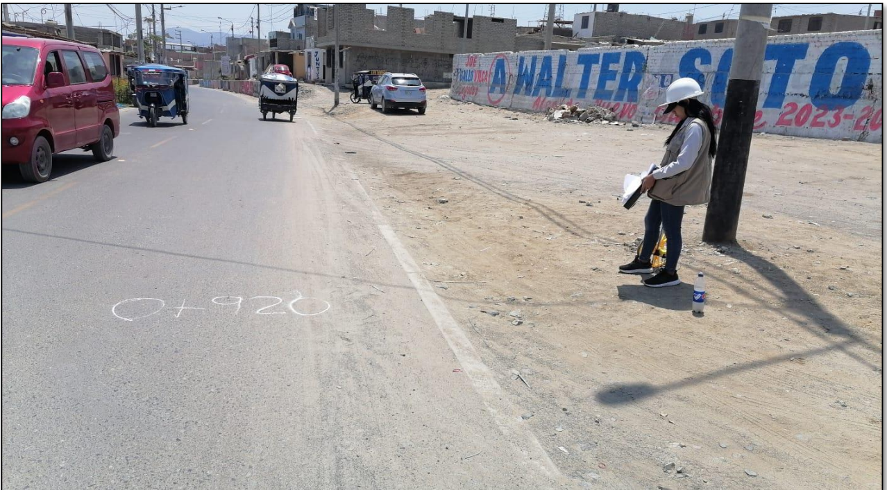
Fotografía 12. Progresiva 0+920 en pueblo joven (PPAO)
