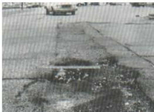
Figura A11-c. Parcheo y acometidas de servicios públicos de alta severidad.
