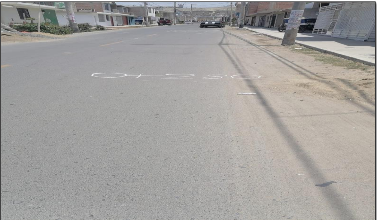
Fotografía 6. Progresiva 0+280 en pueblo joven (PPAO)
