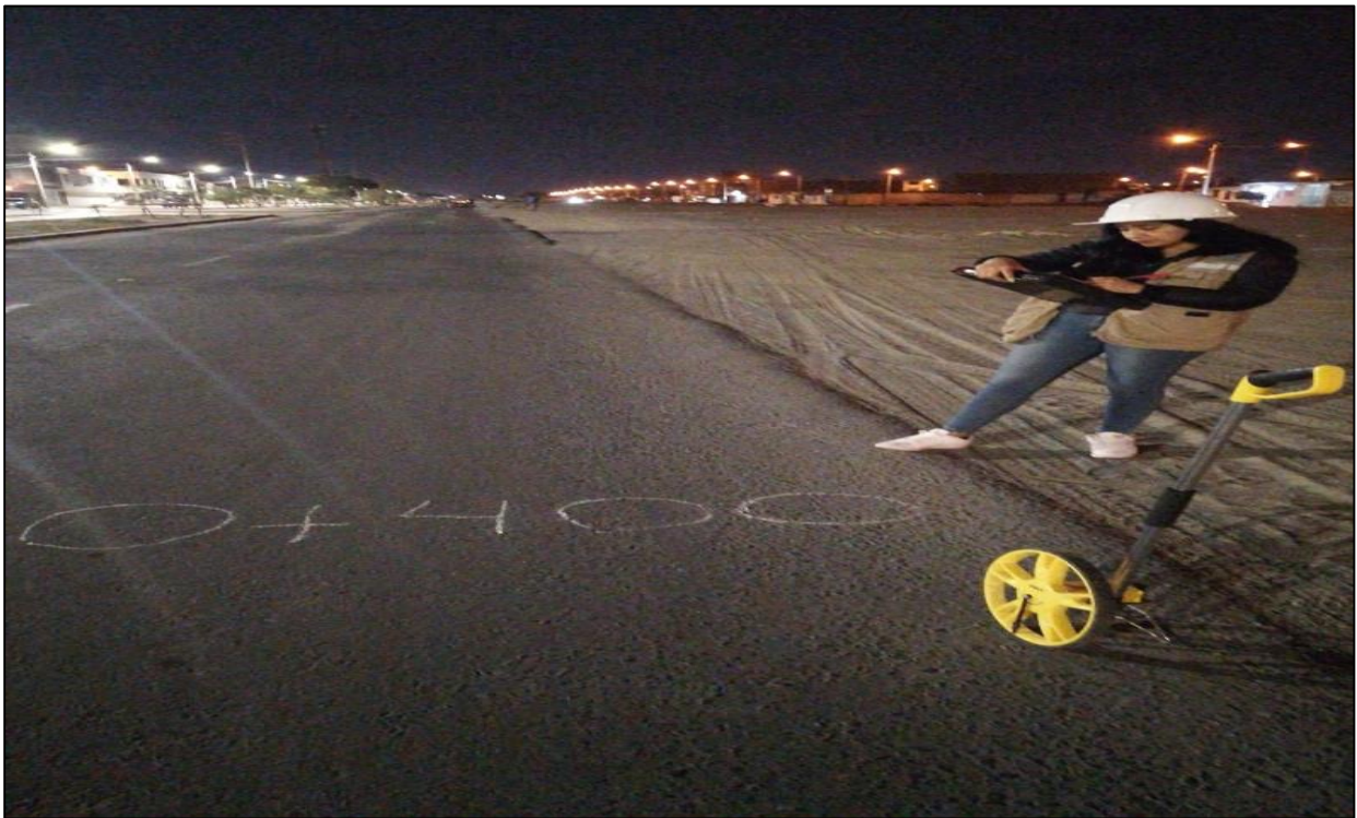
Fotografía 39. Progresiva 0+400 en la avenida Central
