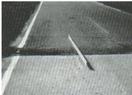
Figura A16-c. Desplazamiento de severidad alta.
