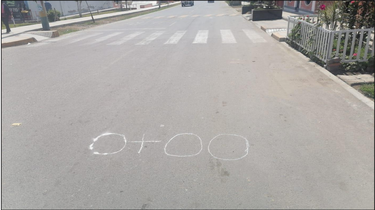
Fotografía 1. Progresiva 0+000 en pueblo joven (PPAO)
