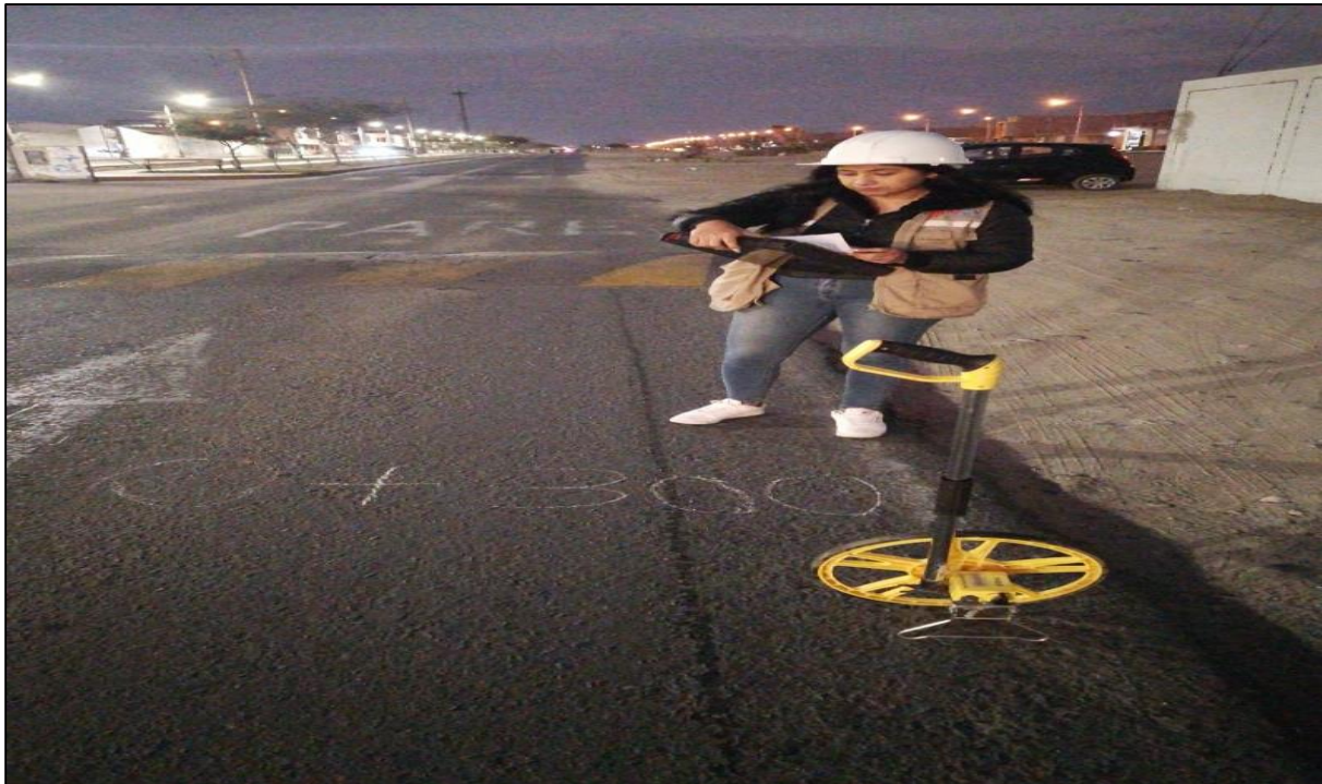
Fotografía 37. Progresiva 0+300 en la avenida Central
