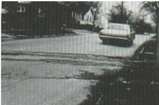
Figura A14-c. Cruce de vía férrea de severidad alta.
