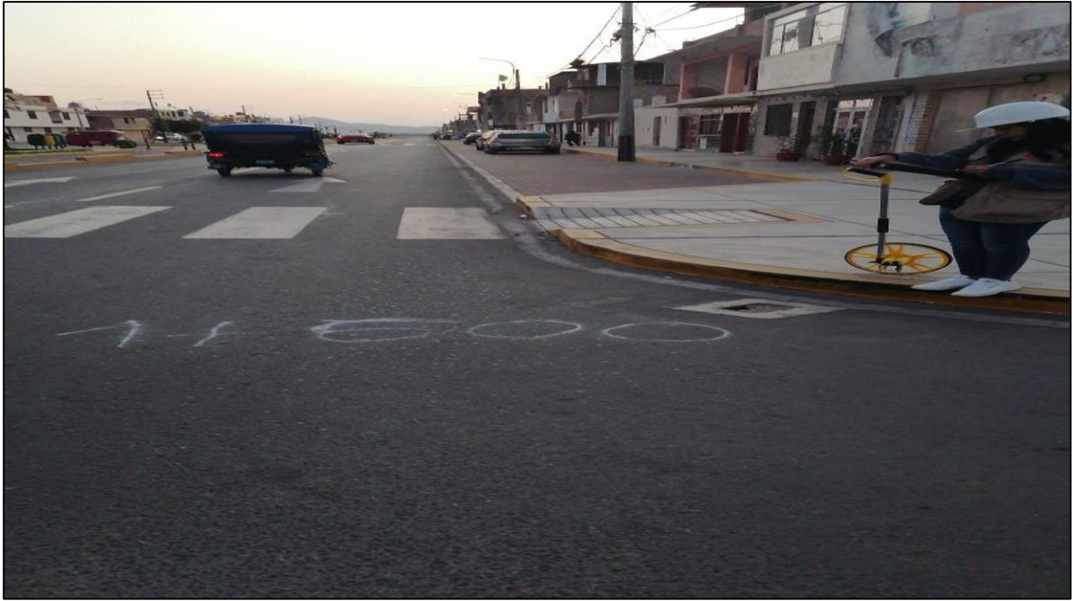
Fotografía 24. Progresiva 1+600 en la avenida A
