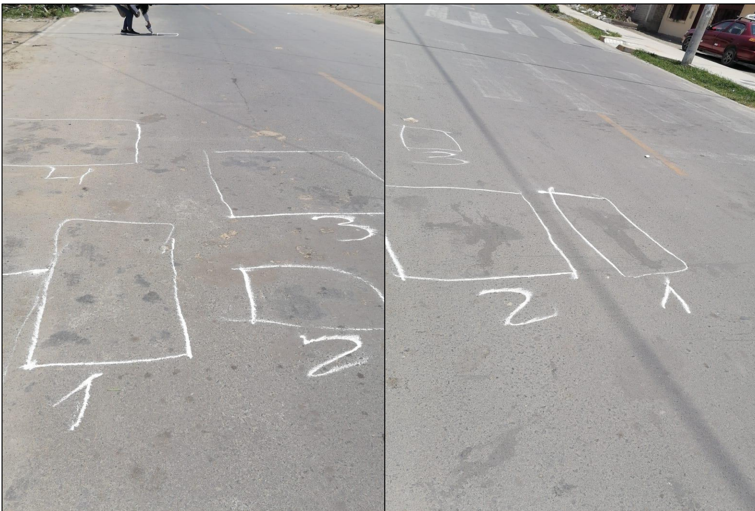
Fotografía 15. Fallas por exudación con nivel de severidad bajo en el pavimento del pueblo joven (PPAO)
