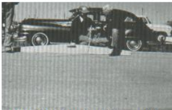
Figura A6-a. Depresión de baja severidad.
