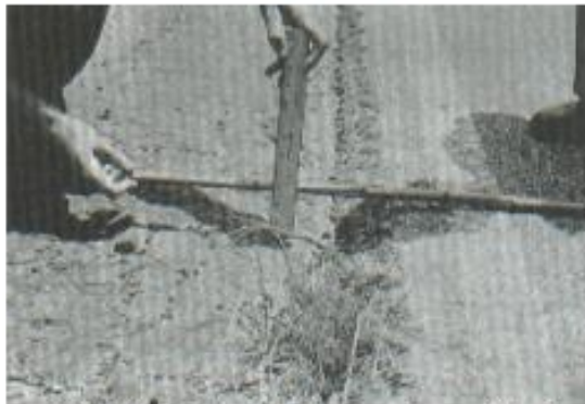
Figura A9-b. Desnivel carril / berma de severidad media.
