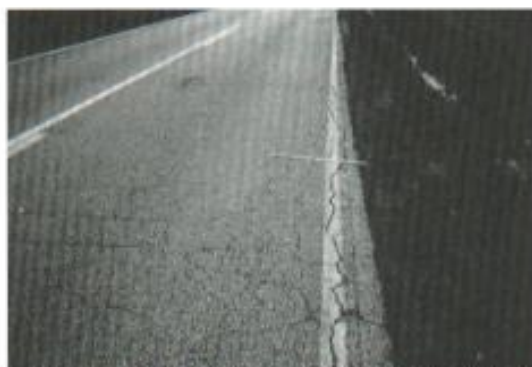
Figura A1-b. Piel de cocodrilo de severidad media.
