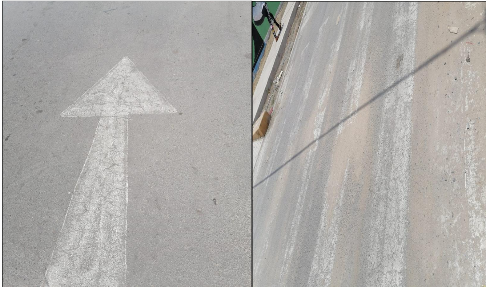
Fotografía 15. Fallas por piel de cocodrilo con severidad baja en el pavimento del pueblo joven (PPAO)
