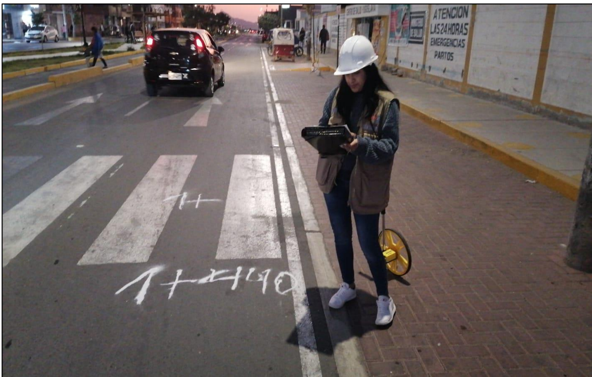
Fotografía 21. Progresiva 1+440 en la avenida A
