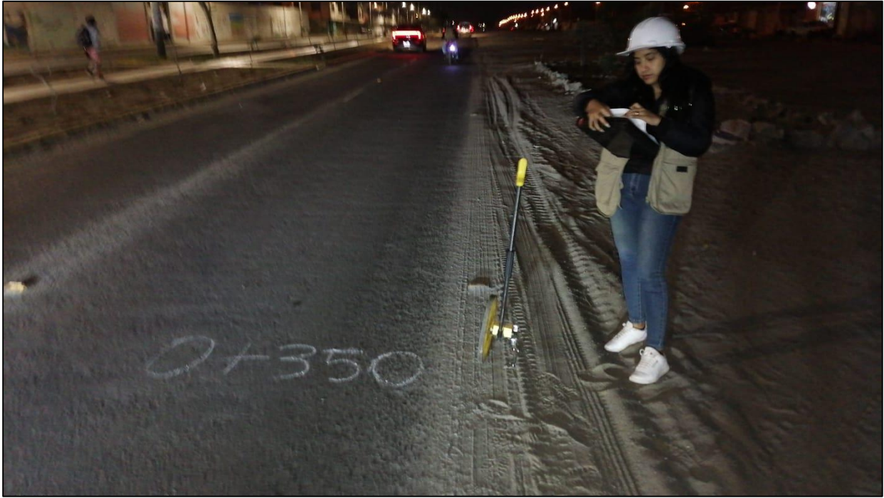
Fotografía 38. Progresiva 0+350 en la avenida Central
