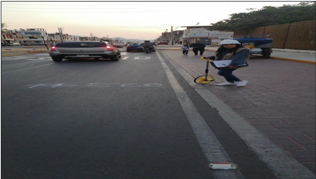
Fotografía 23. Progresiva 1+560 en la avenida A
