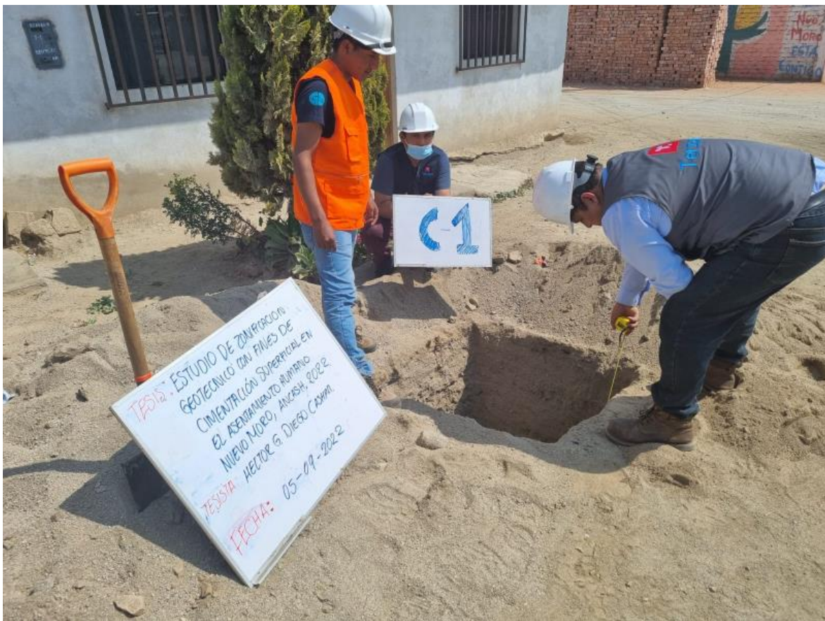
FOTO 02: verificación de la profundidad de la calicata C-01.
