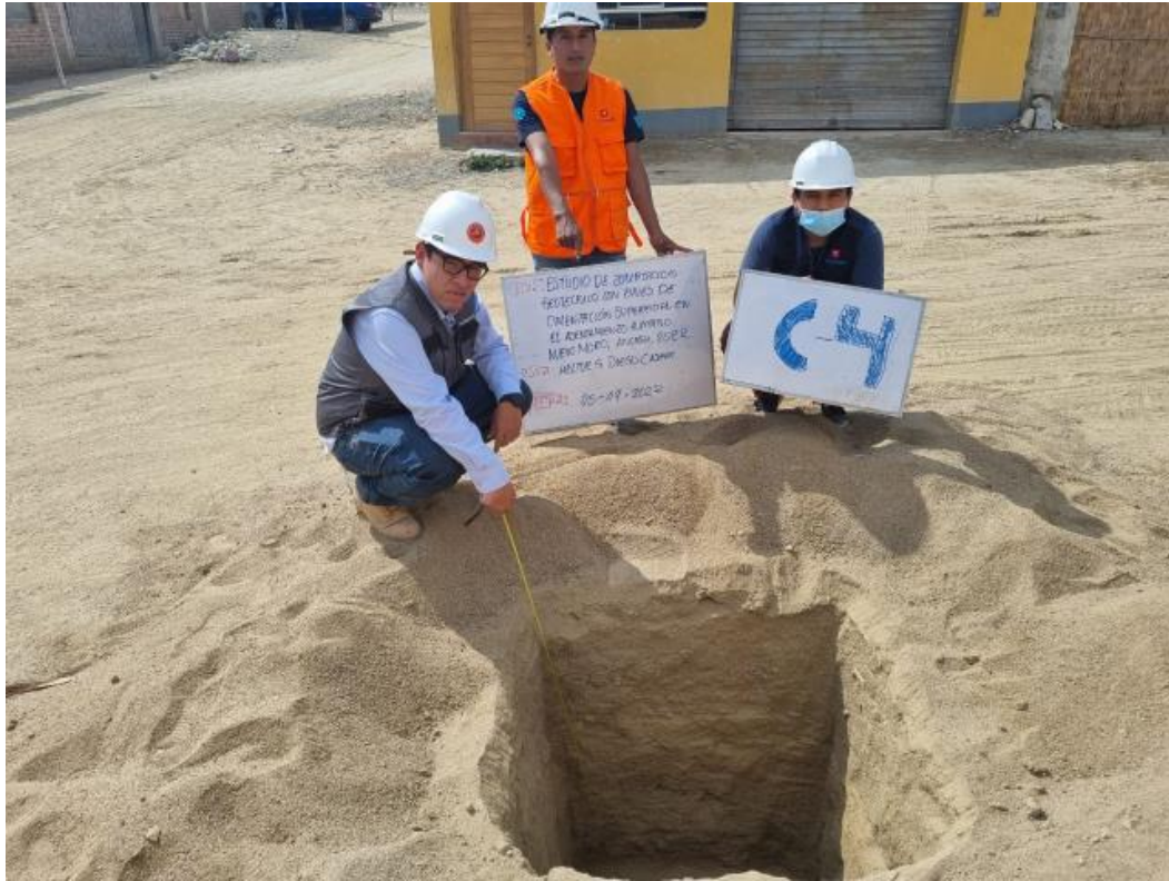
FOTO 03: verificación de la profundidad de la calicata C-04
