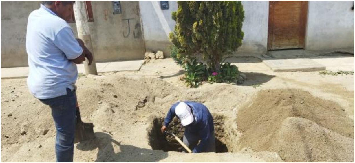
FOTO 01: Inicio de excavación de calicatas.
