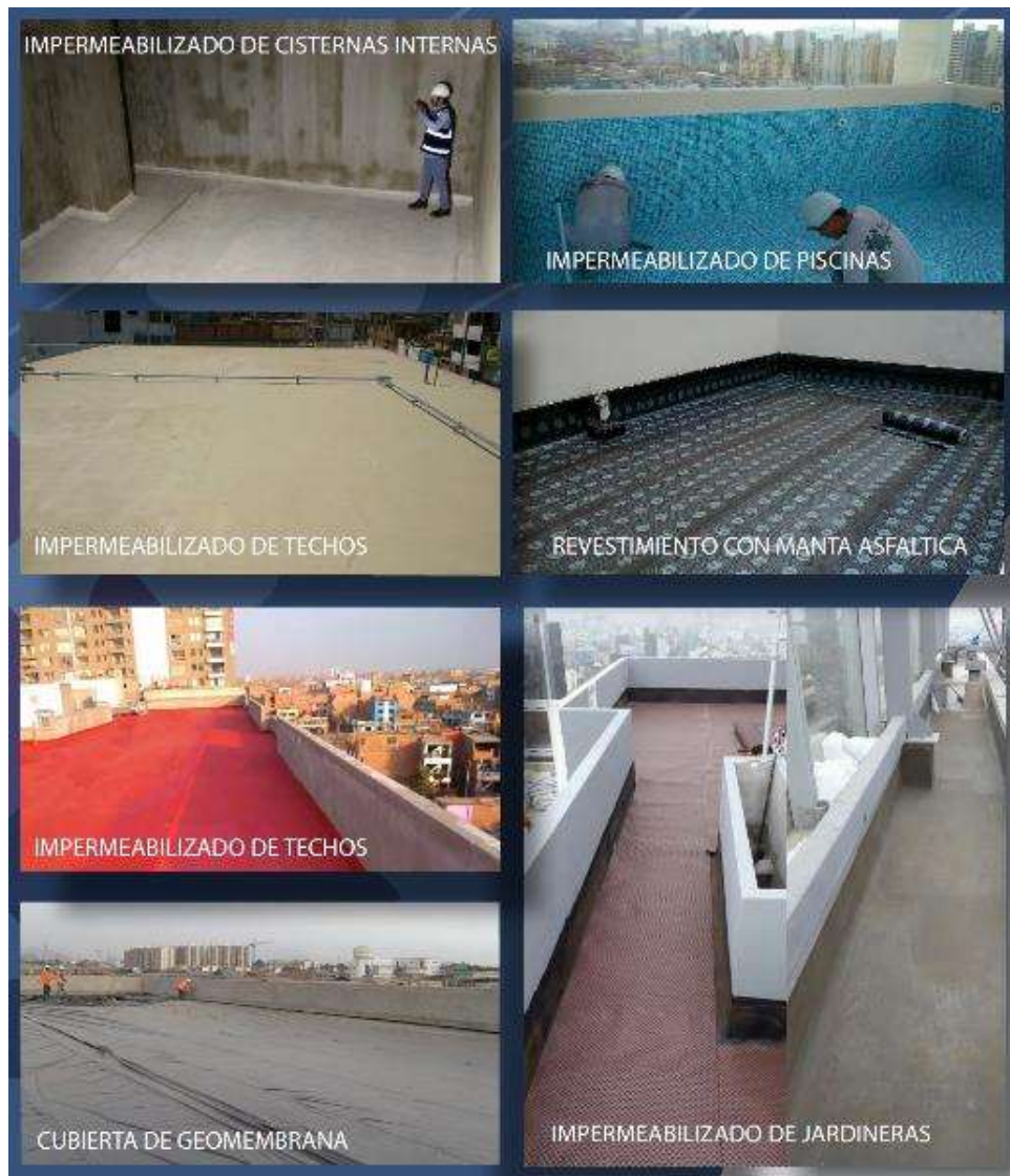
Figura 11- Tipos de Impermeabilización
