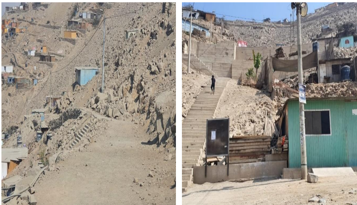
FIGURA 6: Entorno del Asentamiento Humano 7 de Junio.
