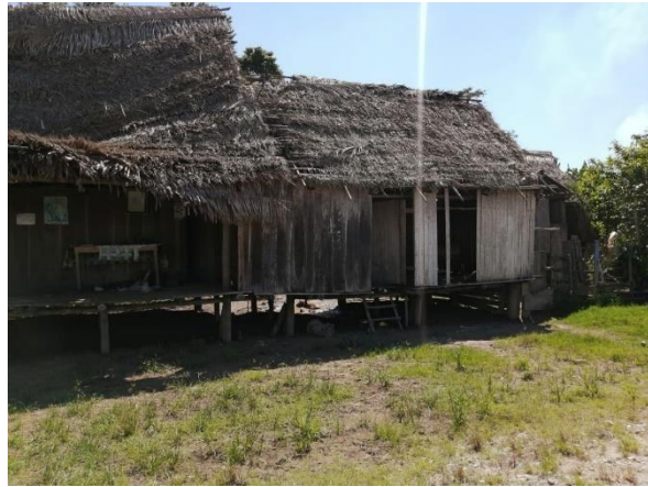
Figura 17. Vivienda precaria de la zona.
