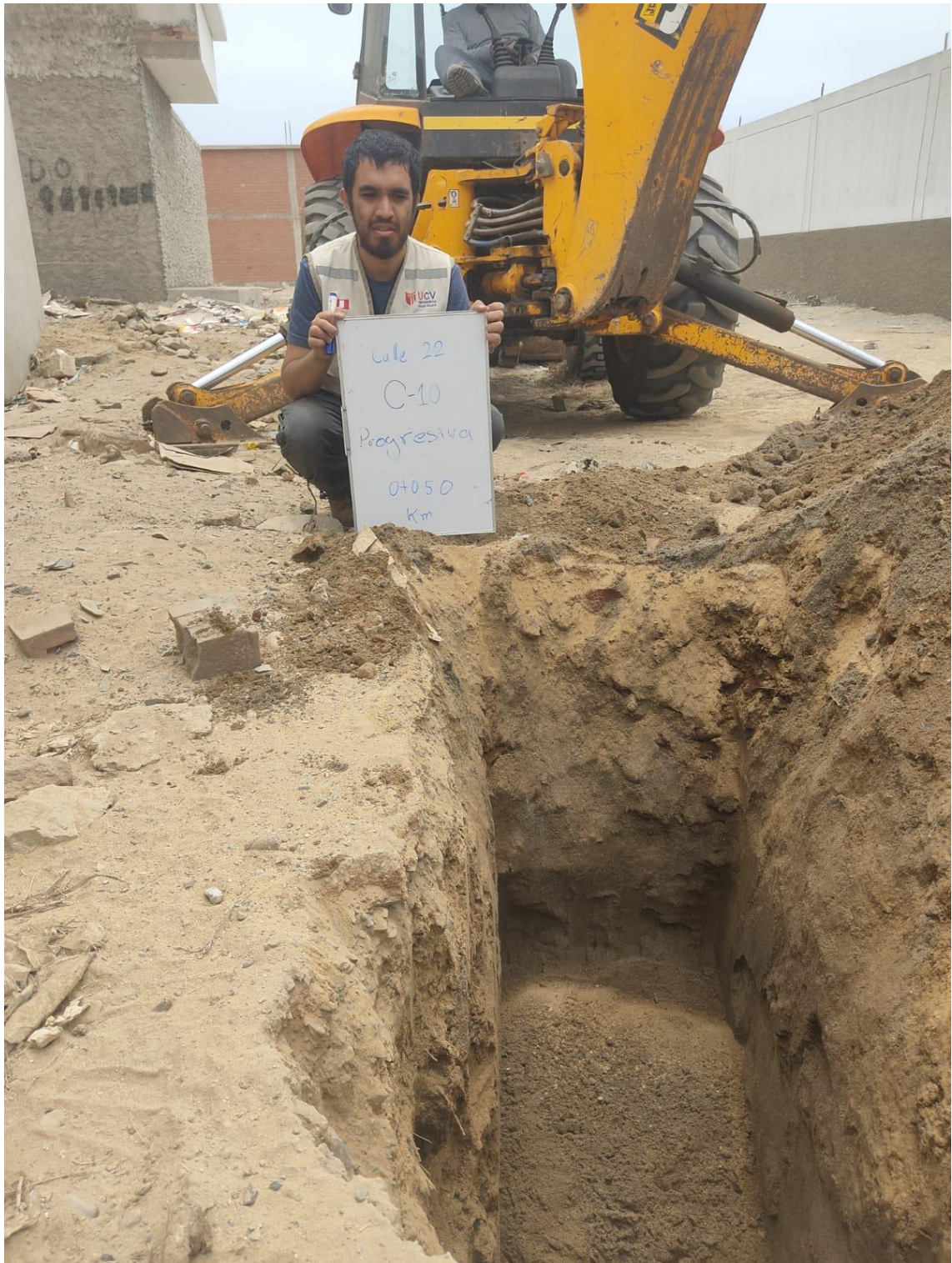
Imagen 36. Calicata - 10, progresiva 0+050 Km
