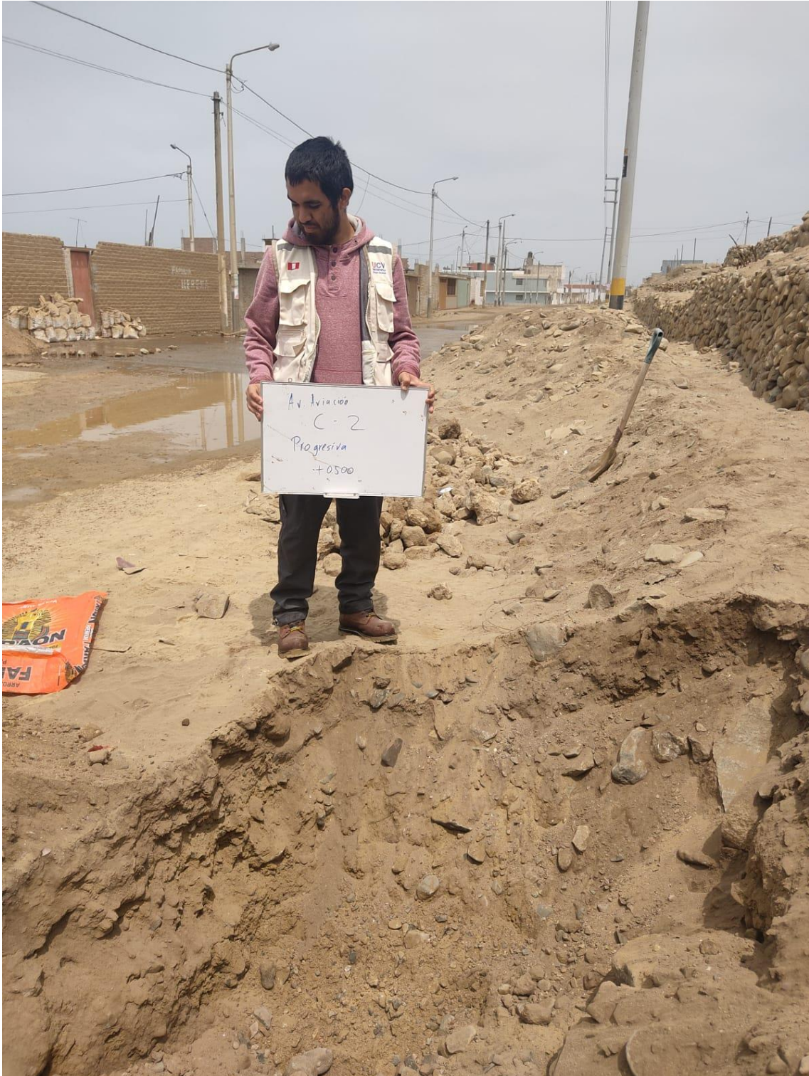
Imagen 8. Calicata - 02, progresiva 0+500 Km
