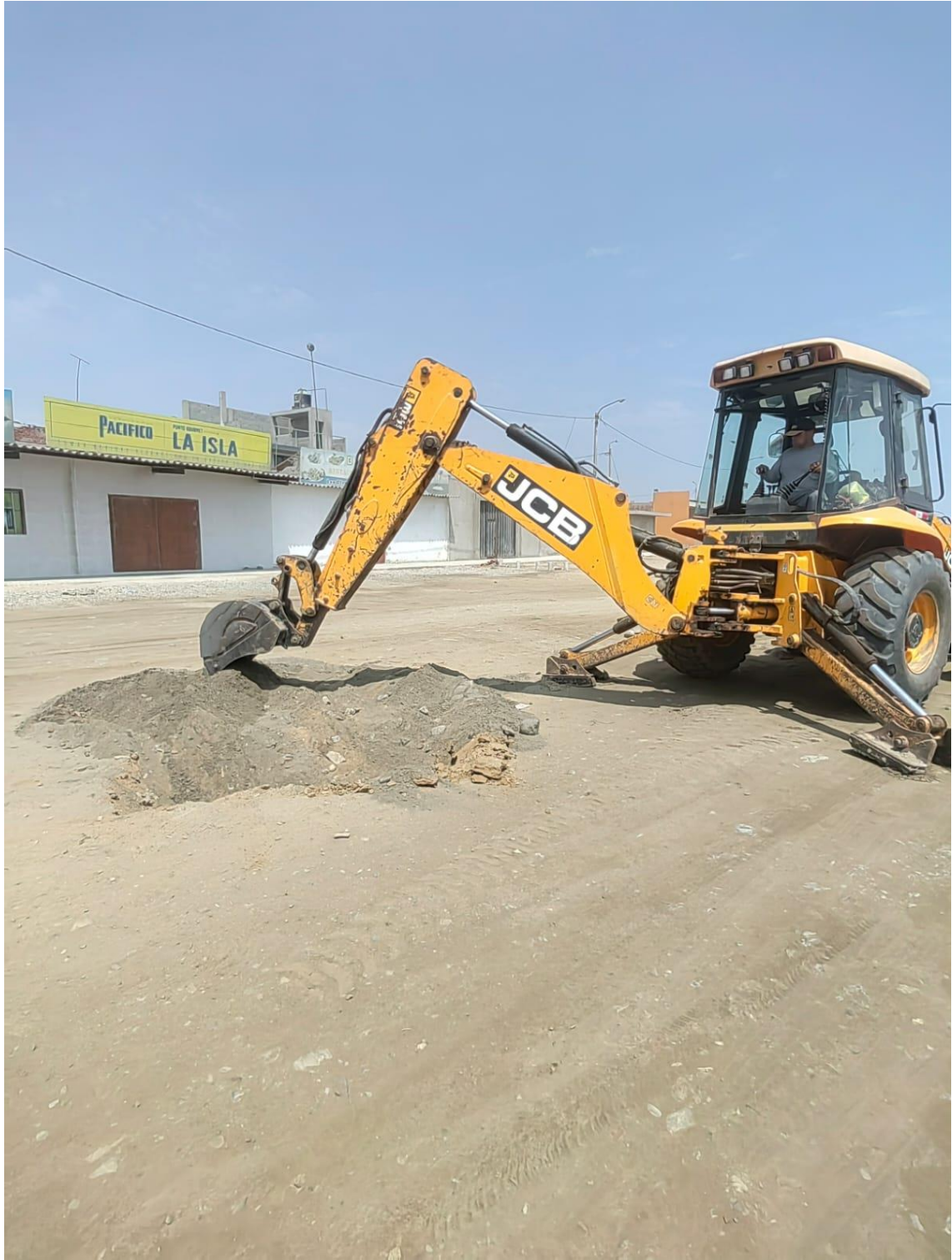
Imagen 20. Calicata - 05, progresiva 0+000 Km
