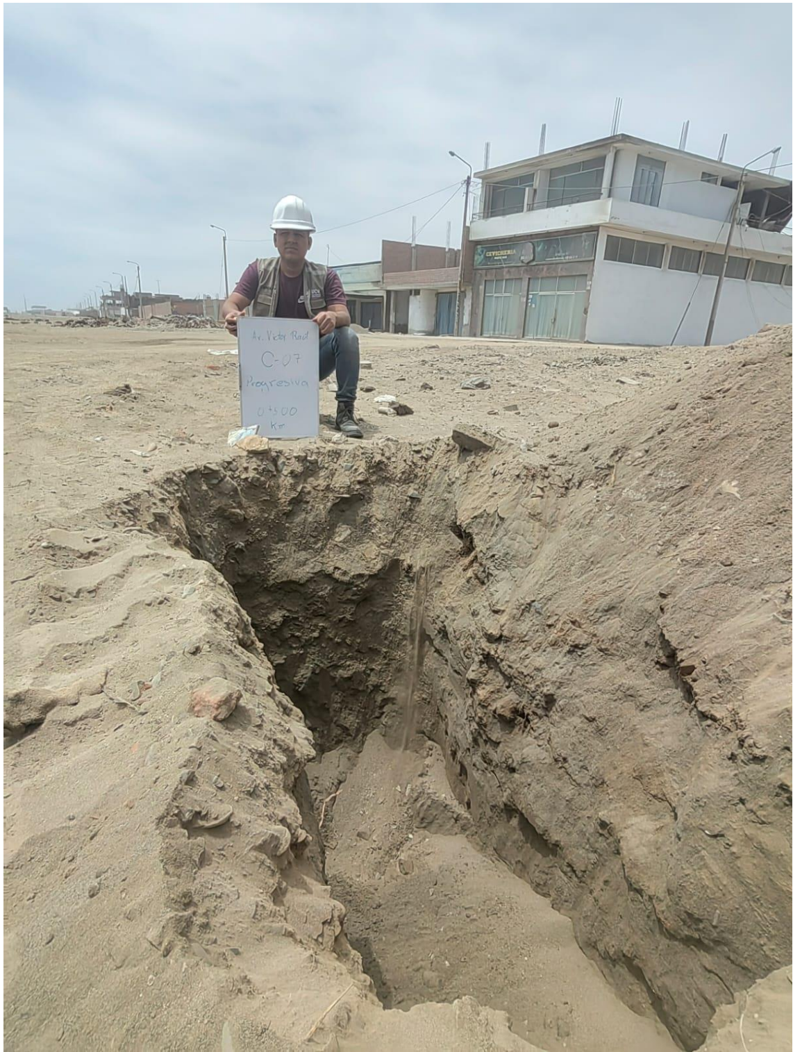
Imagen 26. Calicata - 07, progresiva 0+500 Km
