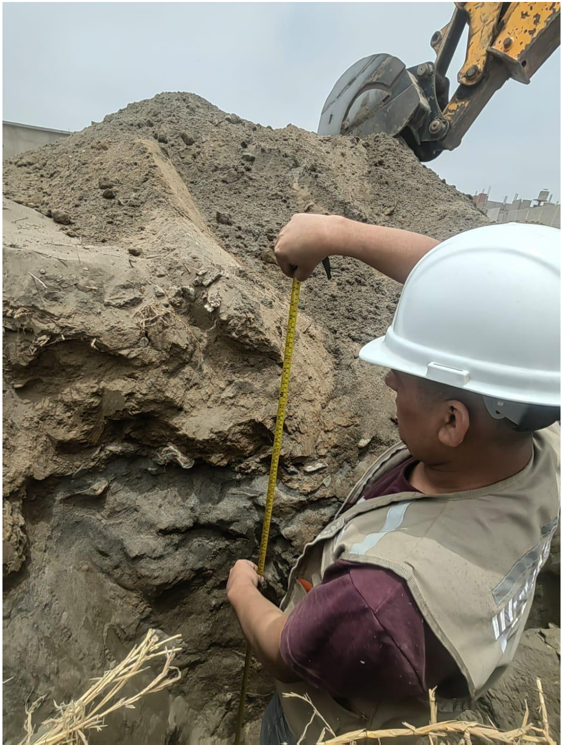
Imagen 35. Calicata - 09, progresiva 1+000 Km
