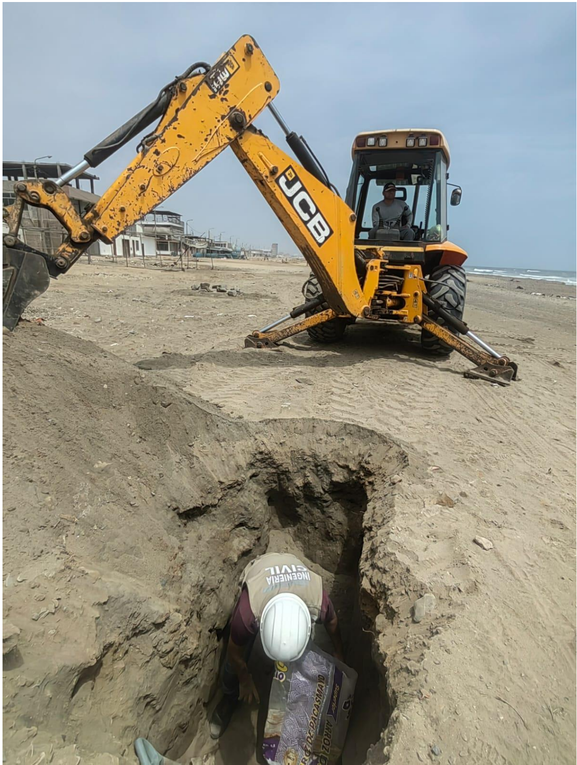
Imagen 28. Calicata - 07, progresiva 0+500 Km
