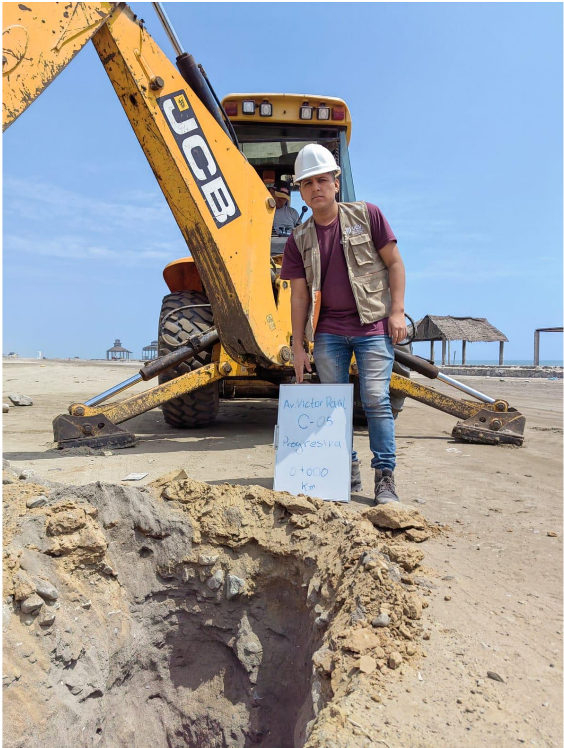
Imagen 17. Calicata - 05, progresiva 0+000 Km
