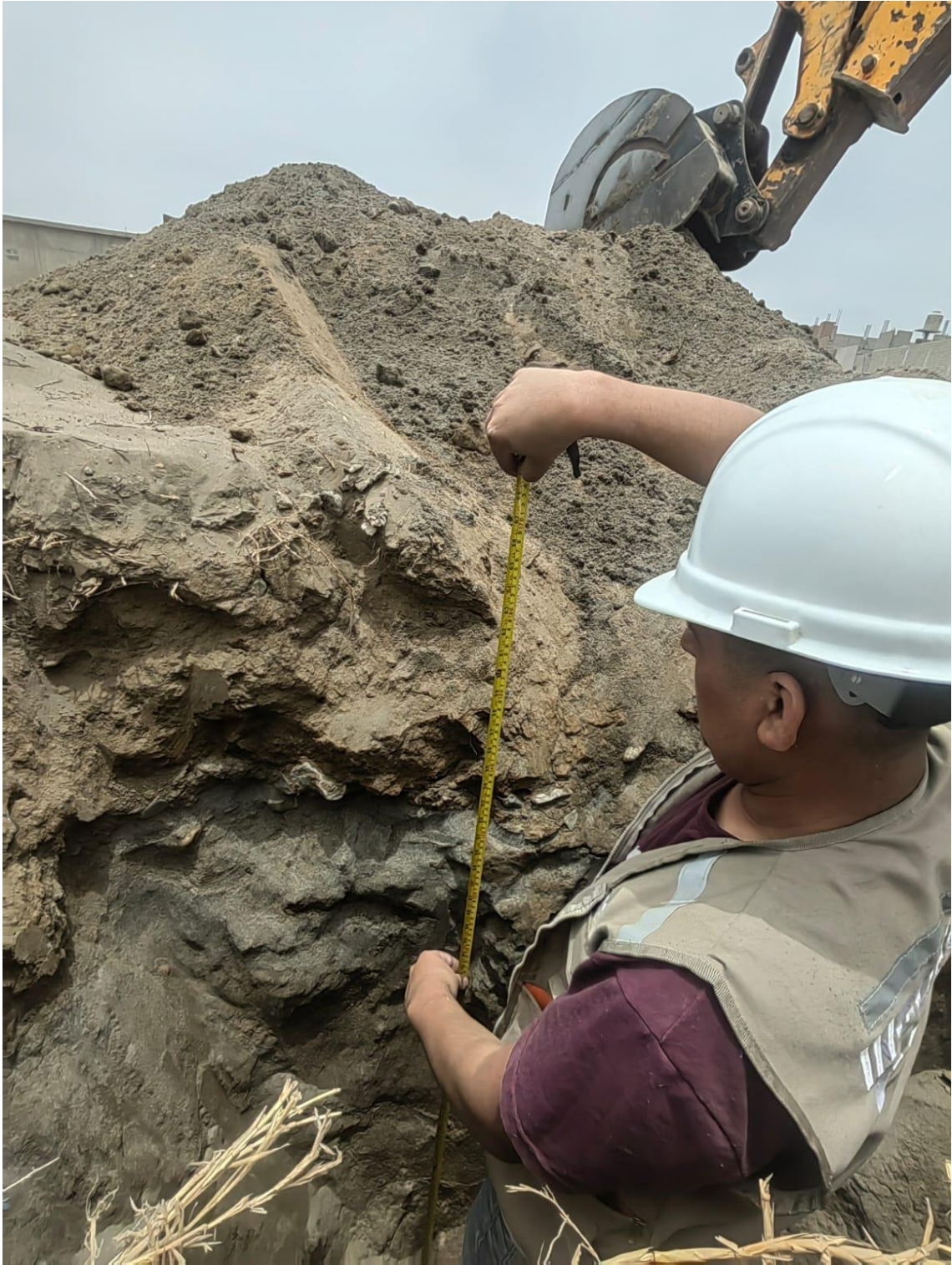
Imagen 42. Calicata - 11, progresiva 1+500 Km
