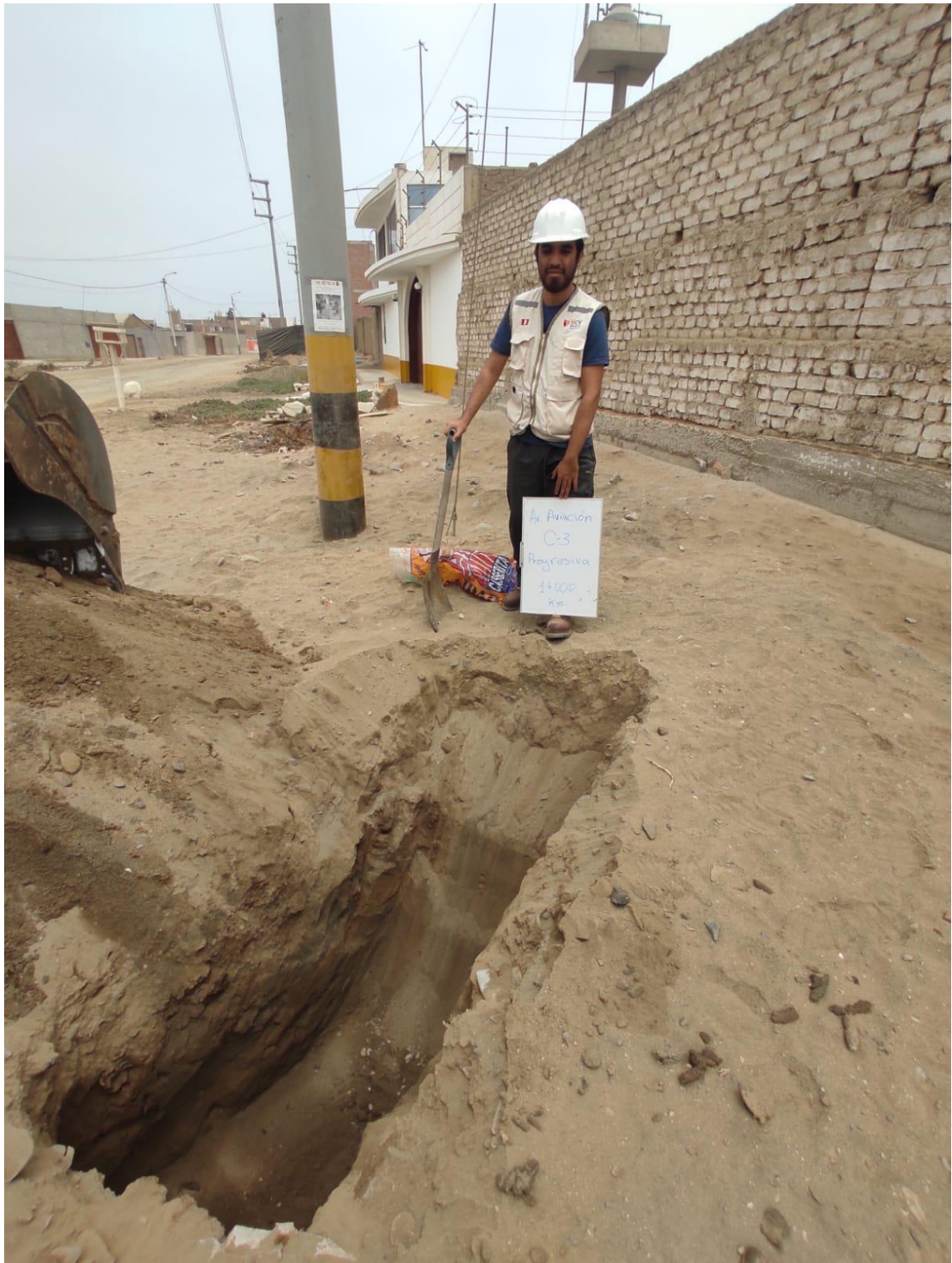
Imagen 11. Calicata - 03, progresiva 1+000 Km
