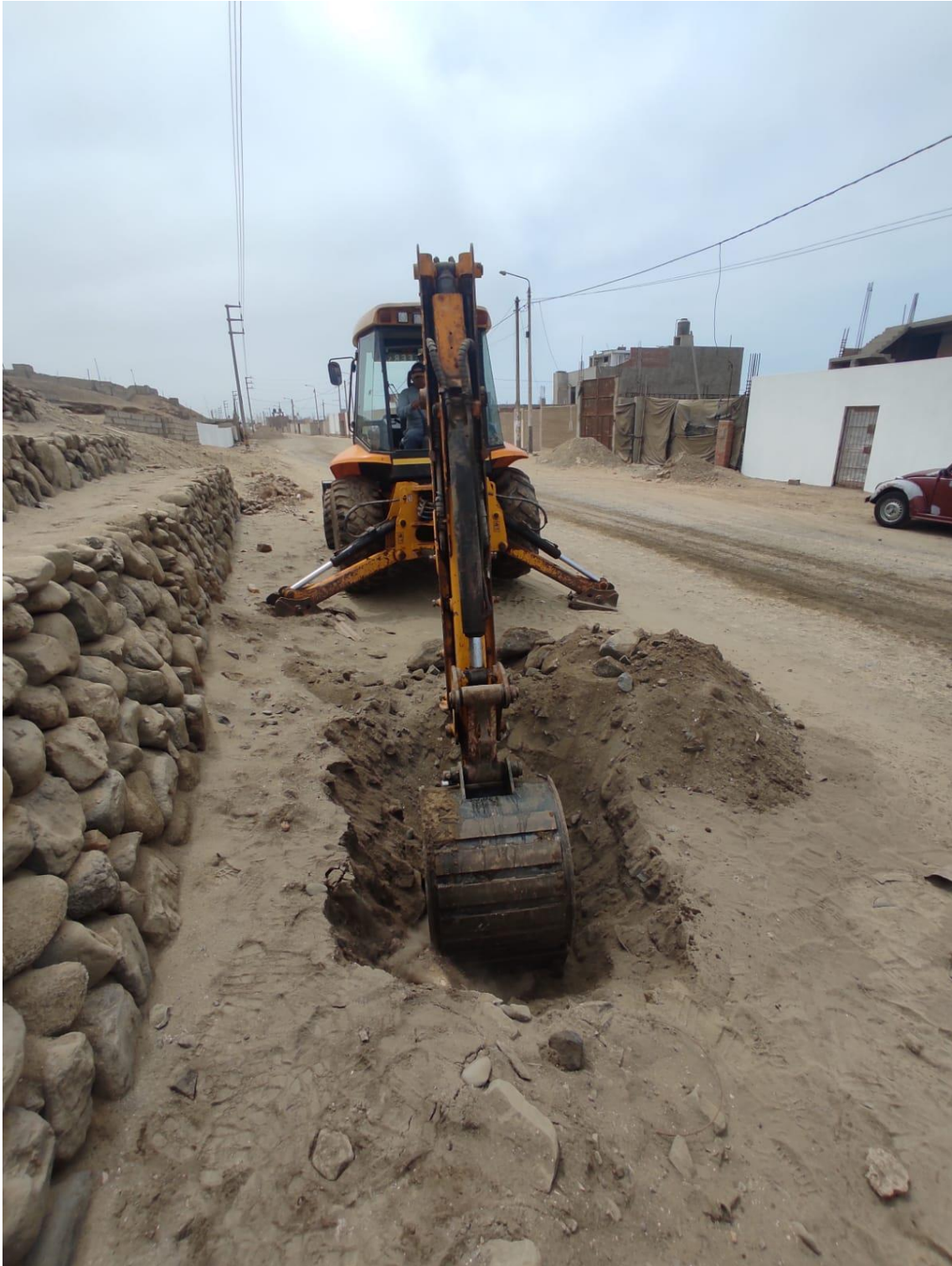
Imagen 7. Calicata - 02, progresiva 0+500 Km
