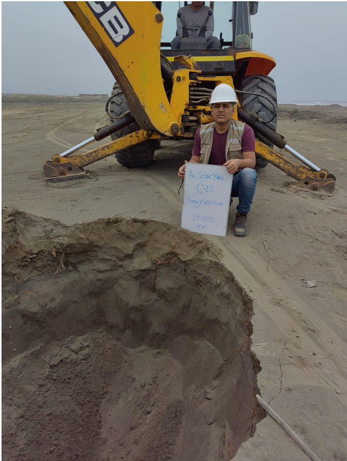
Imagen 47. Calicata - 13, progresiva 2+000 Km
