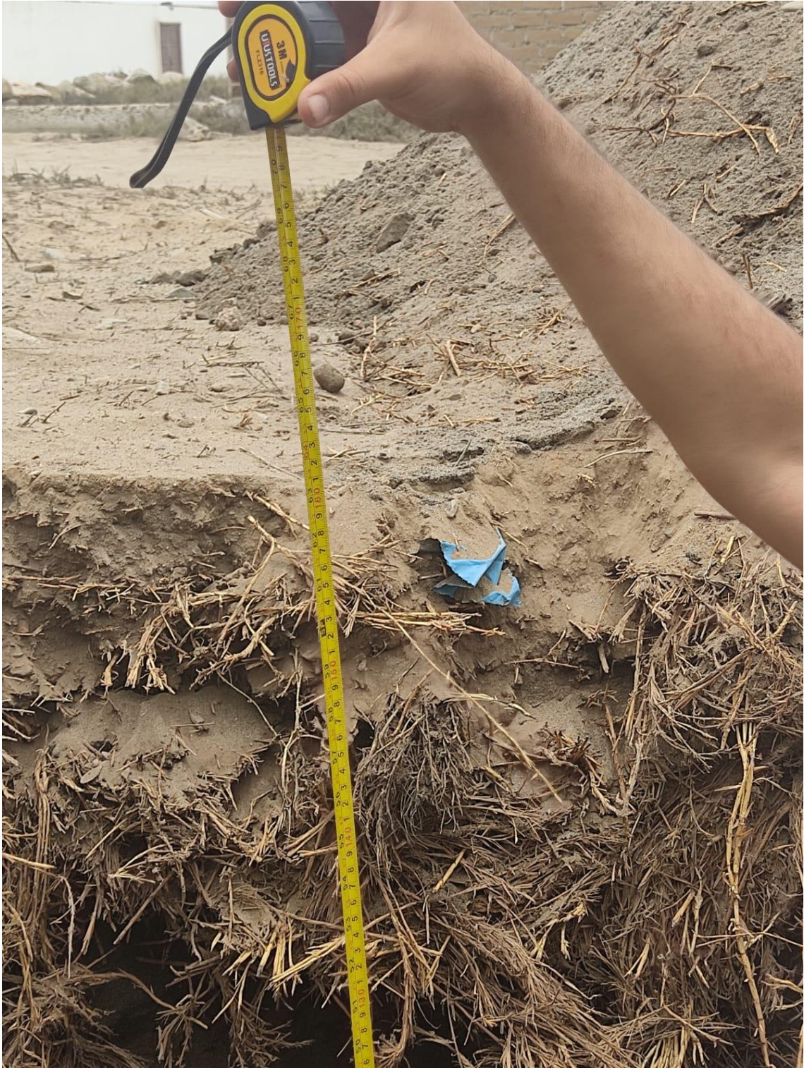
Imagen 44. Calicata - 12, progresiva 0+050 Km
