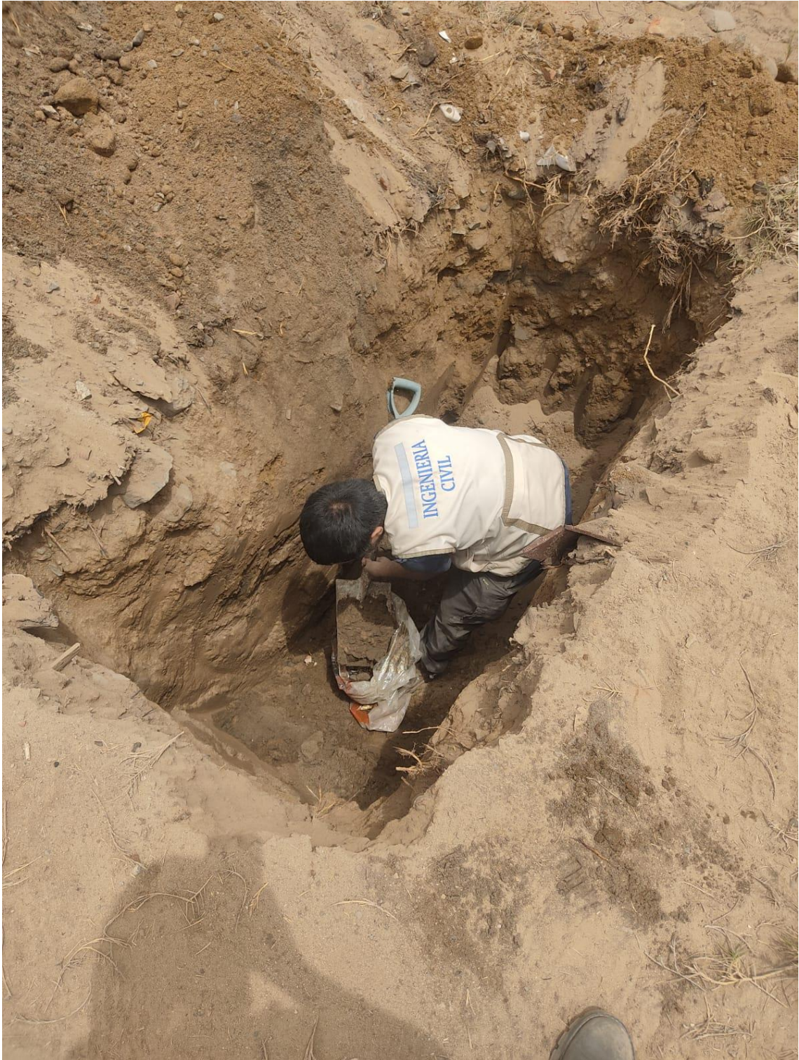
Imagen 32. Calicata - 08, progresiva 0+070 Km
