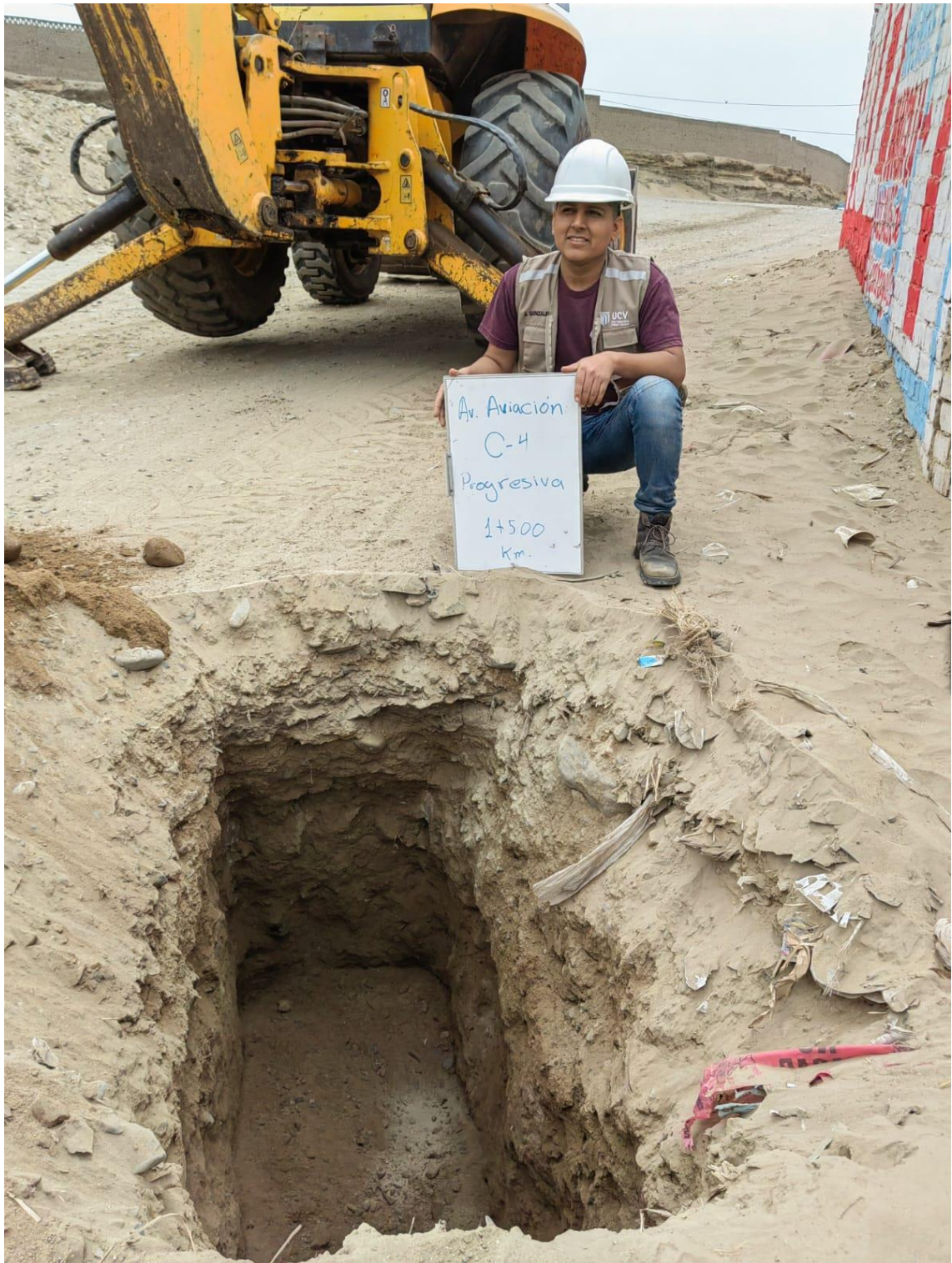
Imagen 15. Calicata - 04, progresiva 1+500 Km
