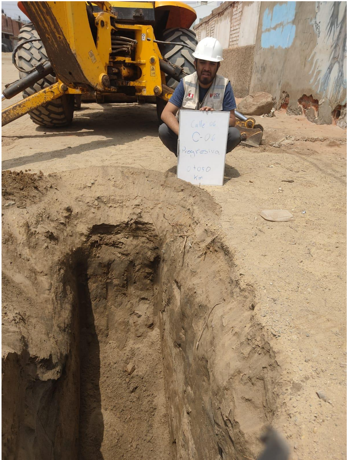
Imagen 23. Calicata - 06, progresiva 0+050 Km
