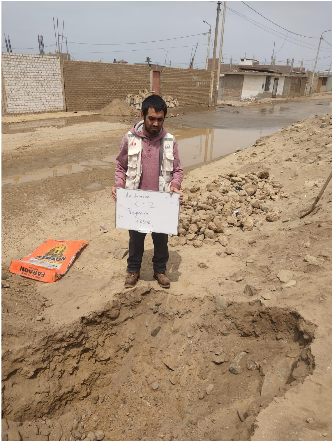
Imagen 9. Calicata - 02, progresiva 0+500 Km
