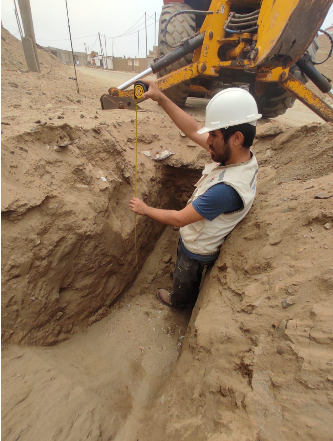
Imagen 12. Calicata - 03, progresiva 1+000 Km
