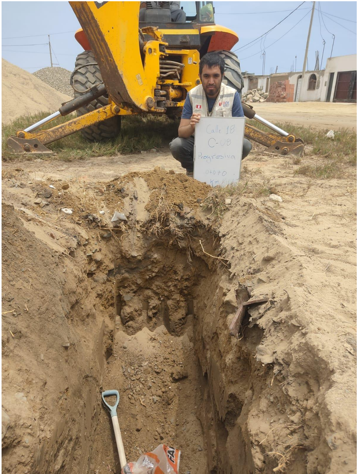
Imagen 29. Calicata - 08, progresiva 0+070 Km
