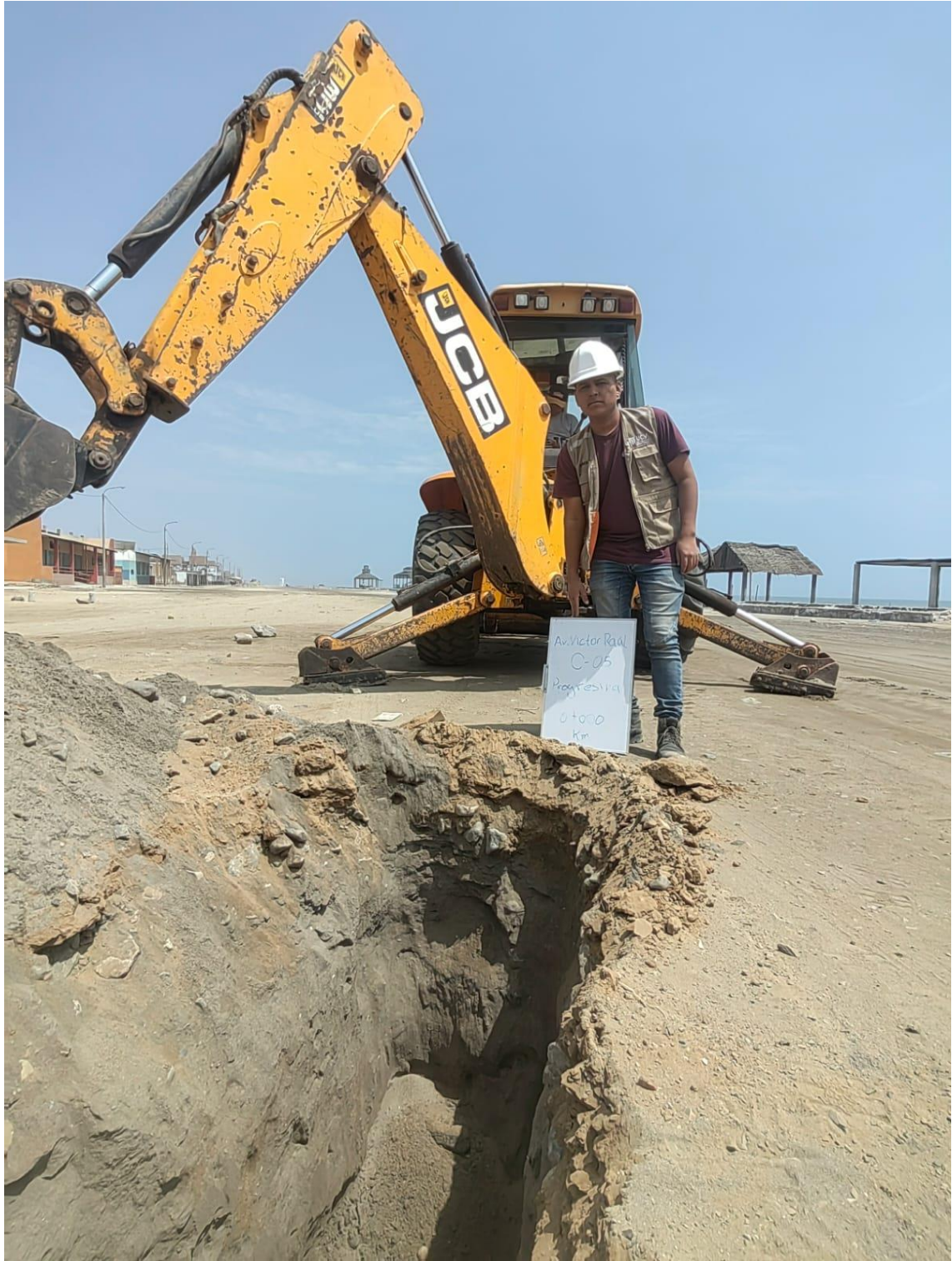
Imagen 18. Calicata - 05, progresiva 0+000 Km
