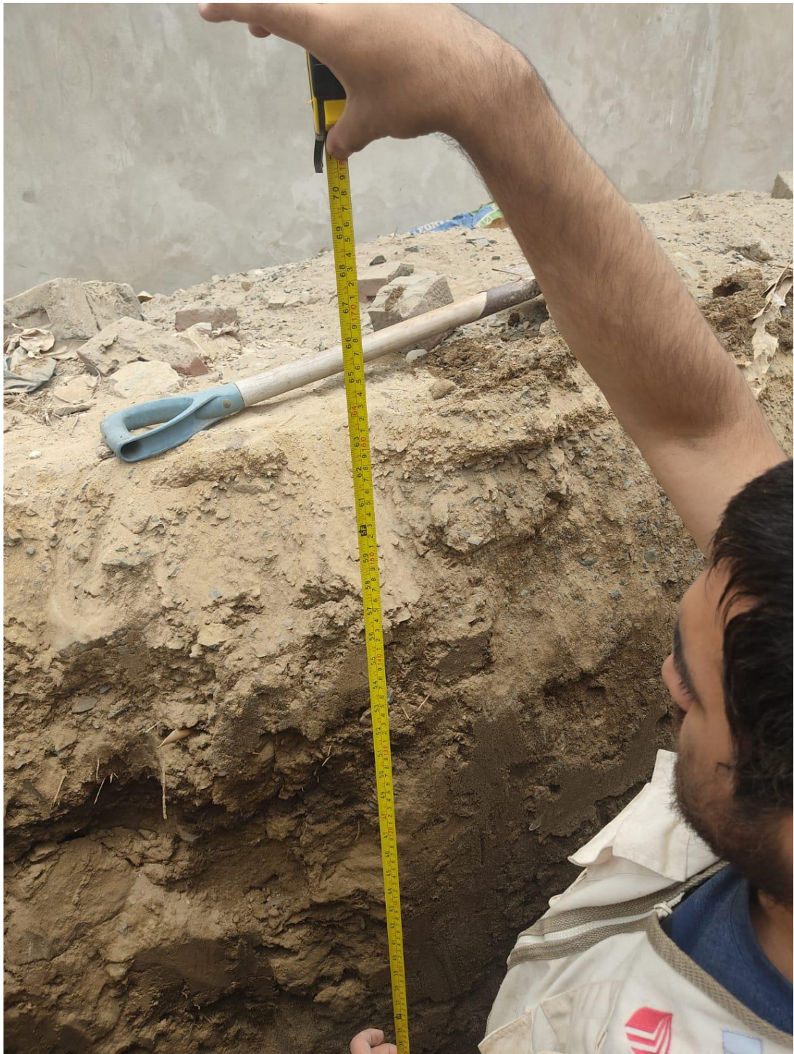
Imagen 37. Calicata - 10, progresiva 0+050 Km
