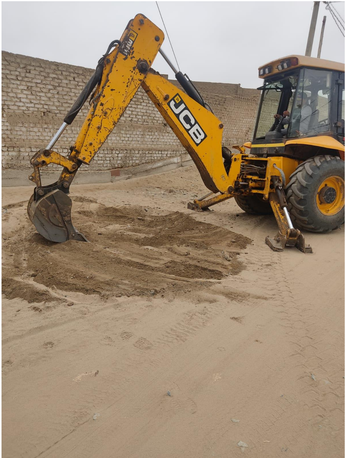
Imagen 13. Calicata - 03, progresiva 1+000 Km
