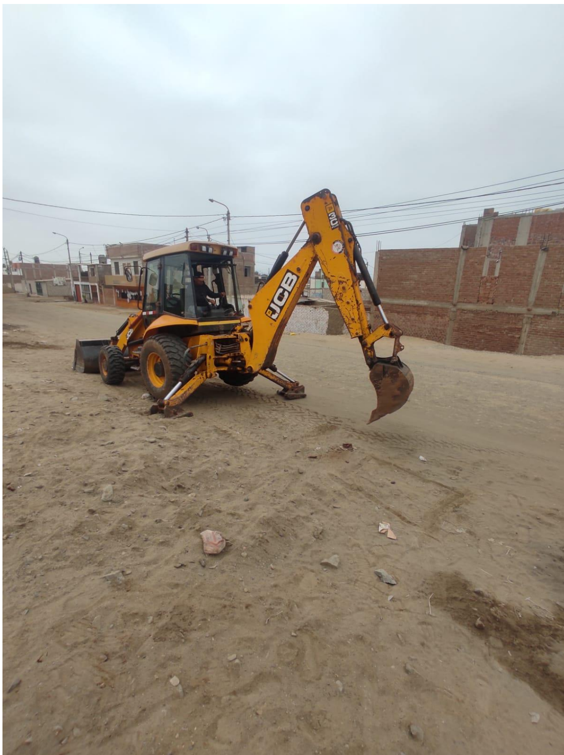
Imagen 1. Calicata - 01, progresiva 0+000 Km
