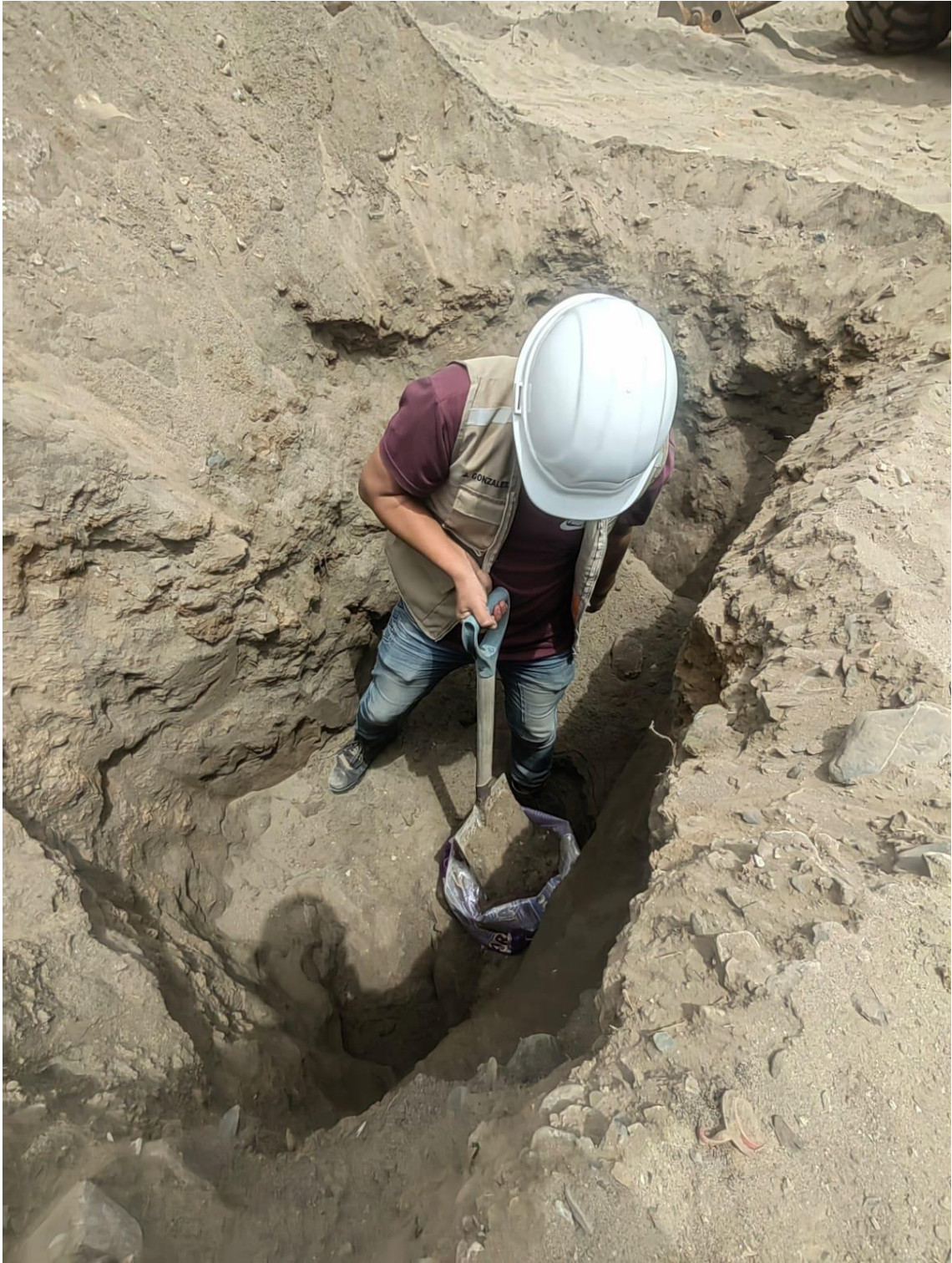
Imagen 27. Calicata - 07, progresiva 0+500 Km
