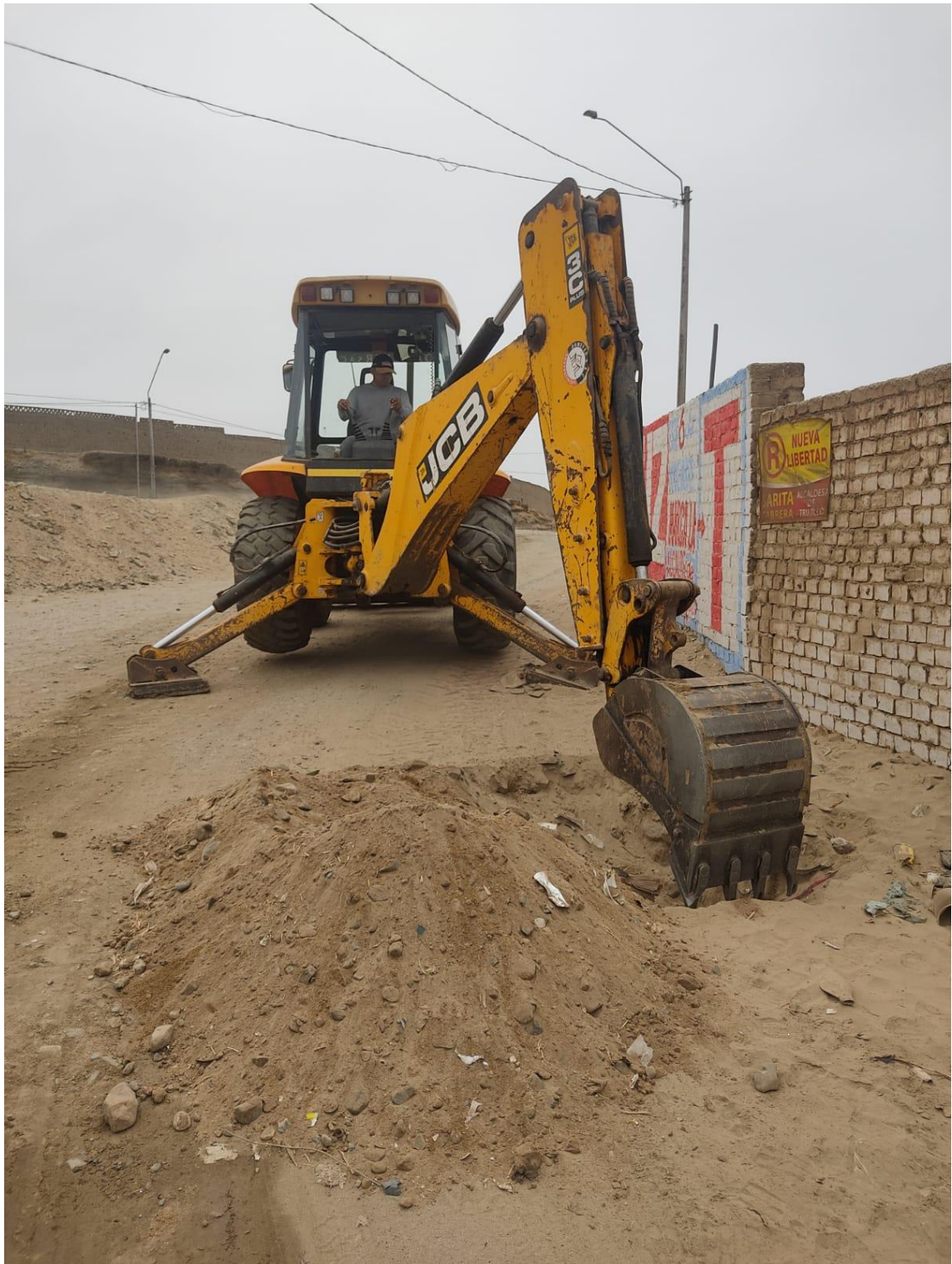
Imagen 14. Calicata - 04, progresiva 1+500 Km
