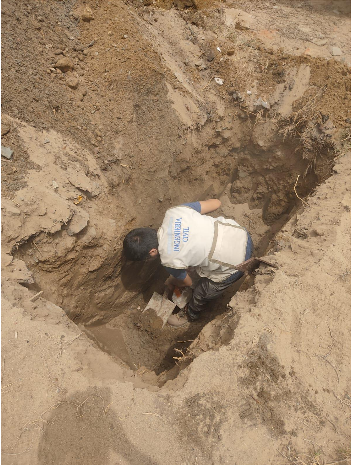
Imagen 31. Calicata - 08, progresiva 0+070 Km
