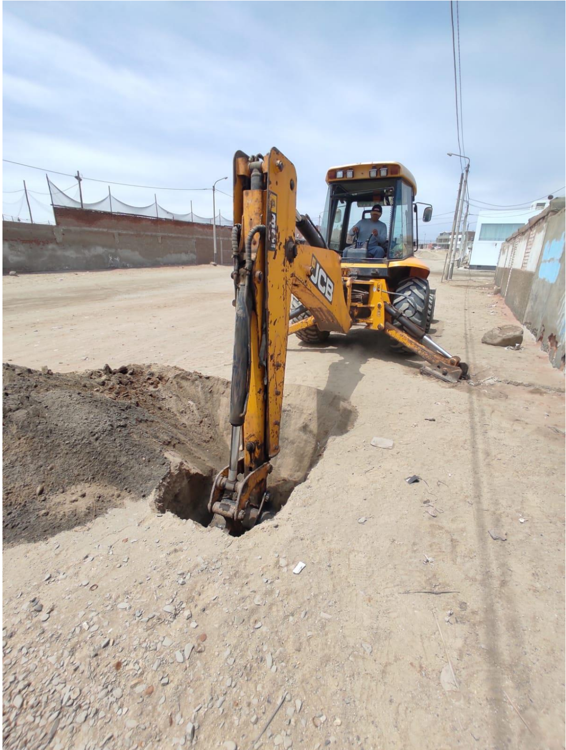
Imagen 21. Calicata - 06, progresiva 0+050 Km
