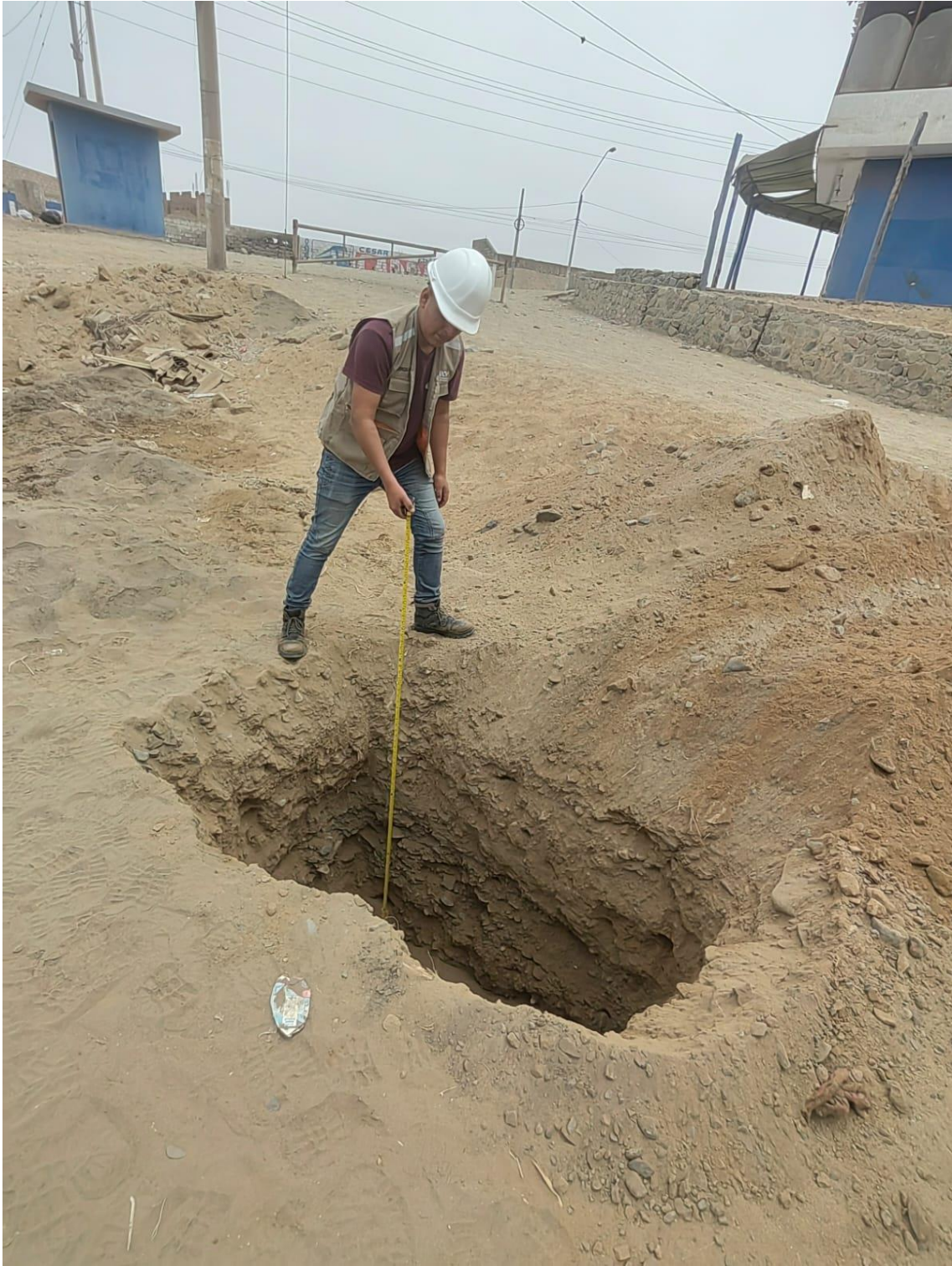
Imagen 5. Calicata - 01, progresiva 0+000 Km
