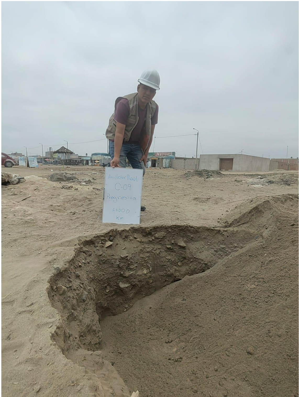
Imagen 33. Calicata - 09, progresiva 1+000 Km
