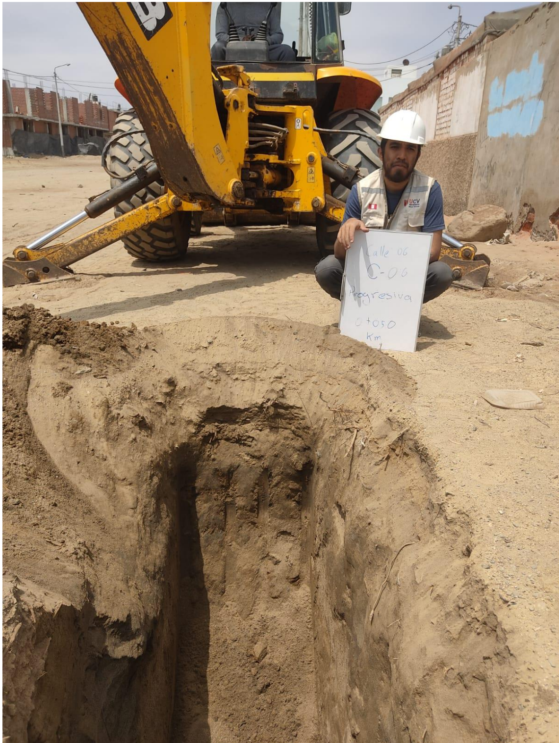
Imagen 22. Calicata - 06, progresiva 0+050 Km
