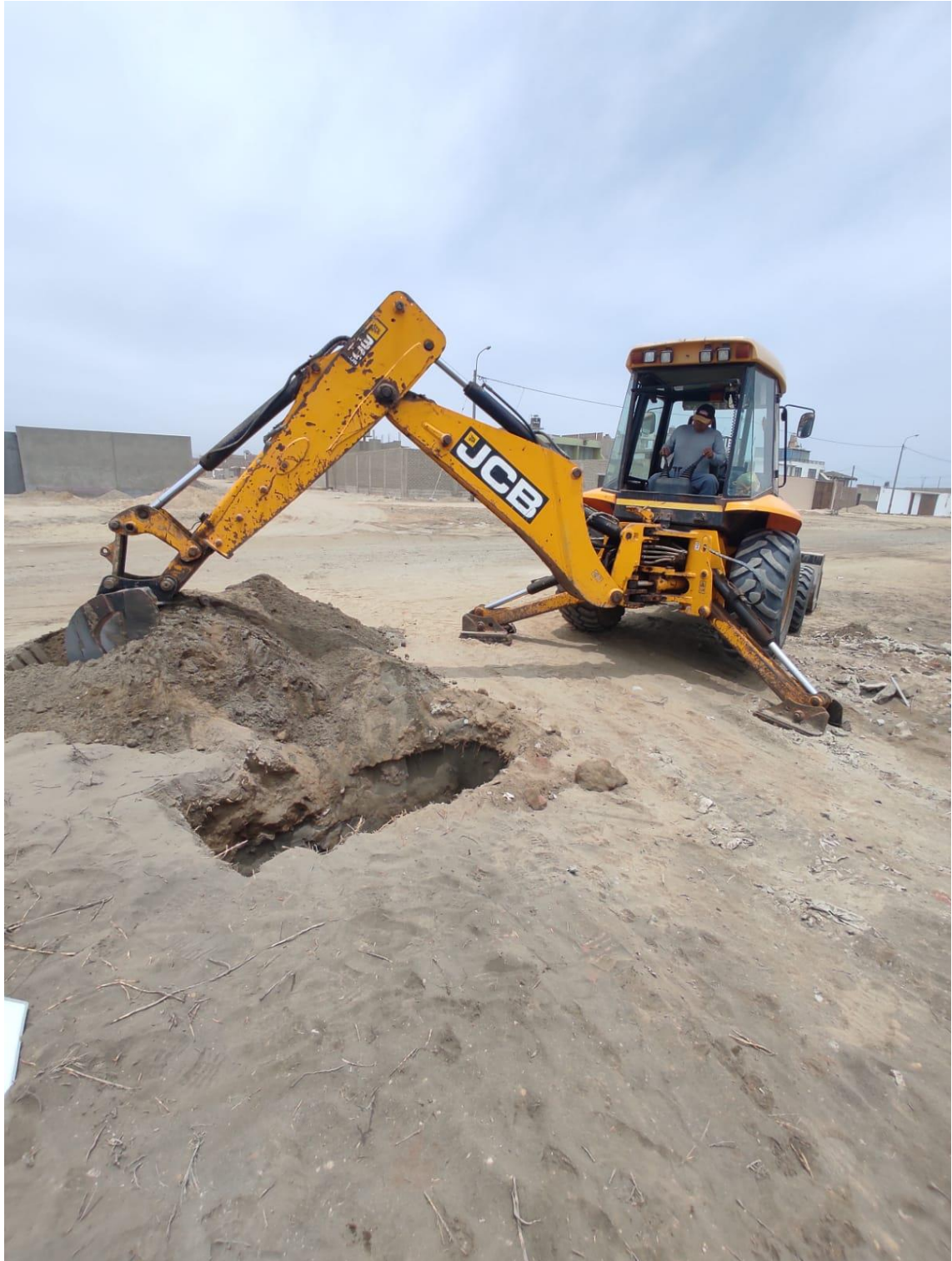
Imagen 39. Calicata - 11, progresiva 1+500 Km
