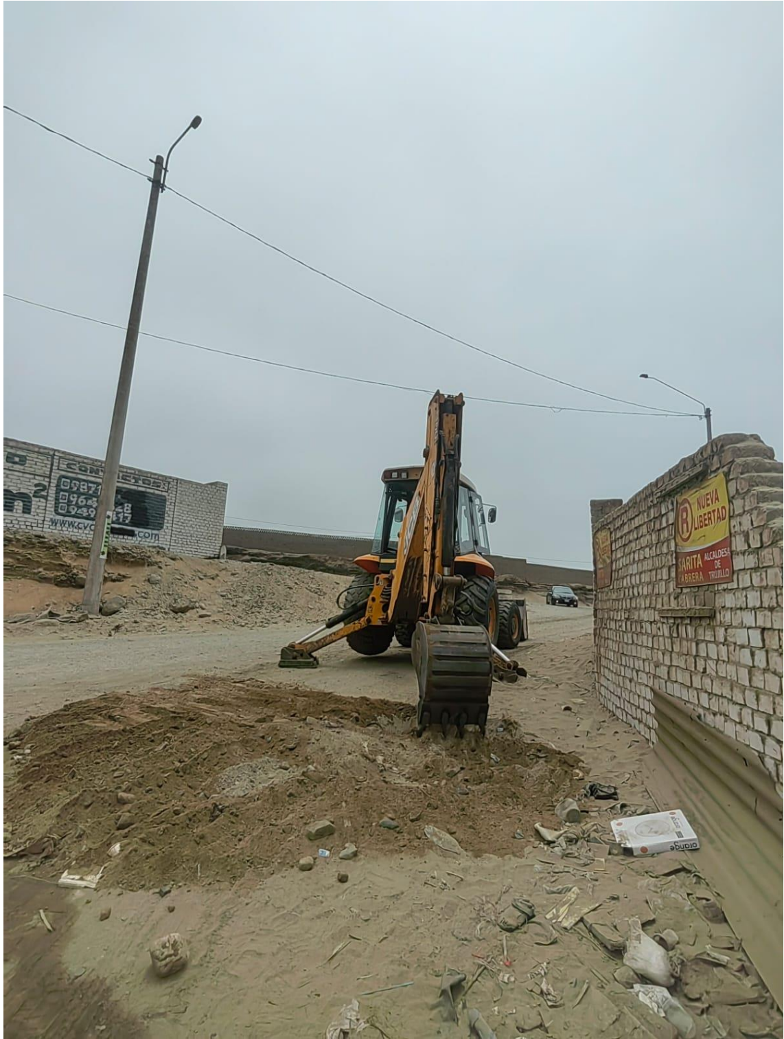
Imagen 16. Calicata - 04, progresiva 1+500 Km
