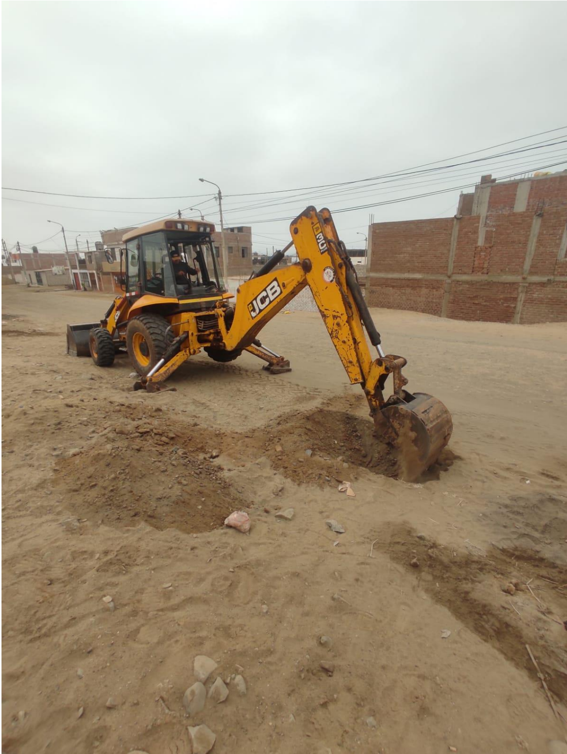
Imagen 2. Calicata - 01, progresiva 0+000 Km
