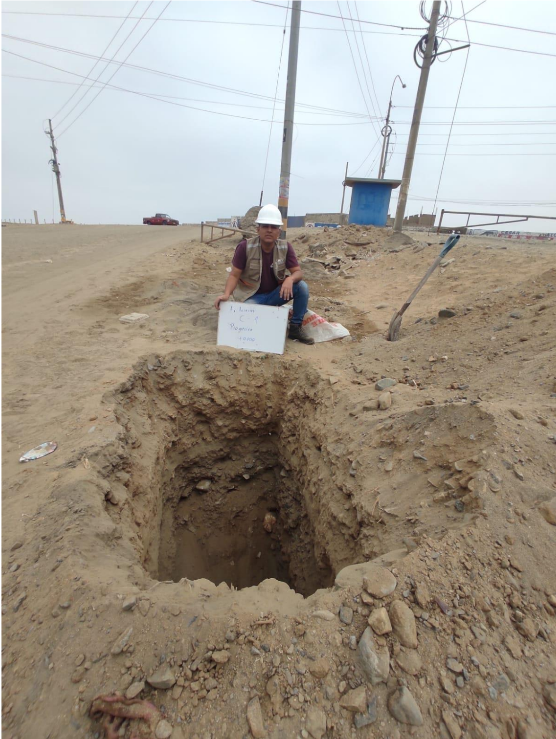
Imagen 3. Calicata - 01, progresiva 0+000 Km
