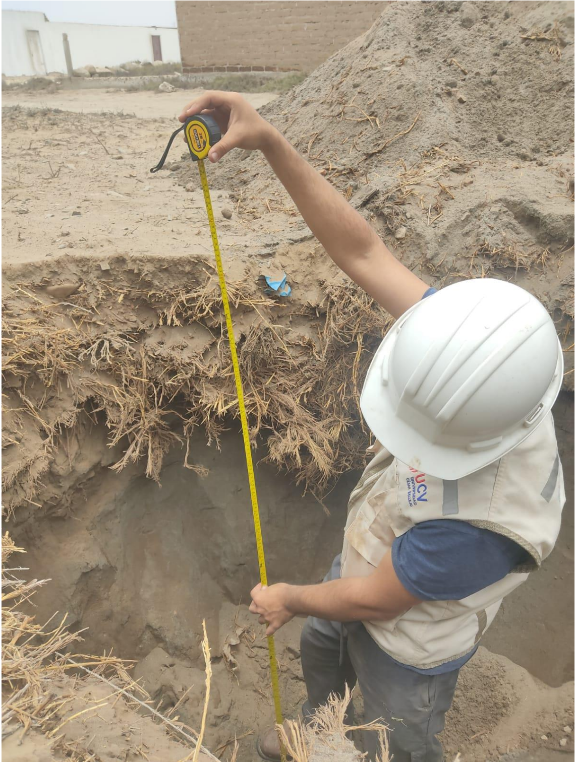
Imagen 45. Calicata - 12, progresiva 0+050 Km
