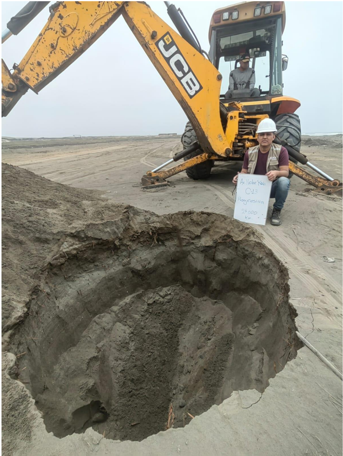
Imagen 48. Calicata - 13, progresiva 2+000 Km
