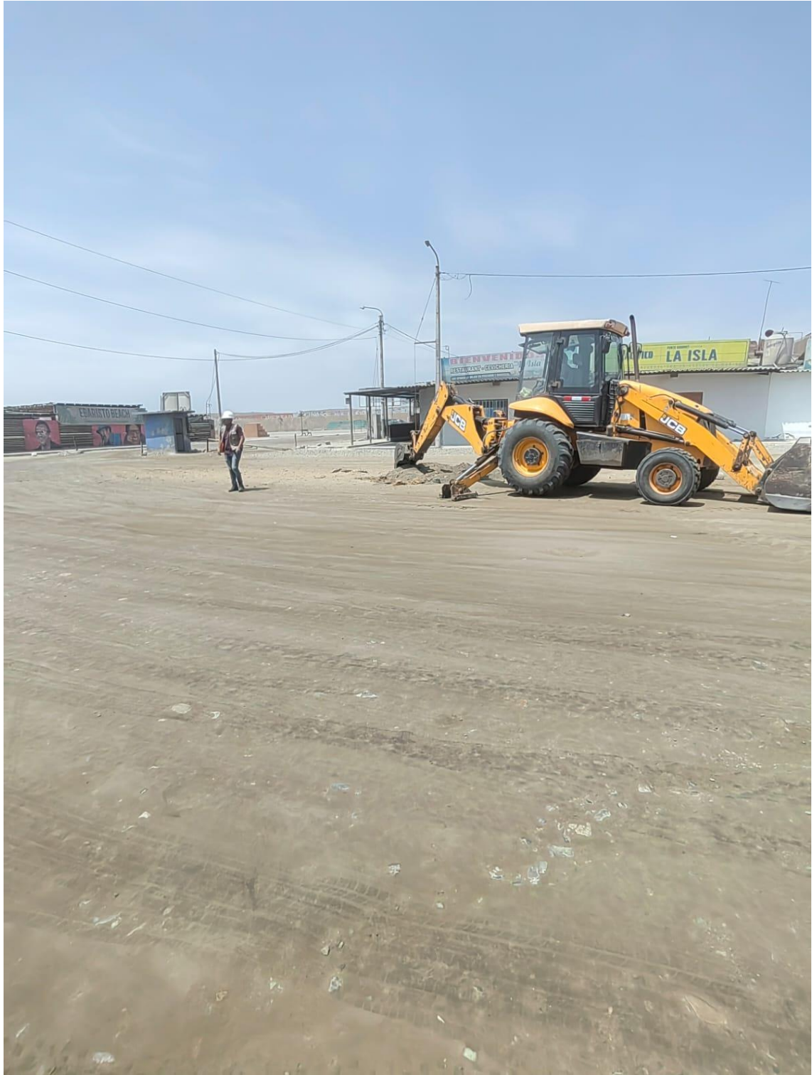
Imagen 19. Calicata - 05, progresiva 0+000 Km
