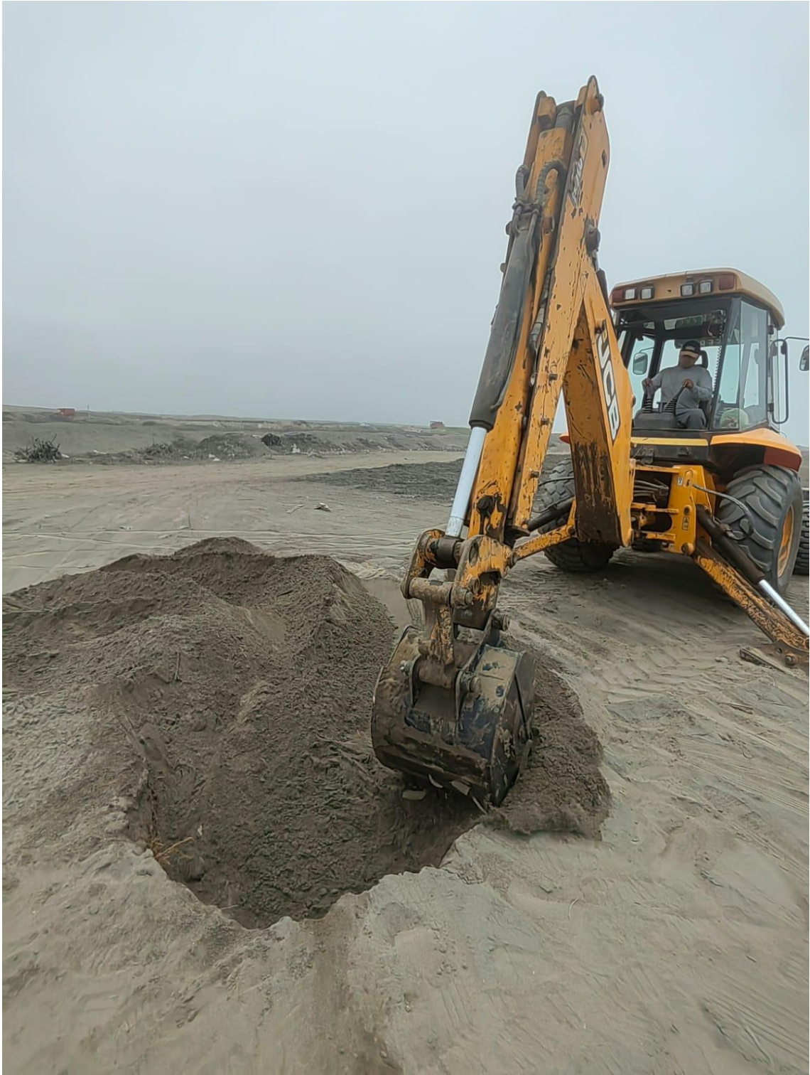
Imagen 46. Calicata - 13, progresiva 2+000 Km
