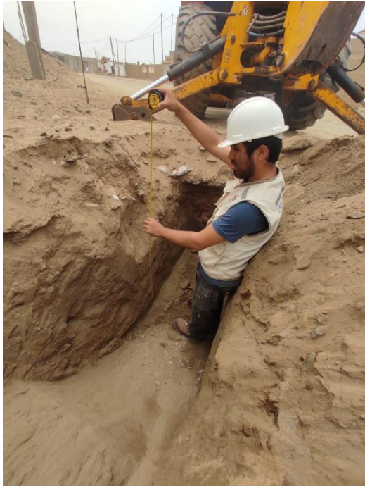
Ilustración 9. Medición de profundidad de calicata.
