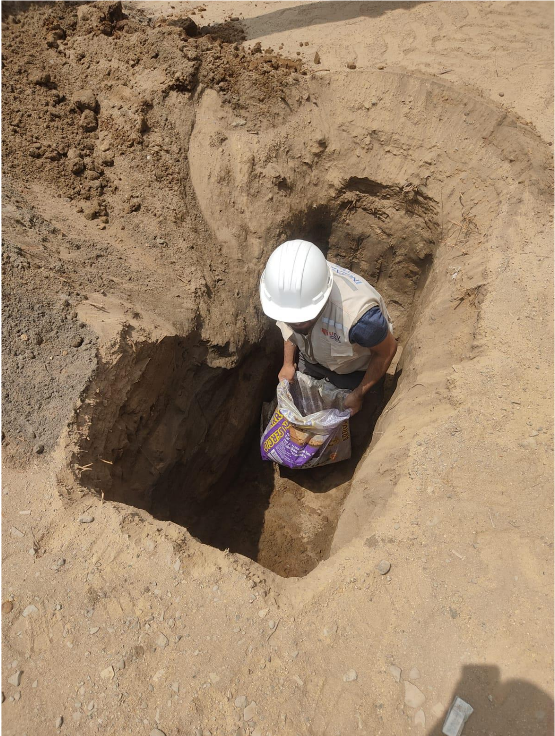
Imagen 24. Calicata - 06, progresiva 0+050 Km
