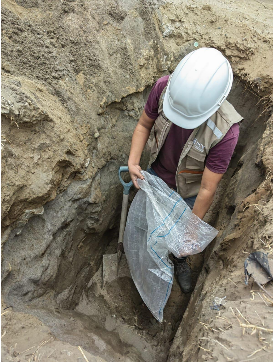
Imagen 40. Calicata - 11, progresiva 1+500 Km
