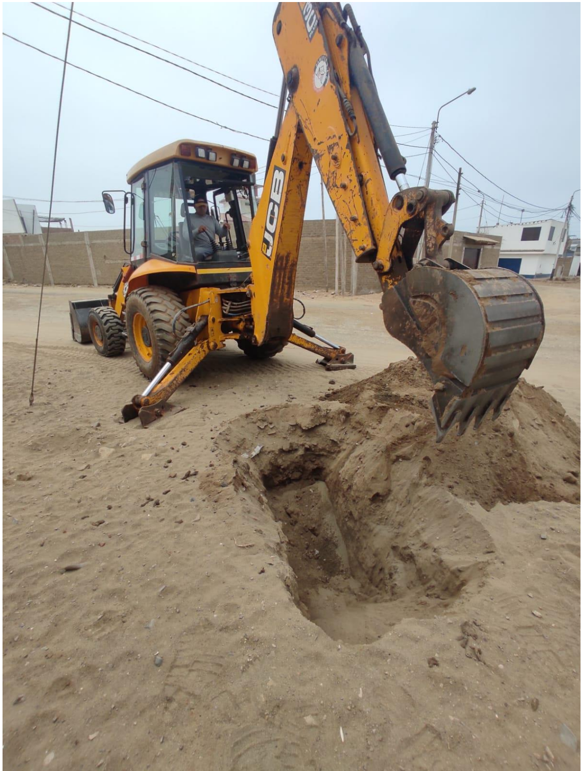
Imagen 10. Calicata - 03, progresiva 1+000 Km
