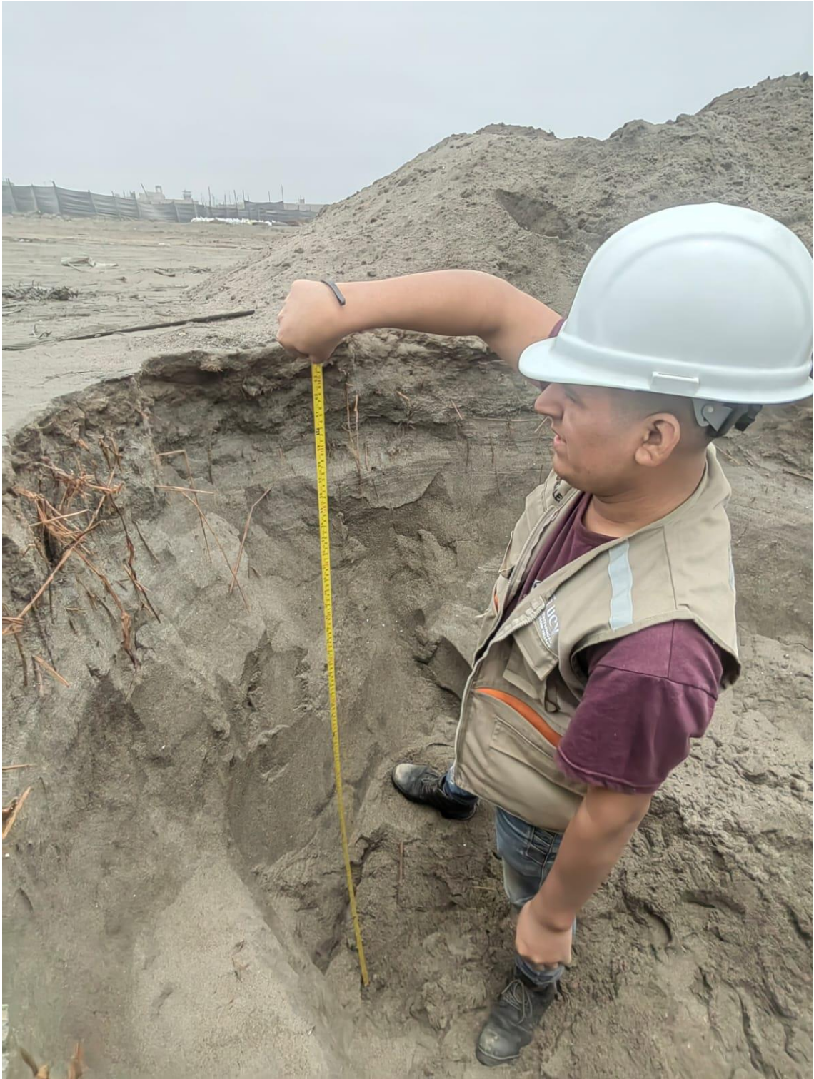
Imagen 49. Calicata - 13, progresiva 2+000 Km
