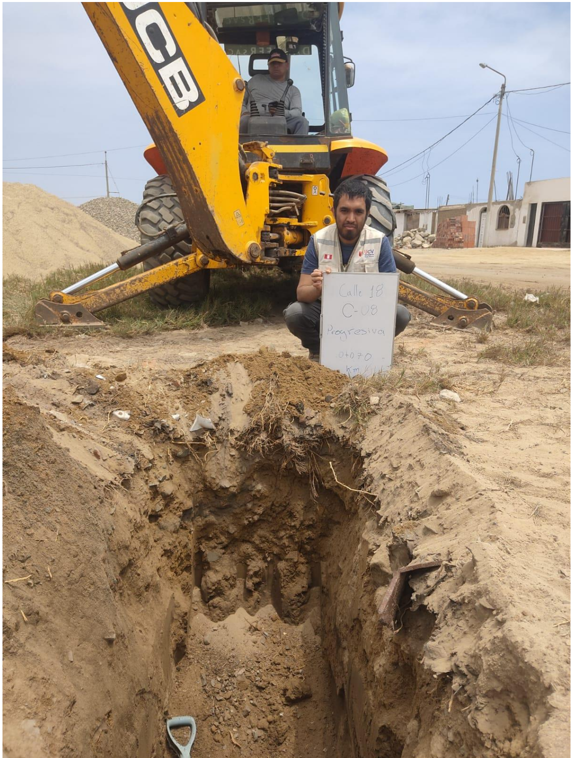
Imagen 30. Calicata - 08, progresiva 0+070 Km
