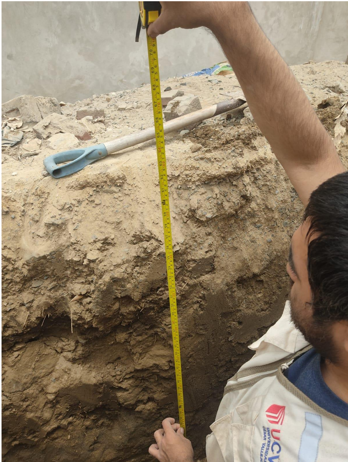
Imagen 38. Calicata - 10, progresiva 0+050 Km
