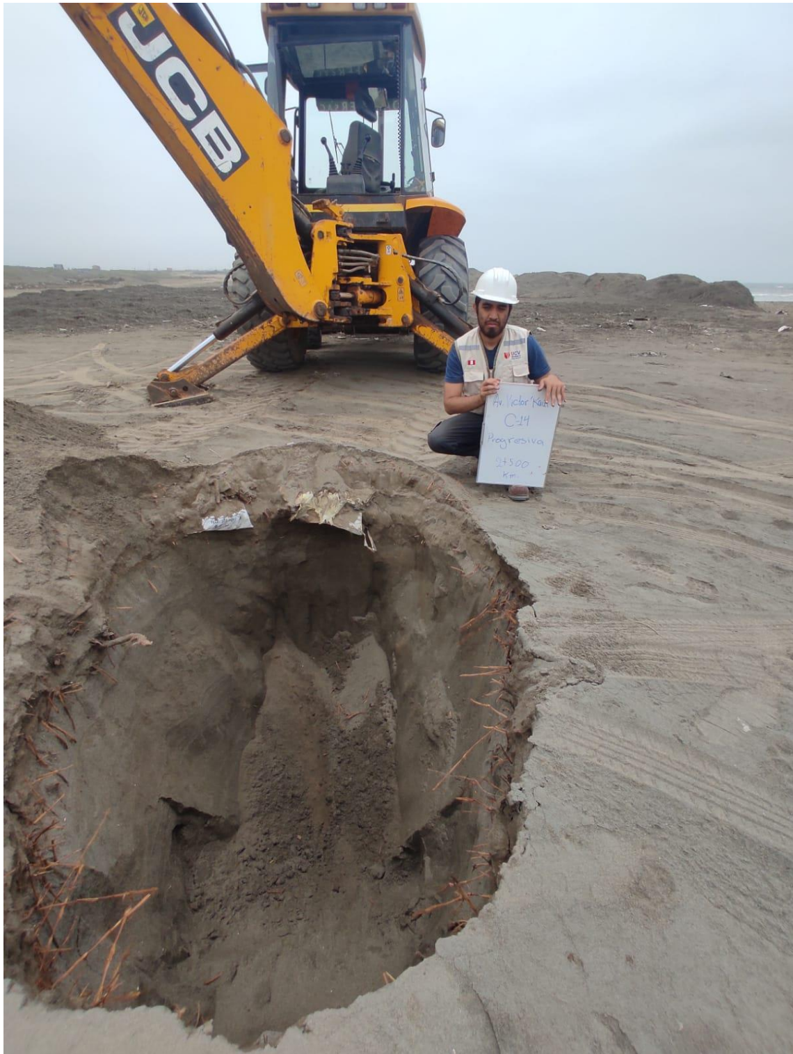
Imagen 52. Calicata - 14, progresiva 2+500 Km
