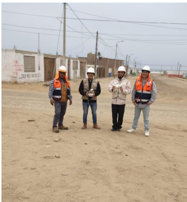
Ilustración 8. Tesistas y personal técnico capacitado en levantamiento topográfico con dron.
