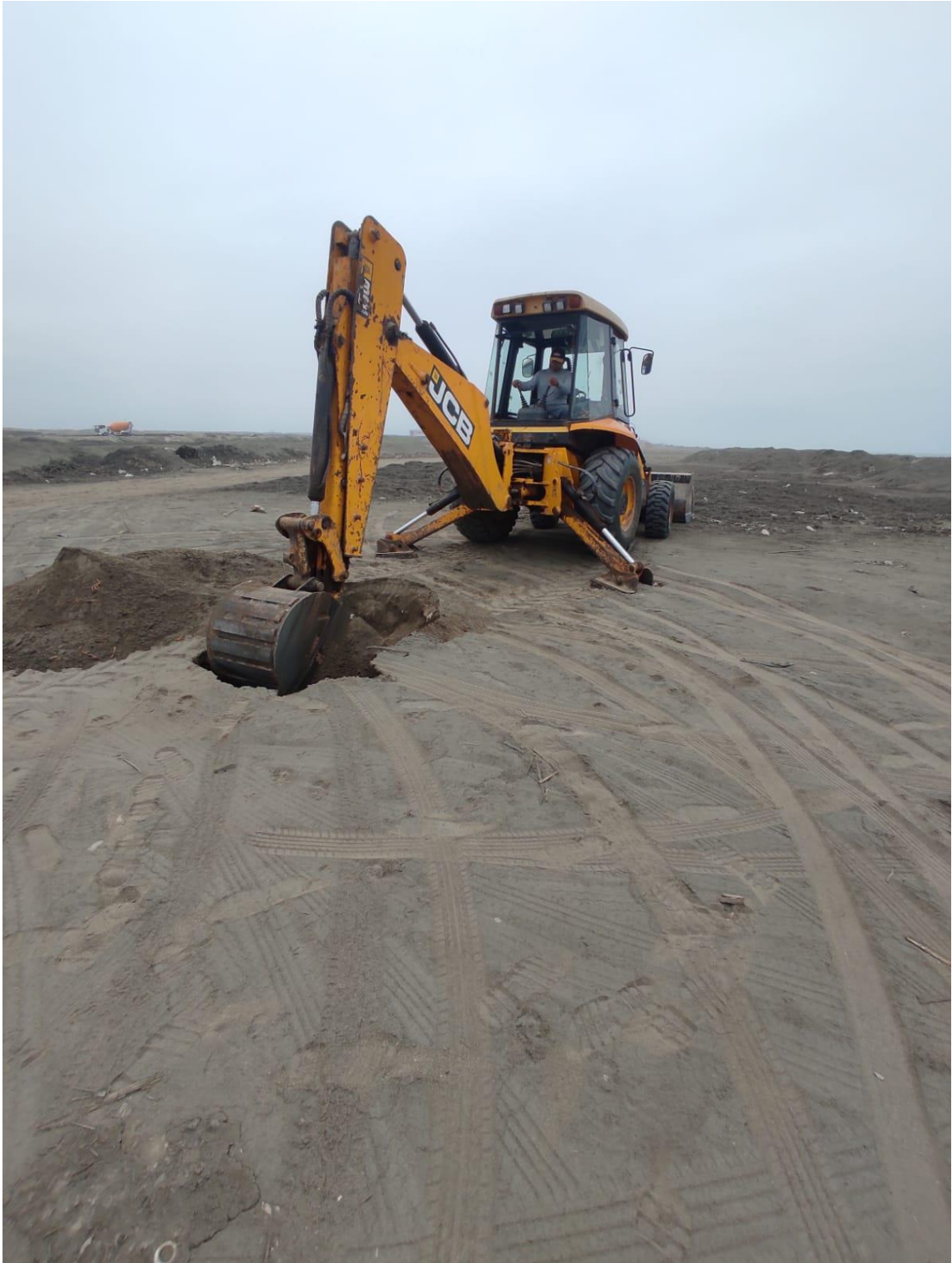
Imagen 51. Calicata - 14, progresiva 2+500 Km
