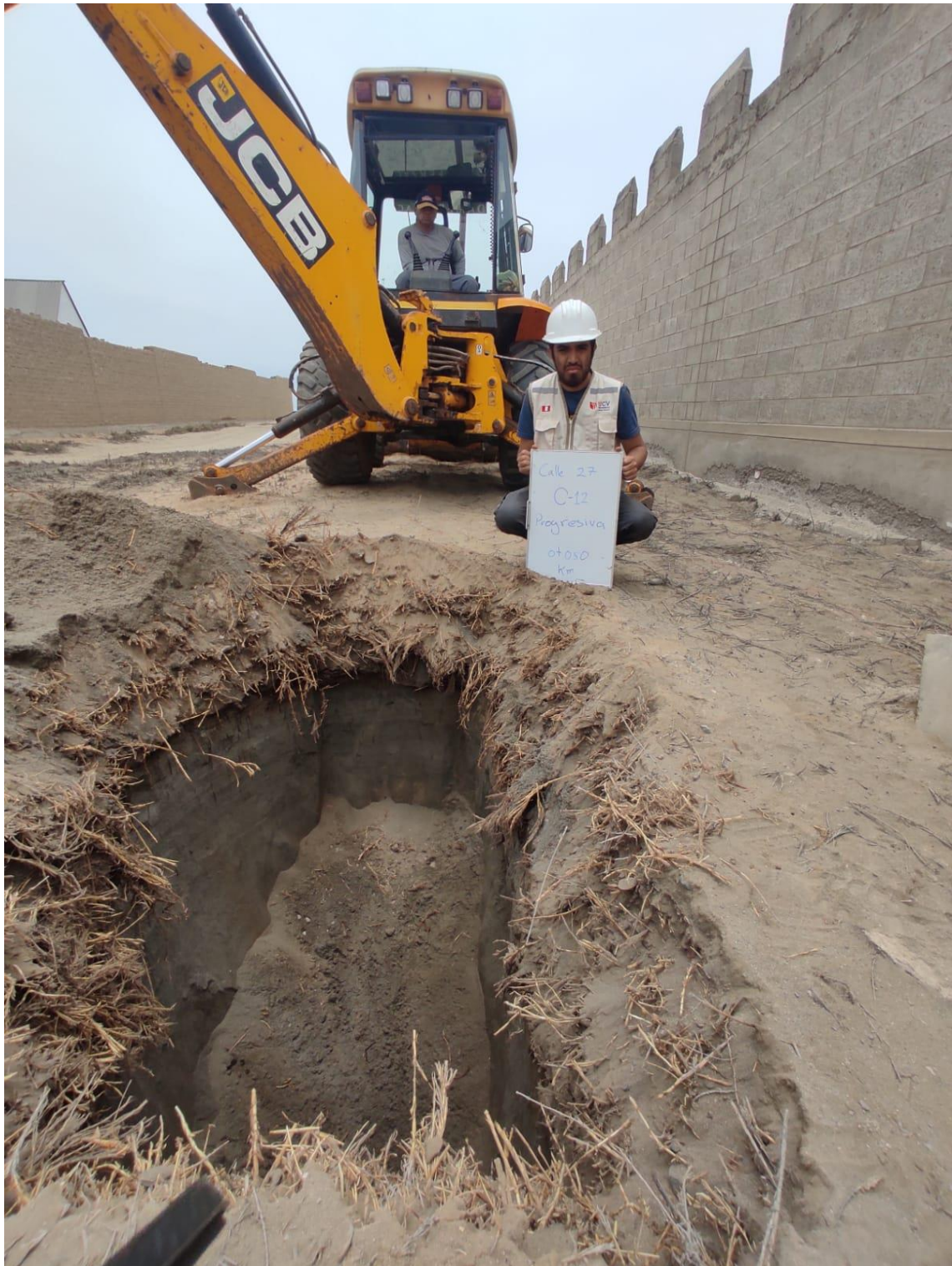
Imagen 43. Calicata - 12, progresiva 0+050 Km
