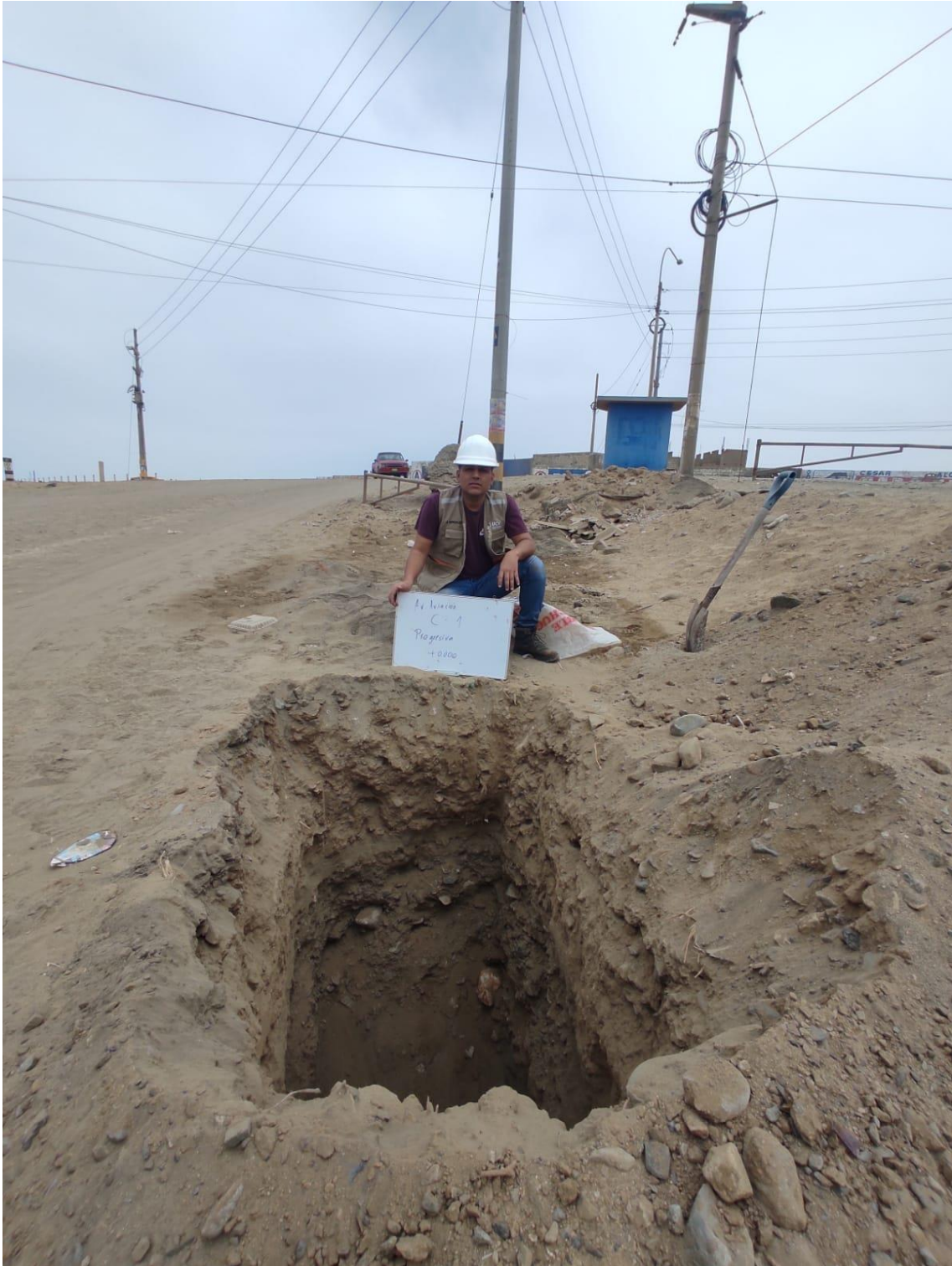
Imagen 4. Calicata - 01, progresiva 0+000 Km
