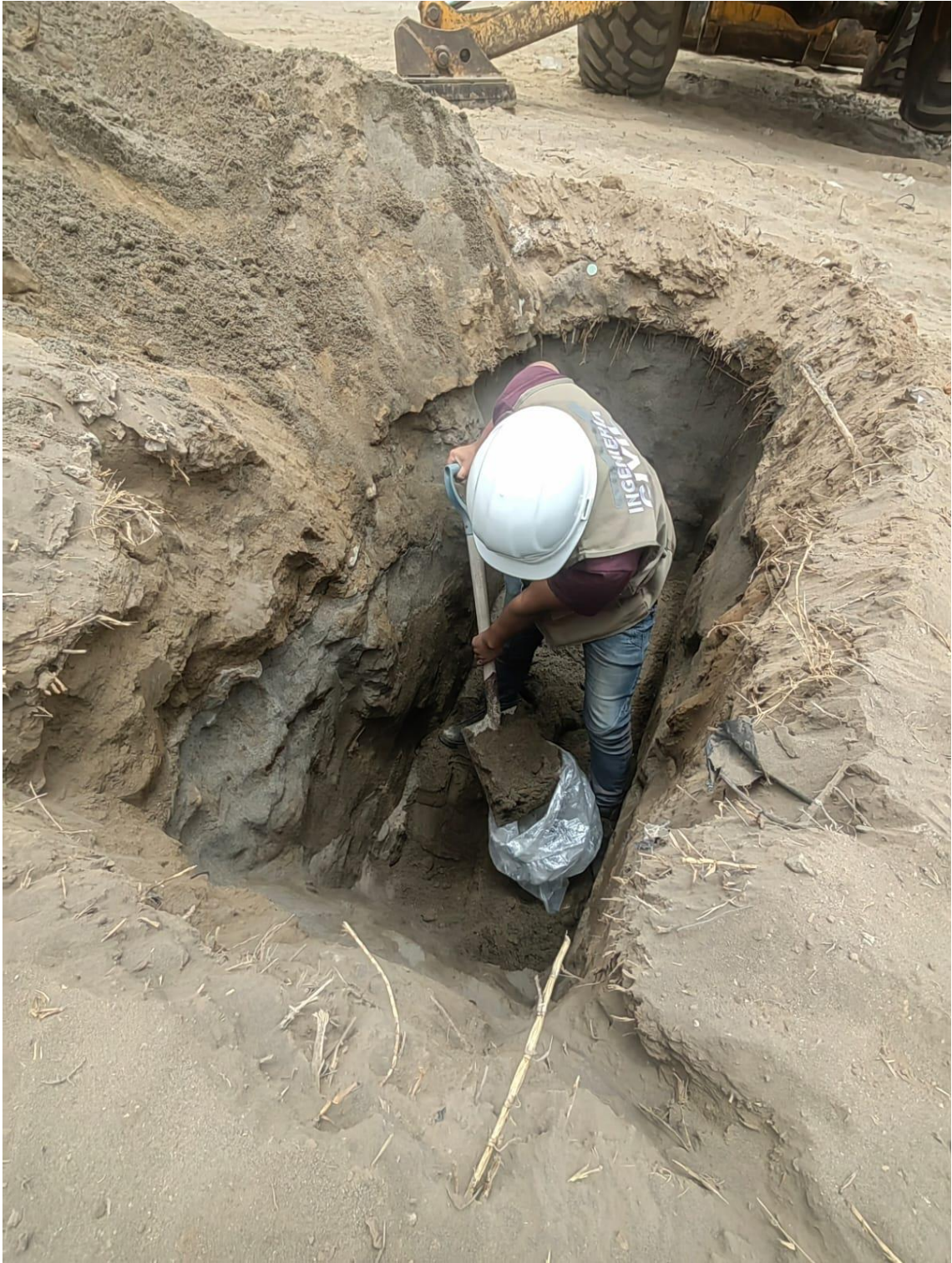
Imagen 41. Calicata - 11, progresiva 1+500 Km
