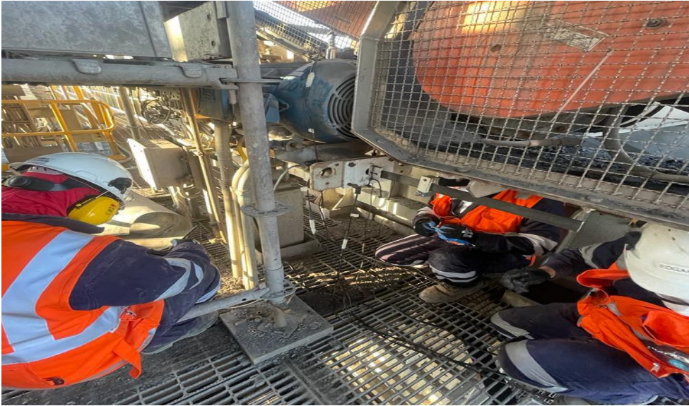
Figura 8: Ejecución de pruebas - vibrotechnology
