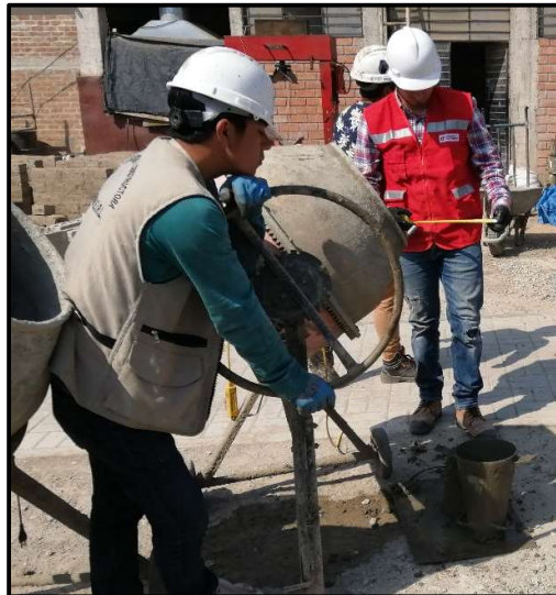
Figura 25. Mezclado de material para diseño de mezcla
