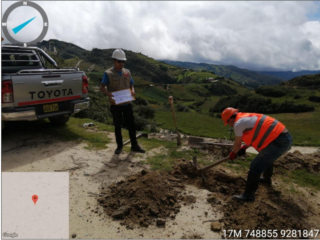
Figura 9. Elaboración de calicata N° 20
