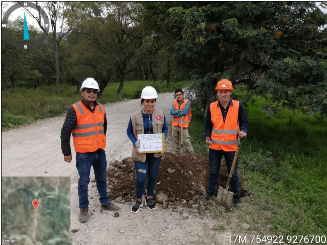
Figura 12. Elaboración de calicata N° 3
