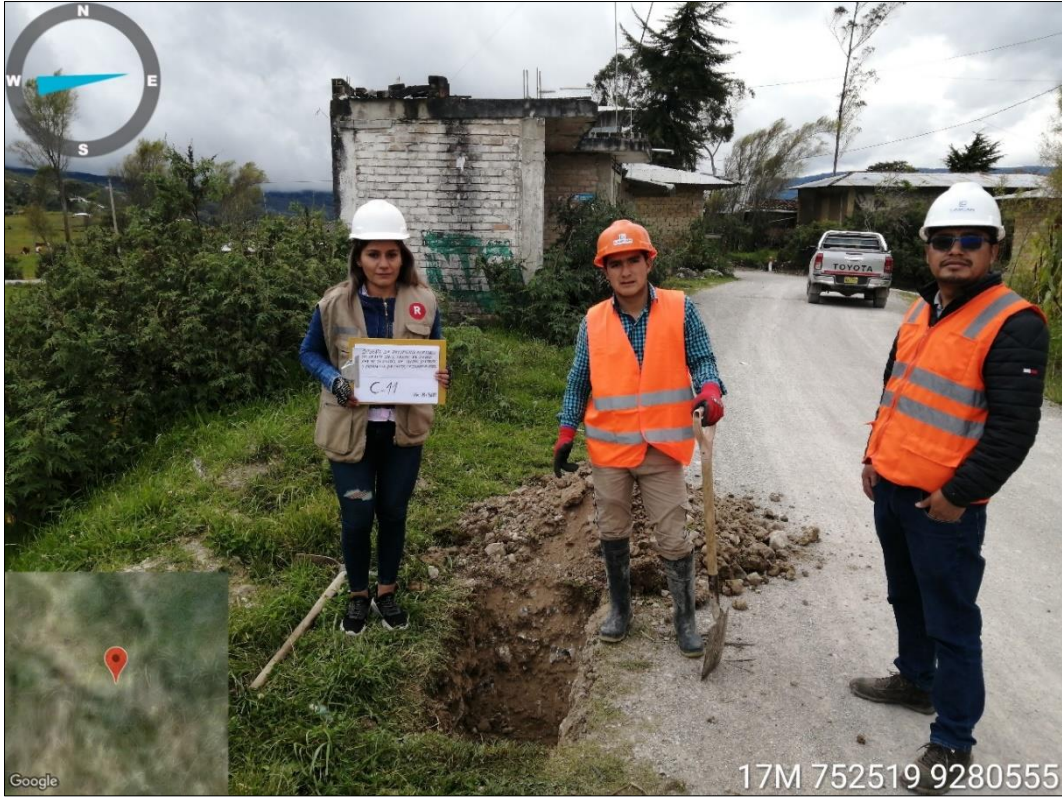
Figura 11. Elaboración de calicata N° 11
