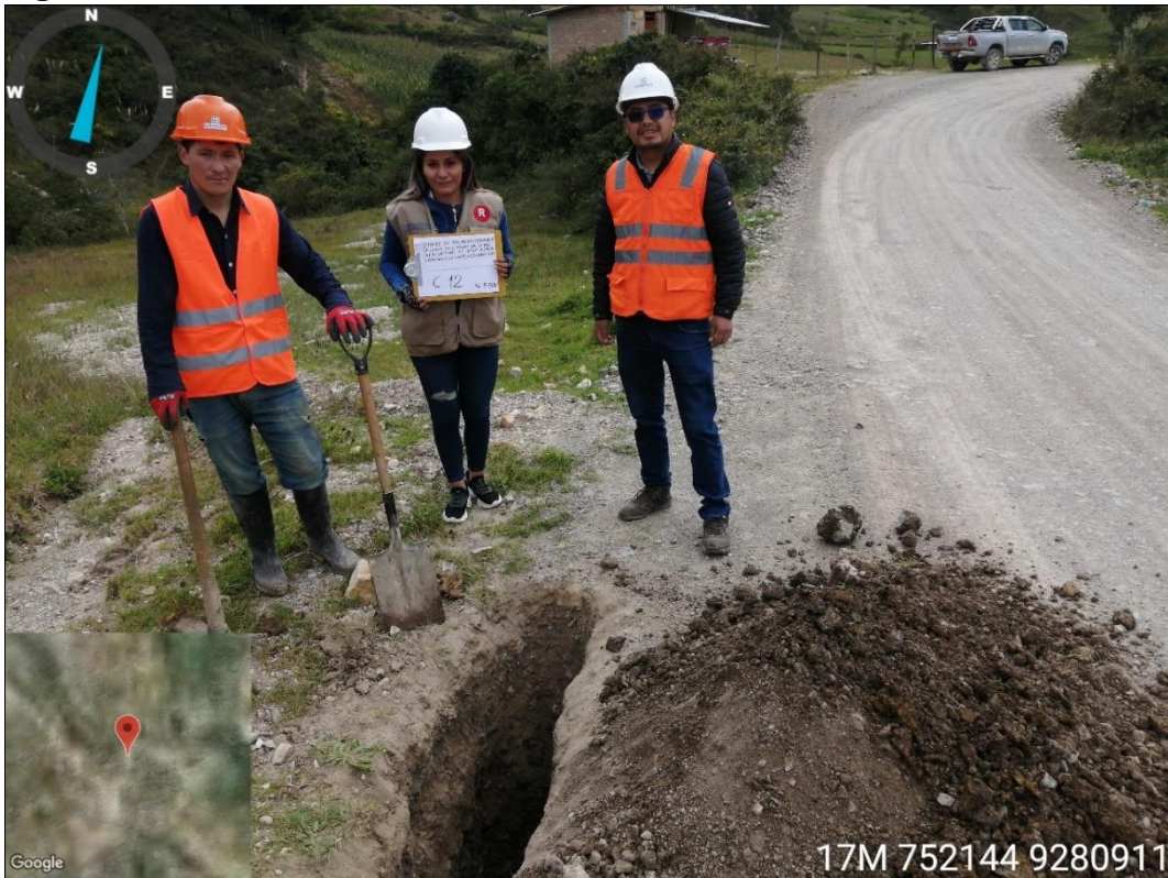
Figura 10. Elaboración de calicata N° 12
