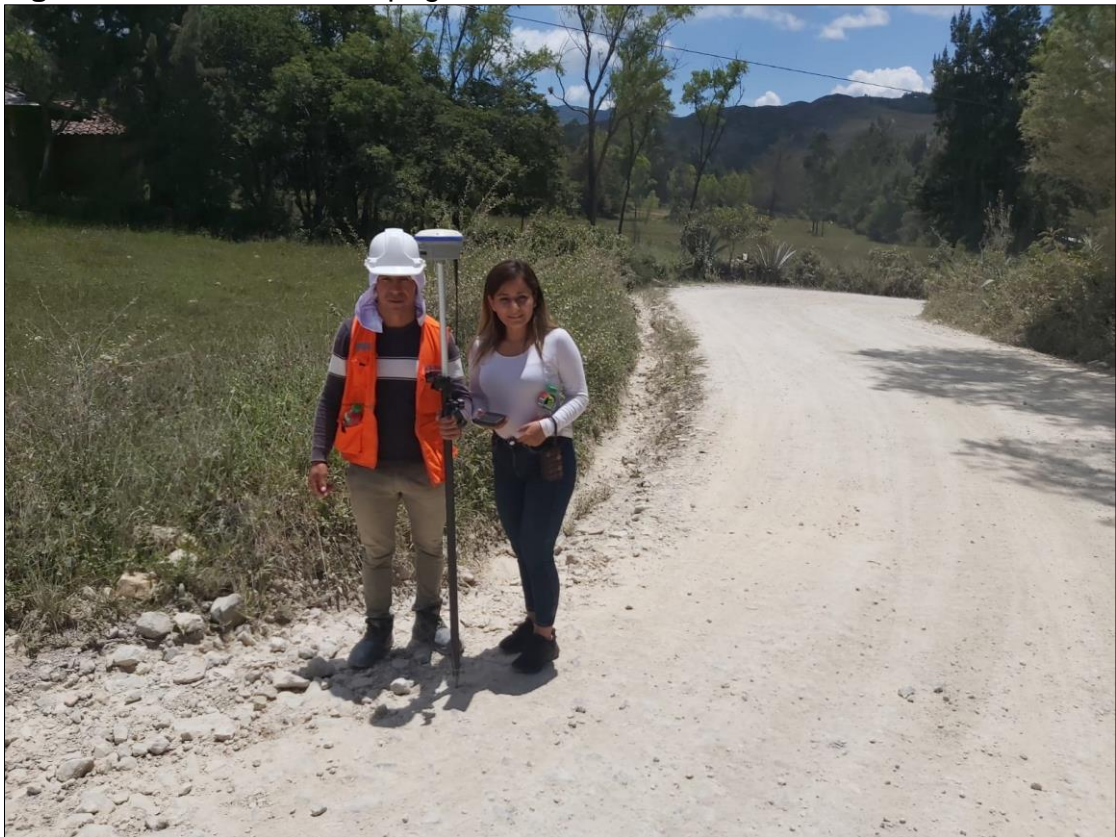
Figura 8. Levantamiento topográfico con GPS diferencial
