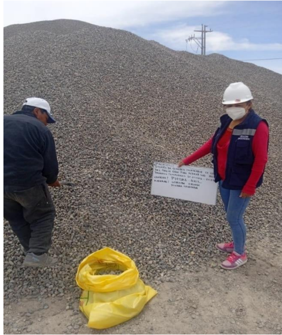
Fotografía 3: Muestreo y acopio de material en cantera “Piedra Azul”.
