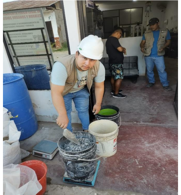
Pesado del material, arena fina, piedra \frac{3}{4} , piedra grava de \frac{1}{2} , cemento y agua para proceder a hacer 4 diseños de mezclas
