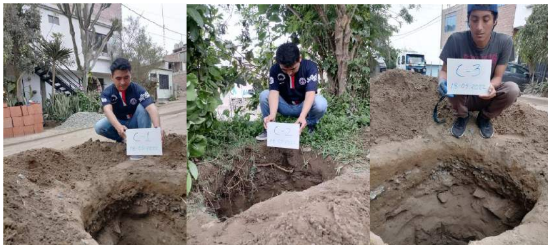
Figura N°17: Excavación de tres calicatas en la zona de estudio
