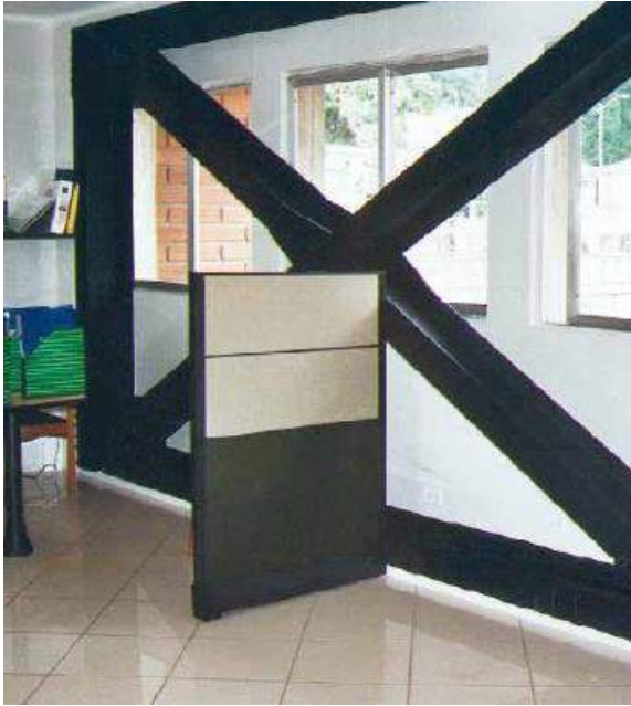
Figura 3. Marco metálico con conexión indirecta en edificio industrial.
