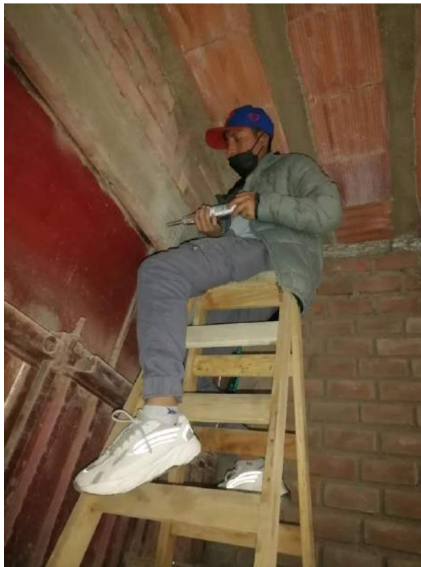
Vieri Zamudio realizando ensayo de esclerometría.
