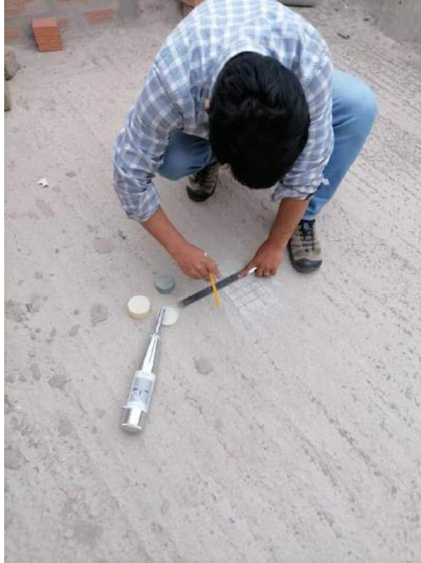
Franco Villalaz realizando ensayo de esclerometría.
