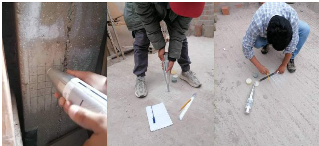
Figura N°18: Ejecución de ensayo de esclerometría
