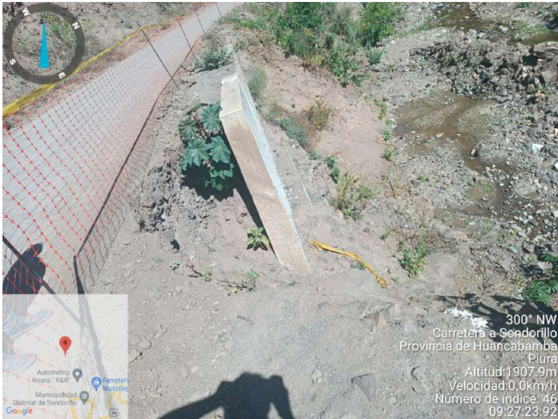
Figura 5. Inicio del Tramo de la Carretera
