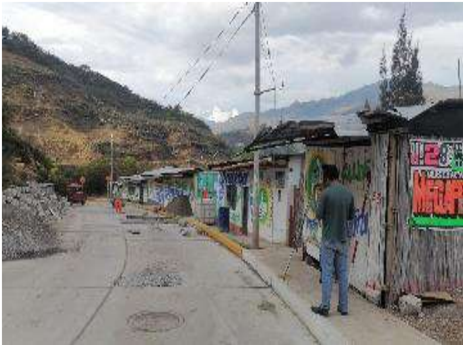
Ilustración 10 Posicionamiento de estación zona Sondorillo
