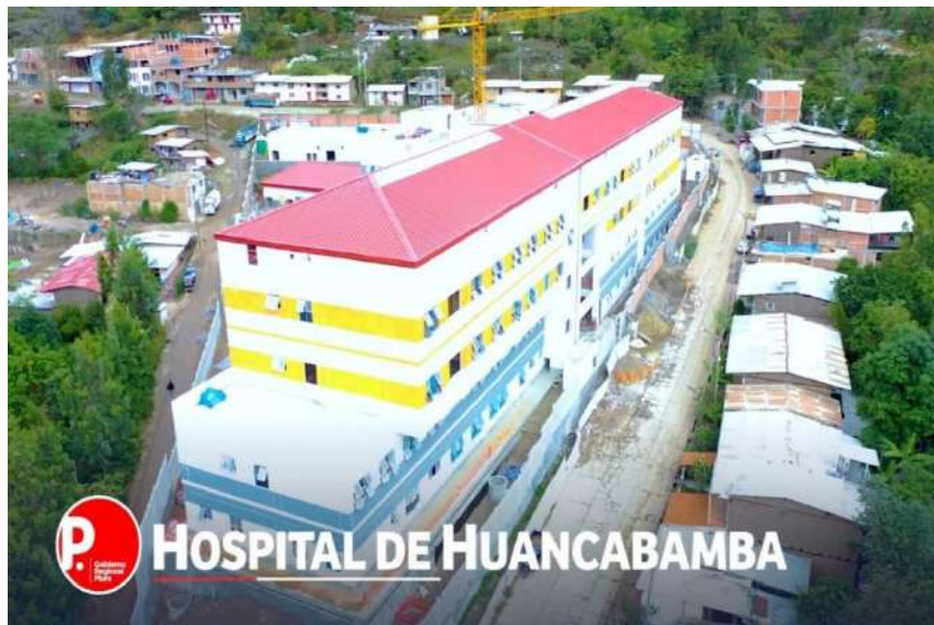
Ilustración 6 Hospital de Huancabamba
