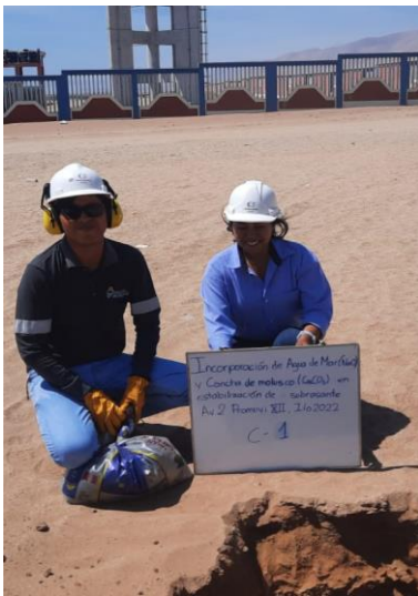
Figura 12. Excavación calicata n°1.
