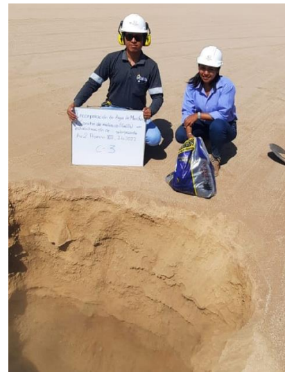
Figura 14. Excavación calicata n°3.
