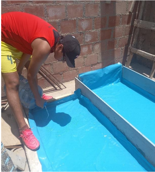
Fotografía 5. Colocación de agua de mar en plástico reforzado del investigador.
