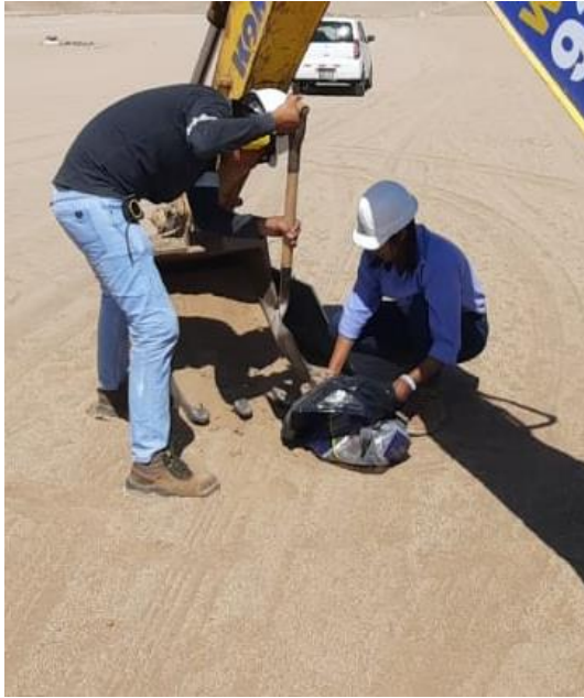
Fotografía 25. Extracción de suelo referente de la excavación de la Calicata 02
