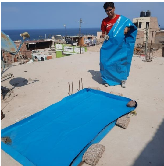
Fotografía 3. Fabricación de piscina provisional para la colocación de agua de mar.
