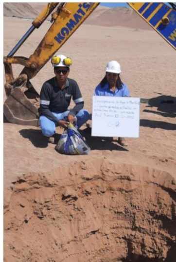
Figura 13. Excavación calicata n°2.
