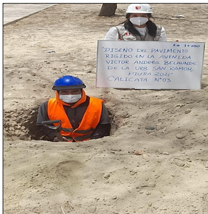
Figura 41. Calicata N° 03 – Km 1+050
