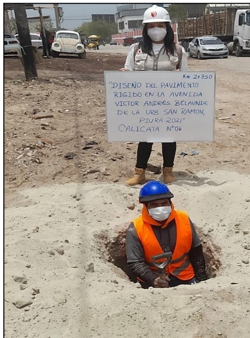
Figura 44. Calicata N° 06 – Km 2+850
