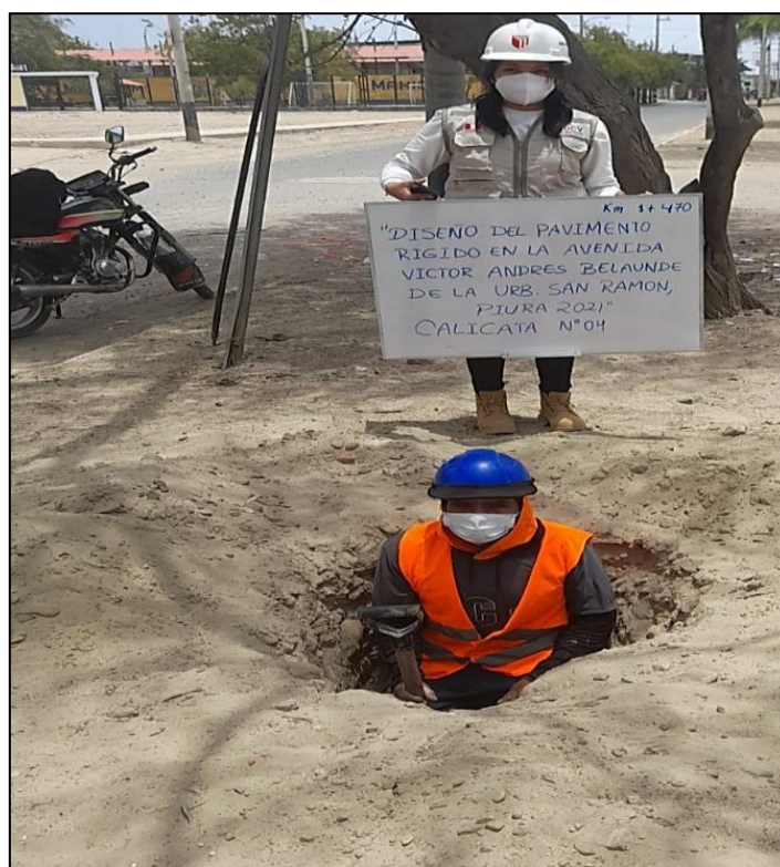
Figura 42. Calicata N° 04 – Km 1+470
