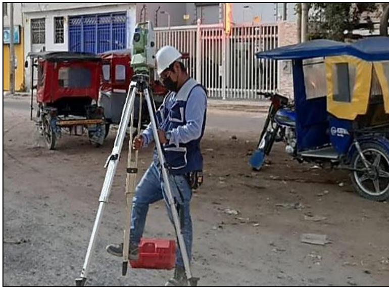
Figura 34. Se observa al operador del equipo realizando el debido levantamiento topográfico en la Avenida Víctor Andrés Belaunde – Urb. San Ramón
