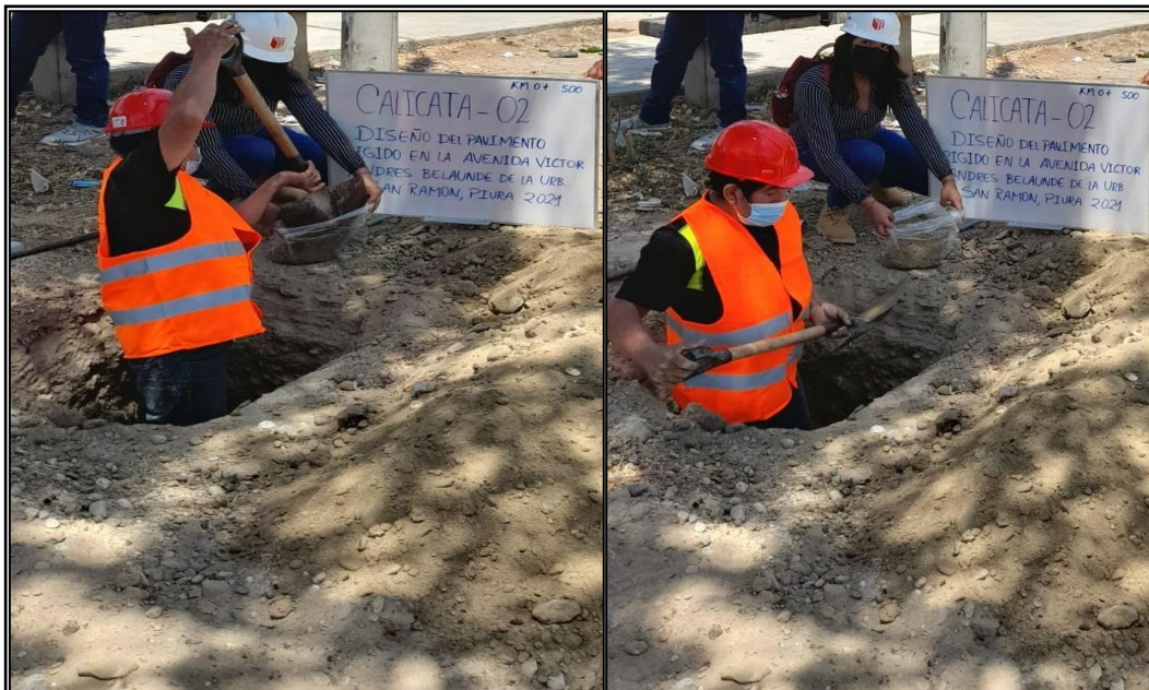
Figura 40. Calicata N° 02 – Km 00+500
