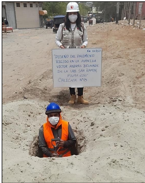
Figura 43. Calicata N° 05 – Km 1+850
