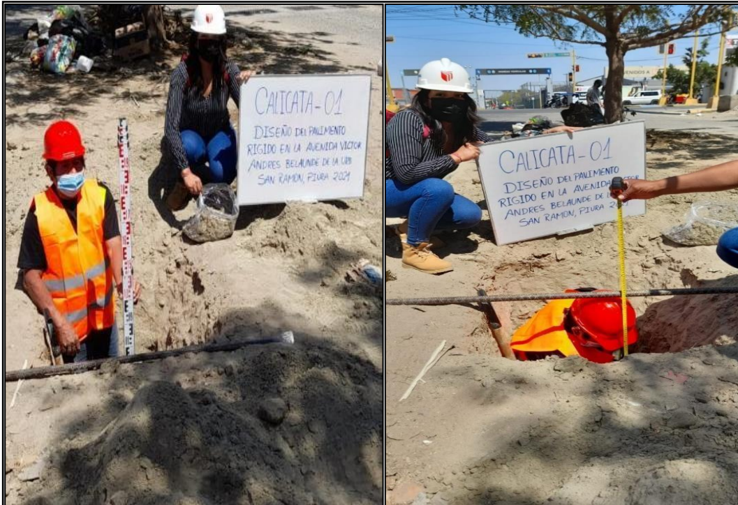
Figura 39. Calicata N° 01 – Km 00+210
