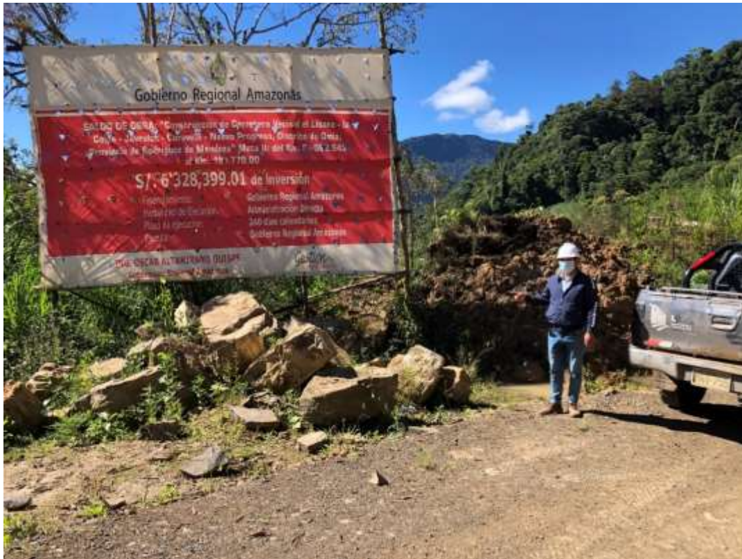
ANEXO 03: Cartel de la obra Camino vecinal El Líbano - Nuevo Progreso.
