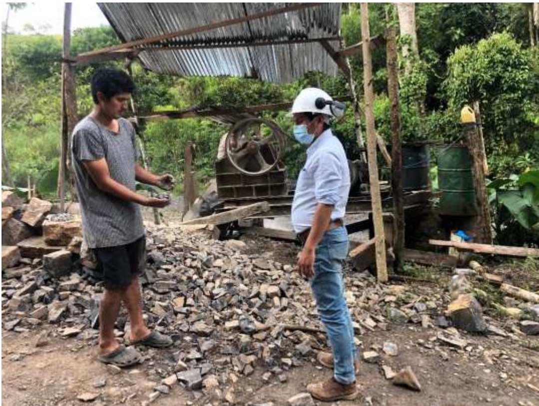
ANEXO 04: Planta de agregados, chancadora tipo quijada.
