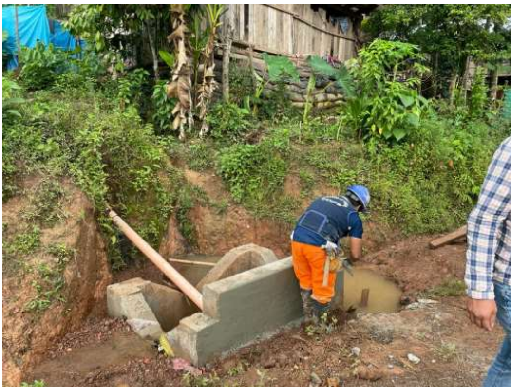
ANEXO 07: construcción de aliviaderos en el camino vecinal El Líbano - Nuevo Progreso.
