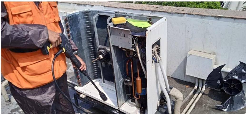
Figura 17. Limpieza de la UC con agua a presión
