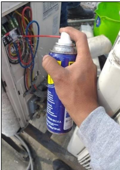
Figura 8. Aplicación de limpia contacto
