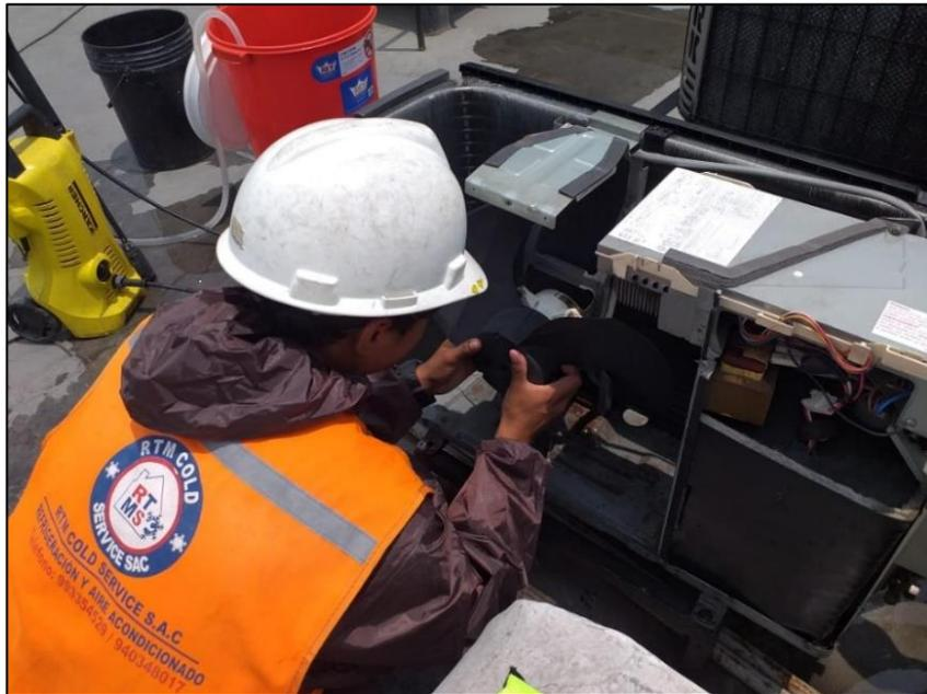
*Figura 9. Desmontaje del motor ventilador*
