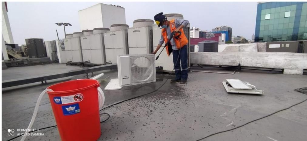
*Figura 10. Limpieza con agua a presión*
