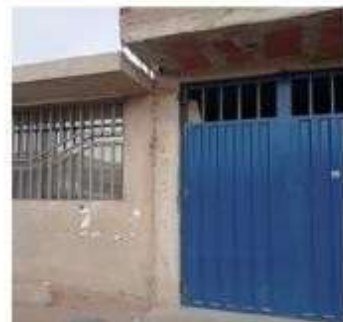
Losas de techos a desnivel
