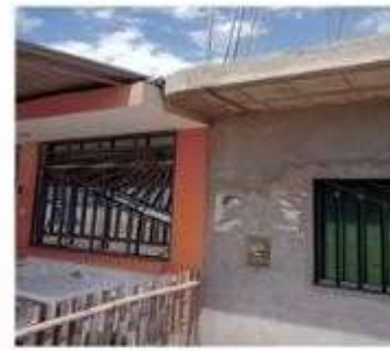
Losas de techos a desnivel
