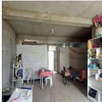
Vista de las características de las vigas
