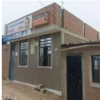
Ladrillo sin cocer como muro portante
