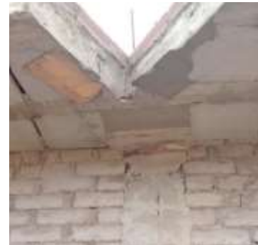
Presencia de cangrejeras en columna
