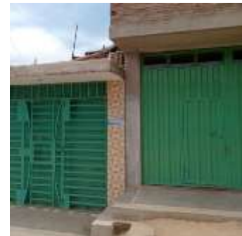
Presencia de techos a desnivel
