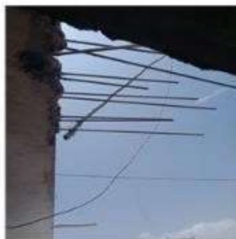
Aceros expuestos para proyección de escalera
