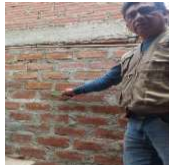
Junta de asentado de ladrillo mayor a 1.5 cm
