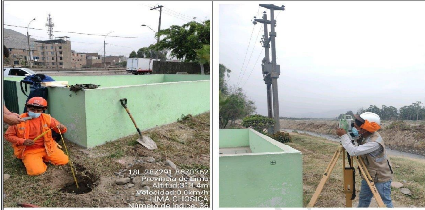
Foto N°01: Vista de las actividades de un levantamiento topográfico (insertar puntos de control topográfico)
