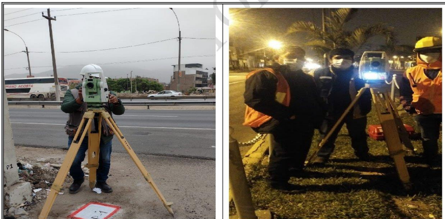
Foto N°03: Vista de las actividades de un levantamiento topográfico (levantamiento topográfico detallado de la avenida los cisnes)
