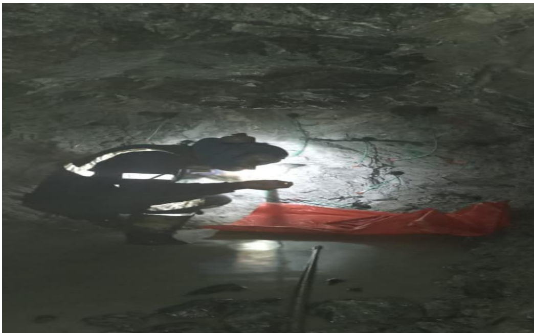
Figura 13: Colocación de explosivos en los taladros del frente de la labor
