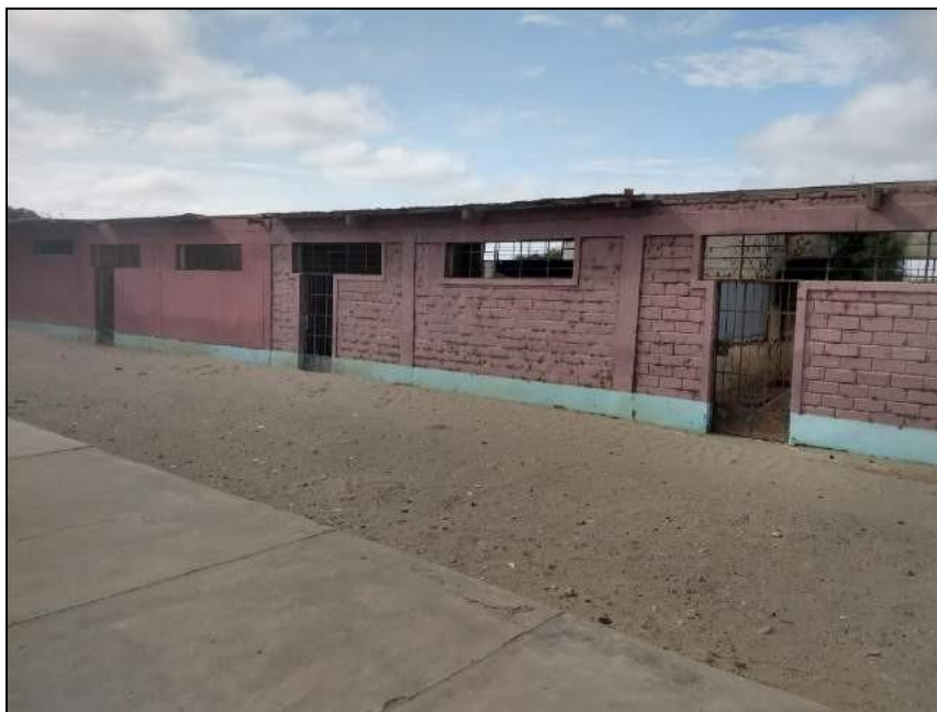
Foto 1: Infraestructura existente en la IE N° 14055 del CP Chato Chico, edificación 2.
