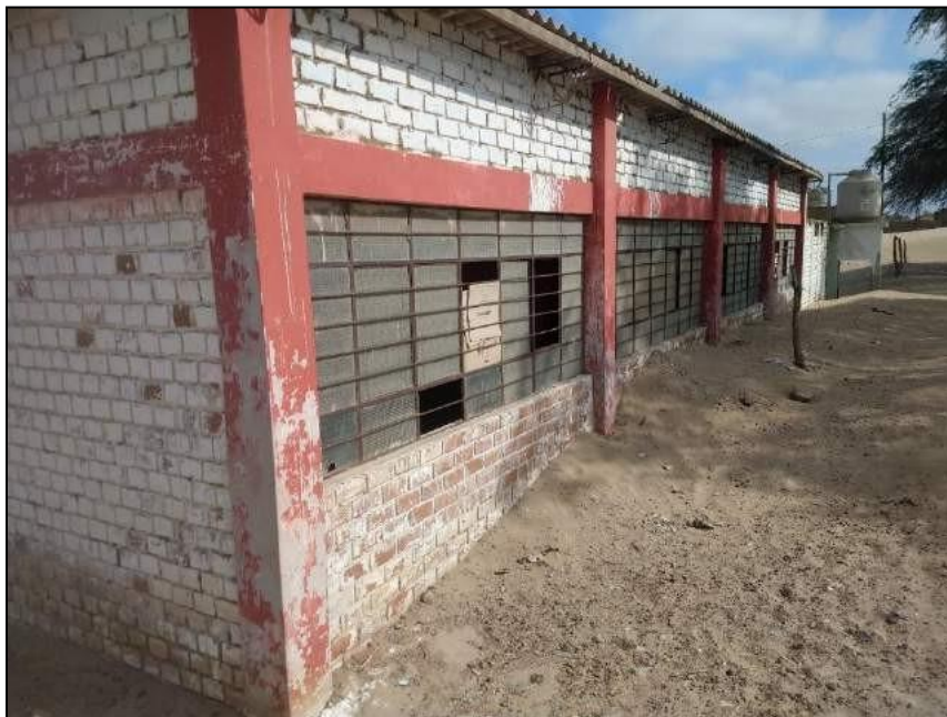
Foto 2: Infraestructura existente en la IE N° 14055 del CP Chato Chico, edificación 3.
