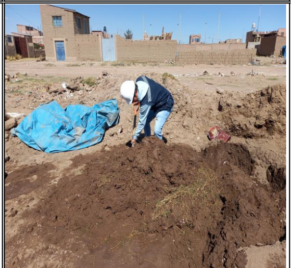
AMASADO DEL BARRO CON ADICIONAMIENTO DE TOTORILLA
