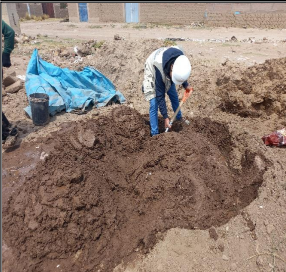
PREPARACION Y AMASADO DE SUELO DE CANTERA PARA LA ELABORACION DE ADOBE
