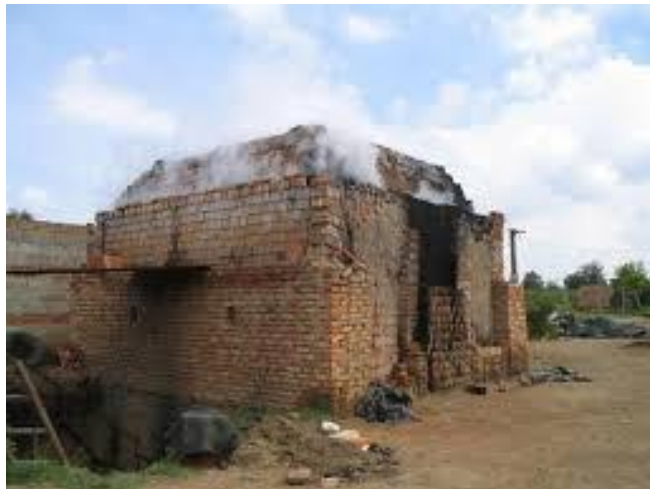
Figura 9: Horno para el quemado del ladrillo artesanal
