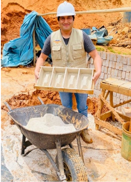
Foto 09: Los moldes a usar para fabricar el ladrillo.
