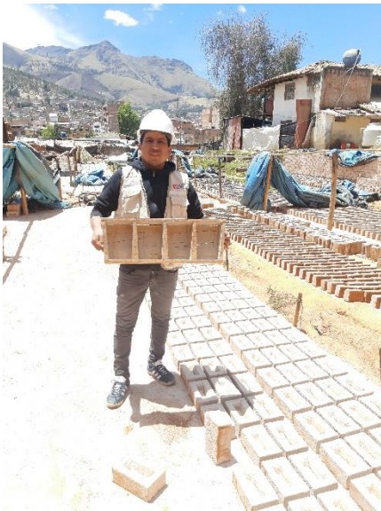
Figura 16: Molde de madera para el ladrillo.
