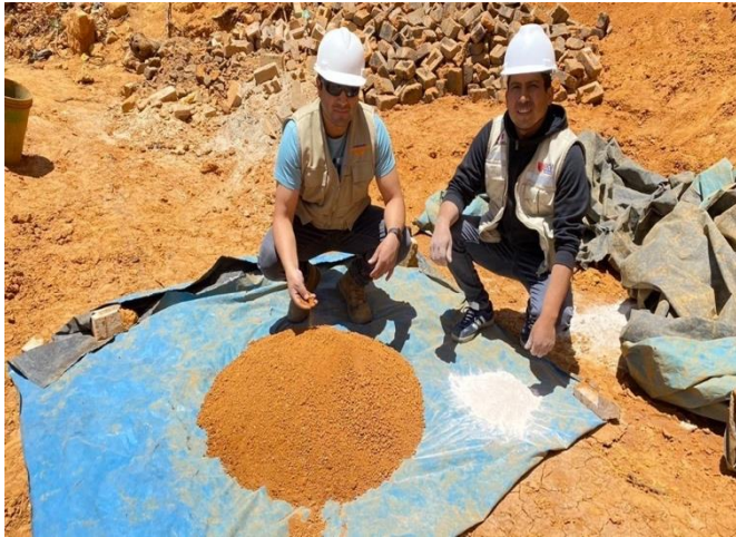
Foto 05: Adicionando el 3% del polvo de caparazón de cangrejo.
