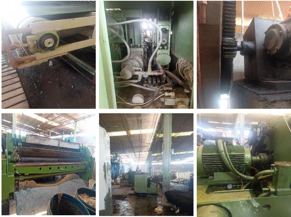
Figura 50: Limpieza, inspección y ajustes.
