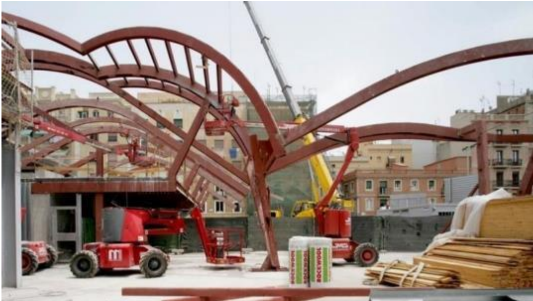
Figura 34. Estructura portante del Mercado La Barceloneta, España
