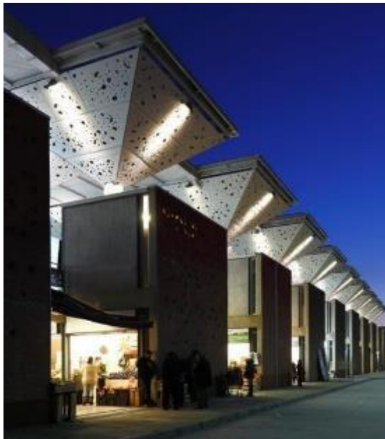
Figura 43. Vista lateral del Mercado Tirso de Molina, Chile
