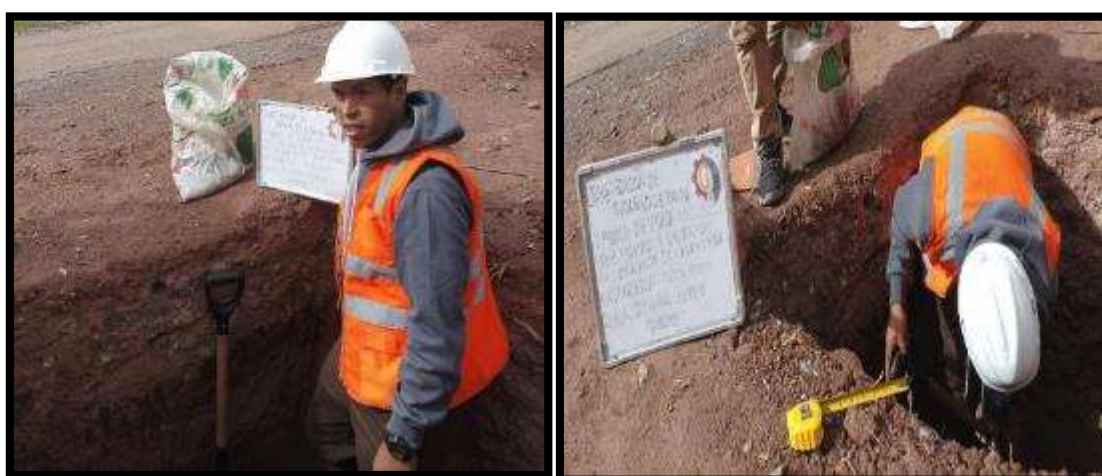
Figura 12: Extracción de muestras de suelo de calicatas.
