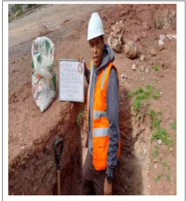
Ubicación y extracción de muestra de suelo de calicata.
