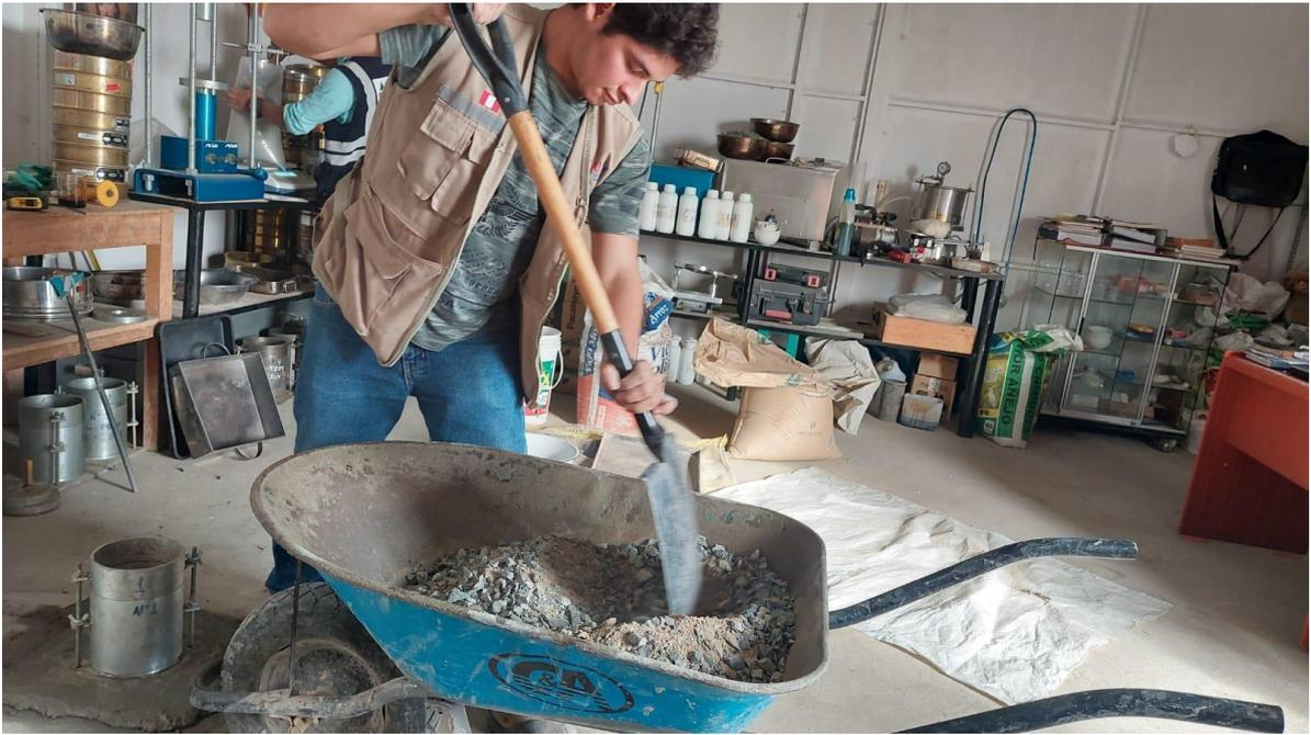
Foto 17. Adición de A.S.P. Euco 537 al mezclado manual para elaboración de concreto  $f'c = 210 \text{ kg/cm}^2$
