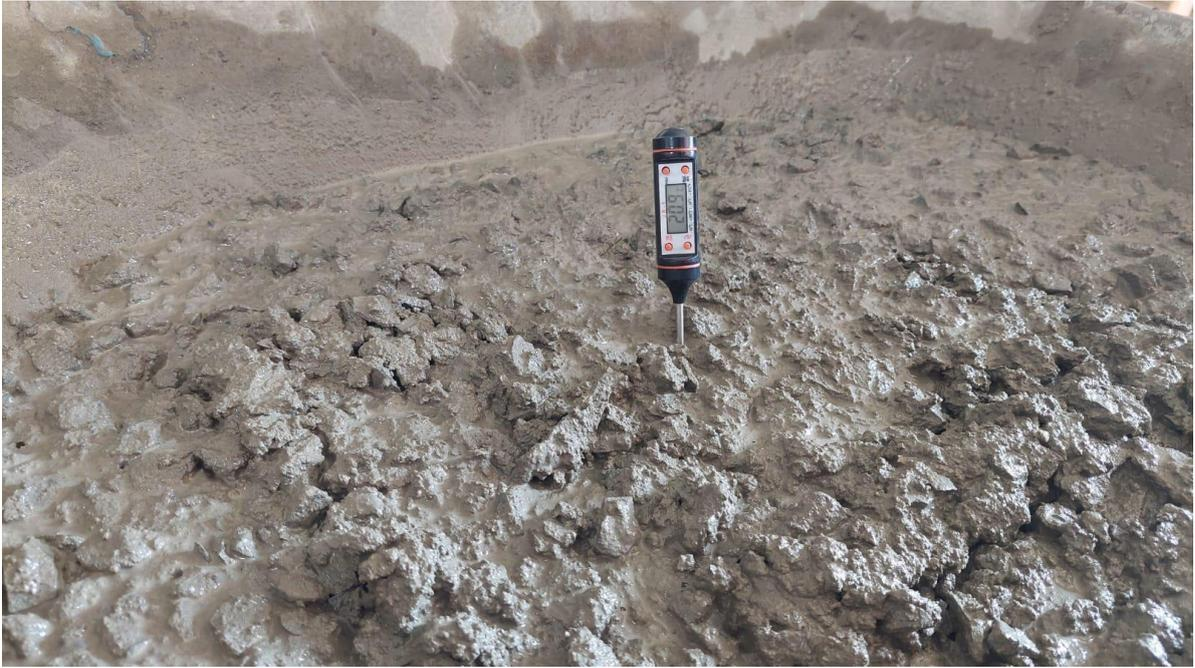
Foto 19. Toma de temperatura del concreto con aditivo de 0.8% Euco 537
