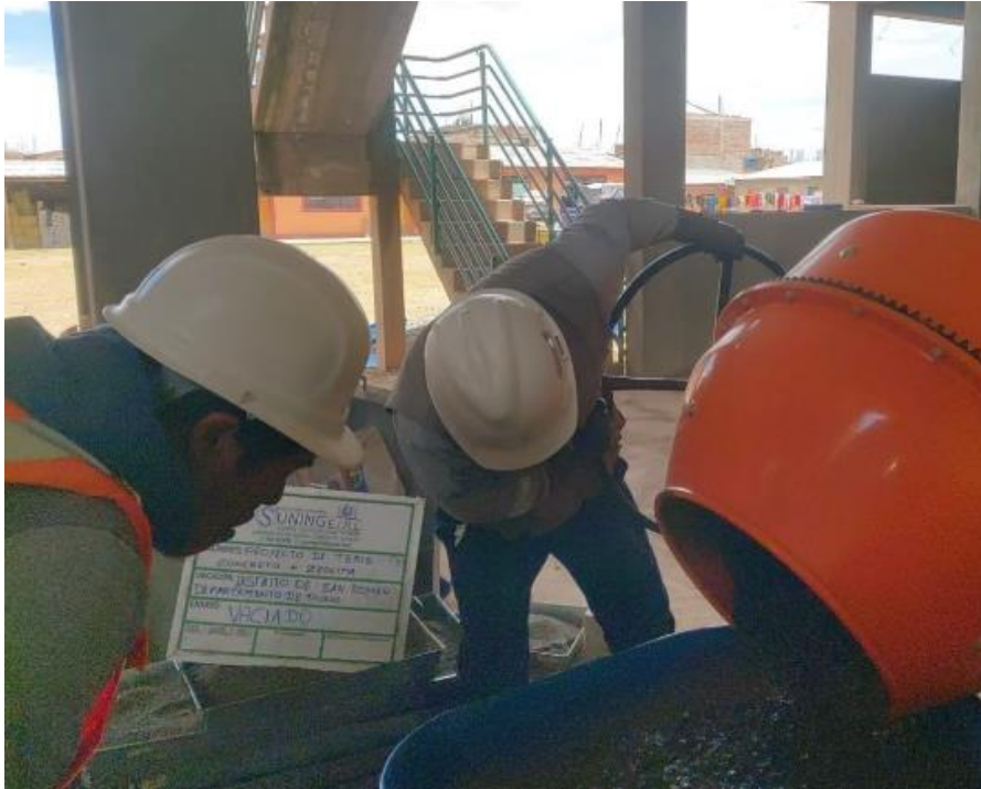
Fotografía 7 Vaciado de mezcla
