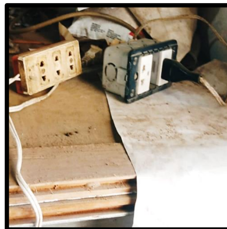
Figura 48. Cables expuestos
