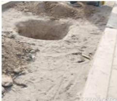
Figura 12: Calicata -3 Fuente Elaboración Propia.
