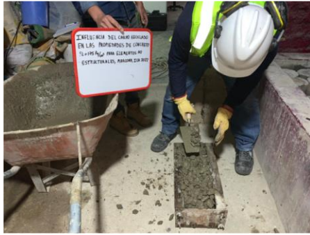
Figura 16. Elaboración de vigas.
