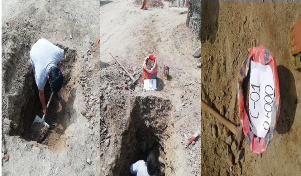
Figura 15. Trabajos de la calicata C-01.
