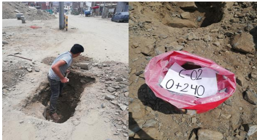
Figura 16. Trabajos de la calicata C-02.
