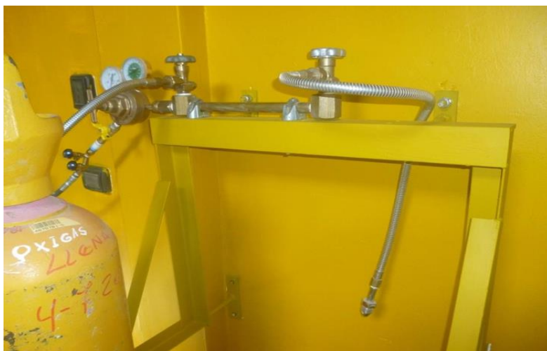
Ilustración 10: Equipos y tecnología en el servicio de recarga y mantenimiento de extintores
