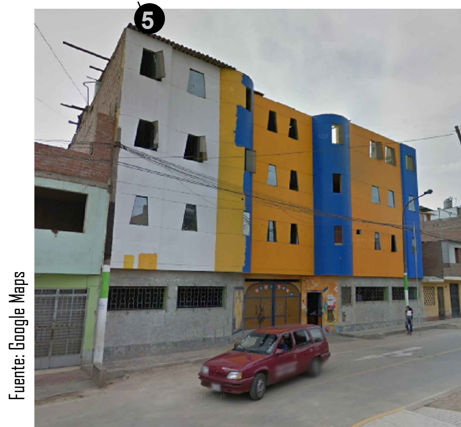
COLEGIO CRISTIANO CASTILLO DEL REY Ubicación: Sector 18 - VALLE DEL CHILLÓN
